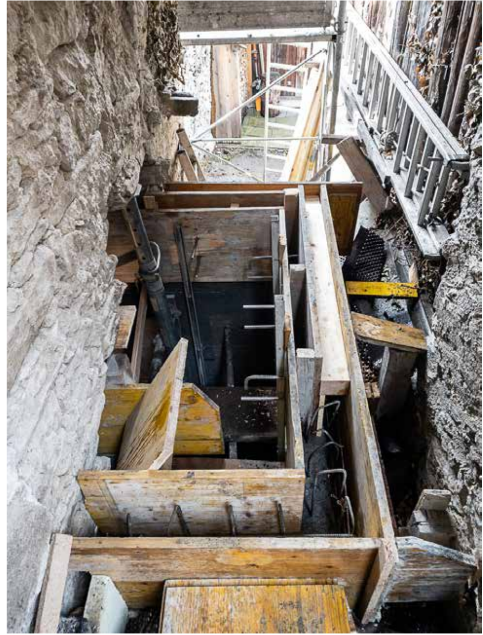
10.03.2023 – Betonieren der Annex Grundmauern auf Geschosshöhe
