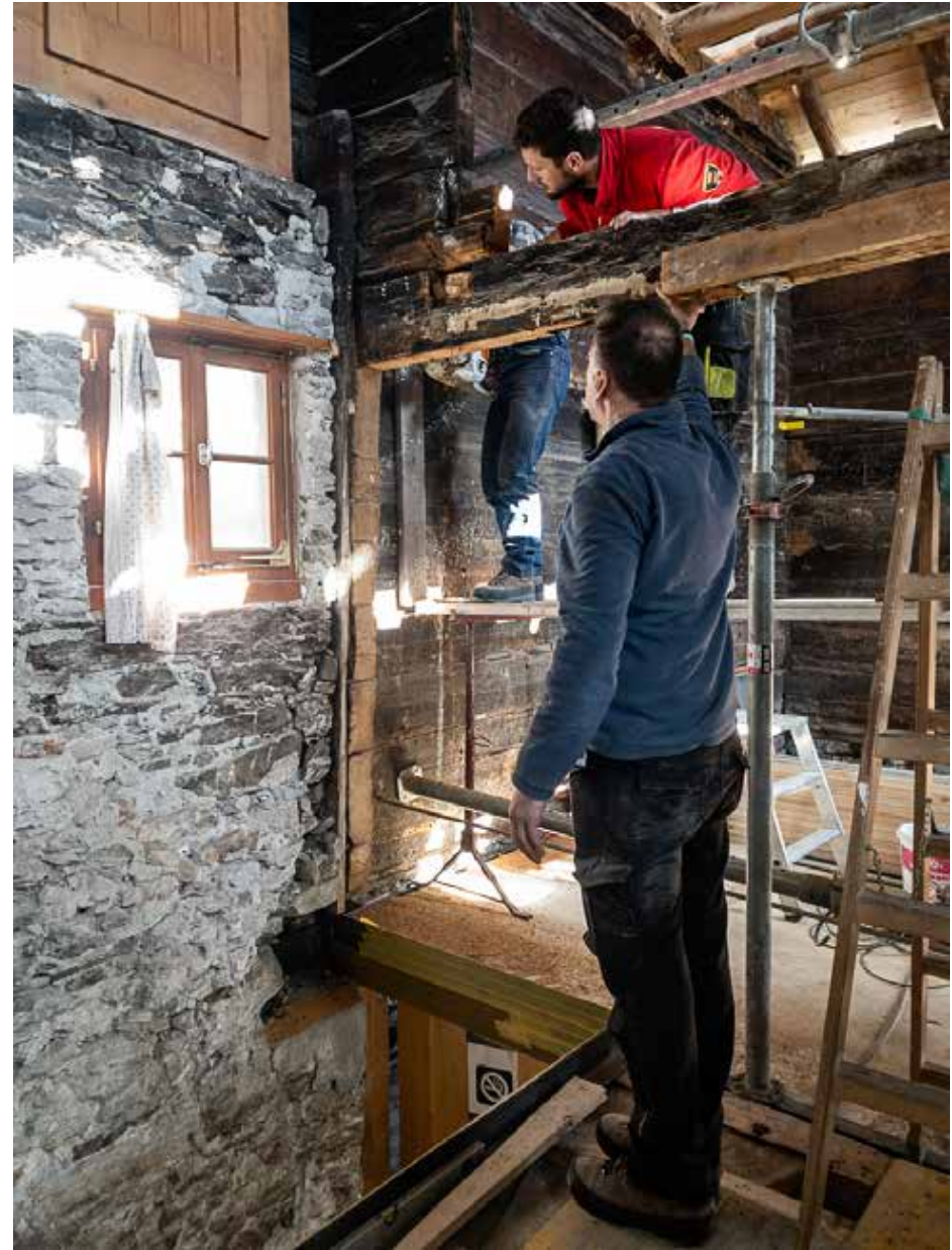
09.03.2023 – OG – Entfernen des alten Strickbalkens
