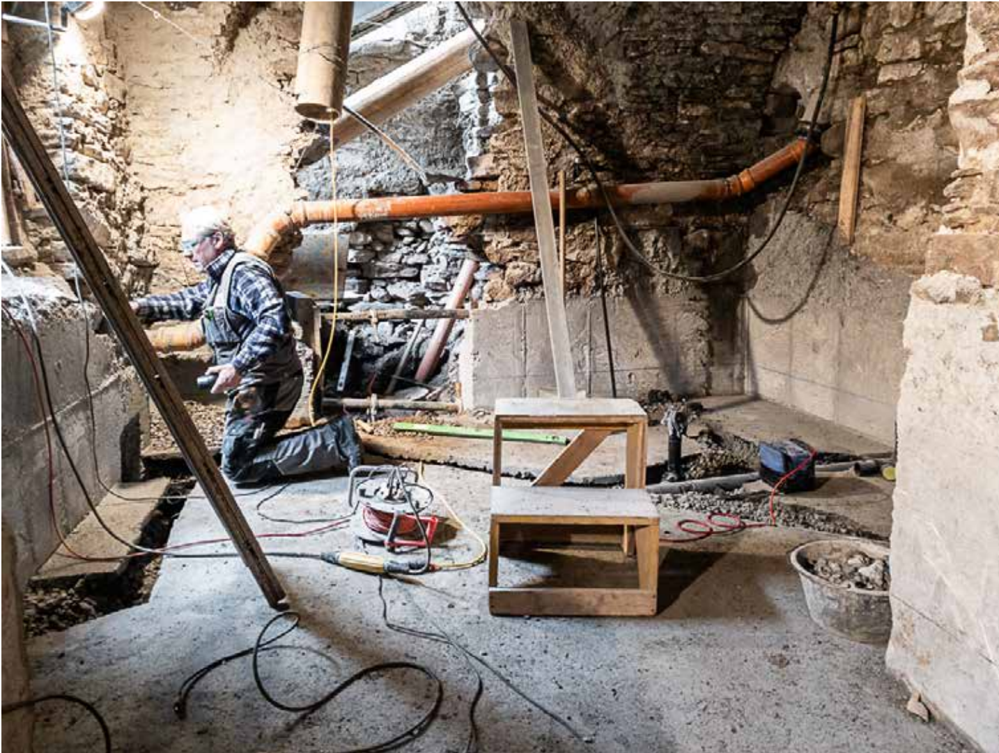
16.11.2022 – UG – Verlegung der Abwasserrohre
