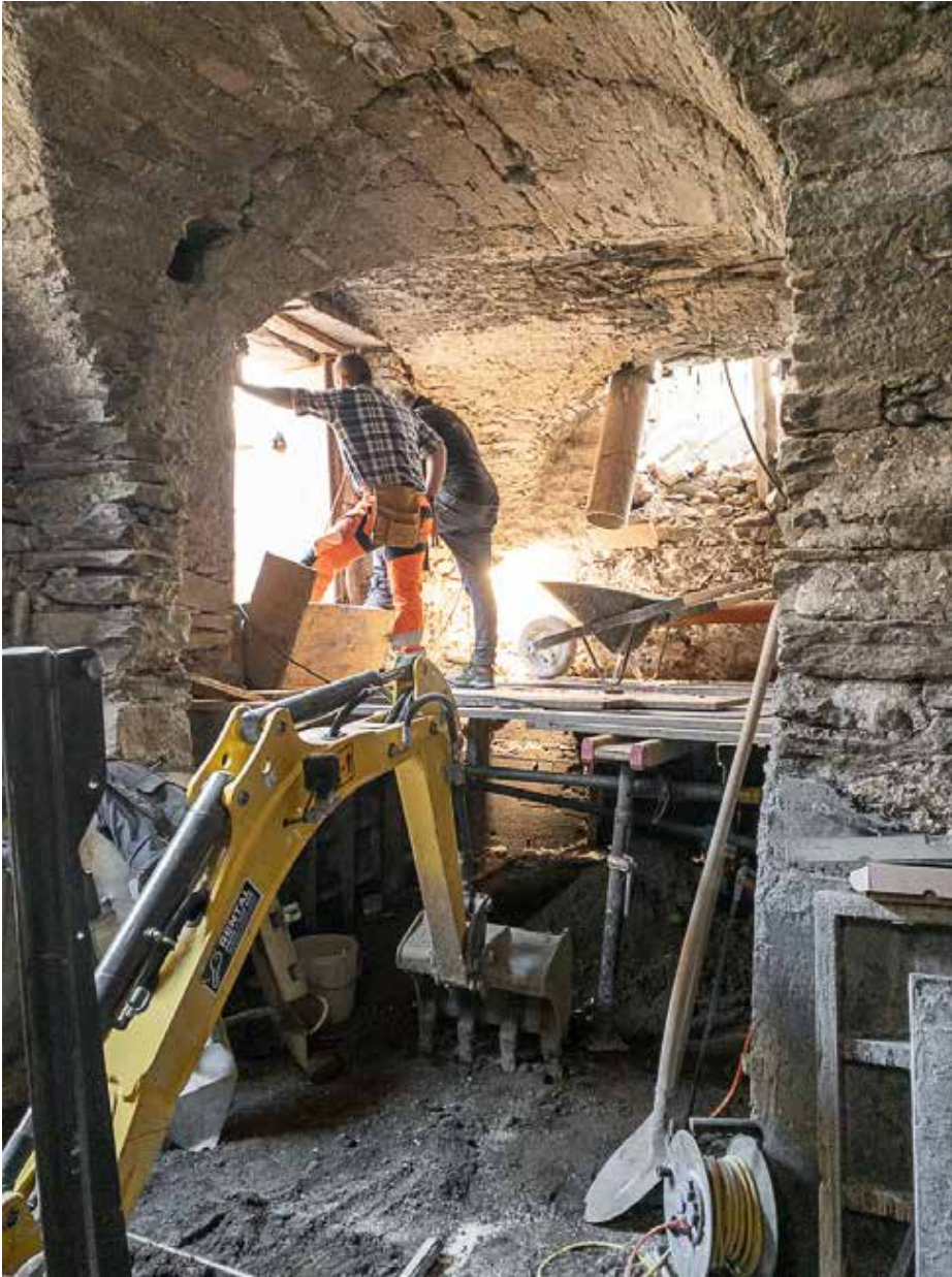
10.11.2022 – UG – Fertige Absenkung für den neuen Bodenaufbau
