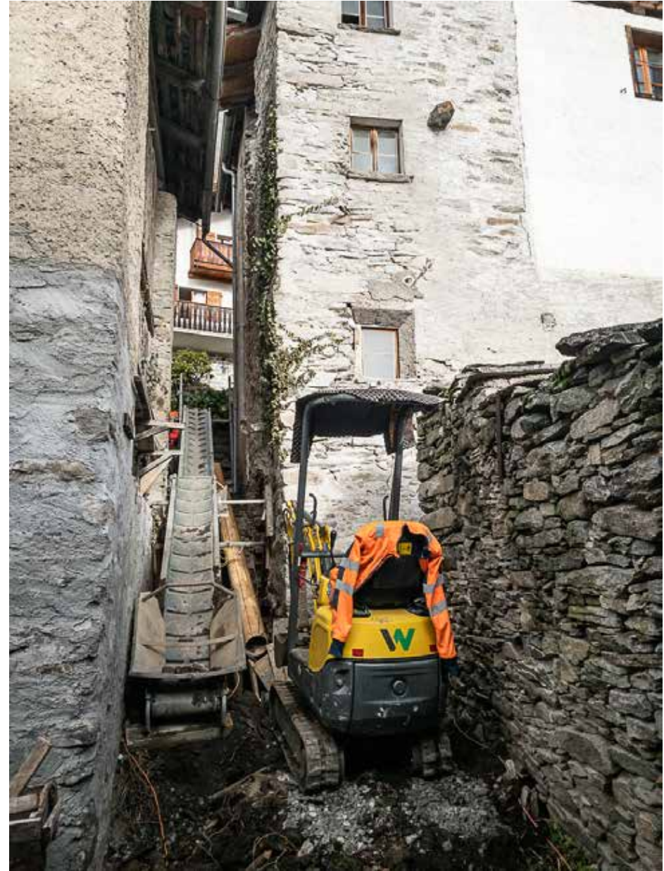
16.11.2022 – Beginn der äusseren Grabarbeiten
