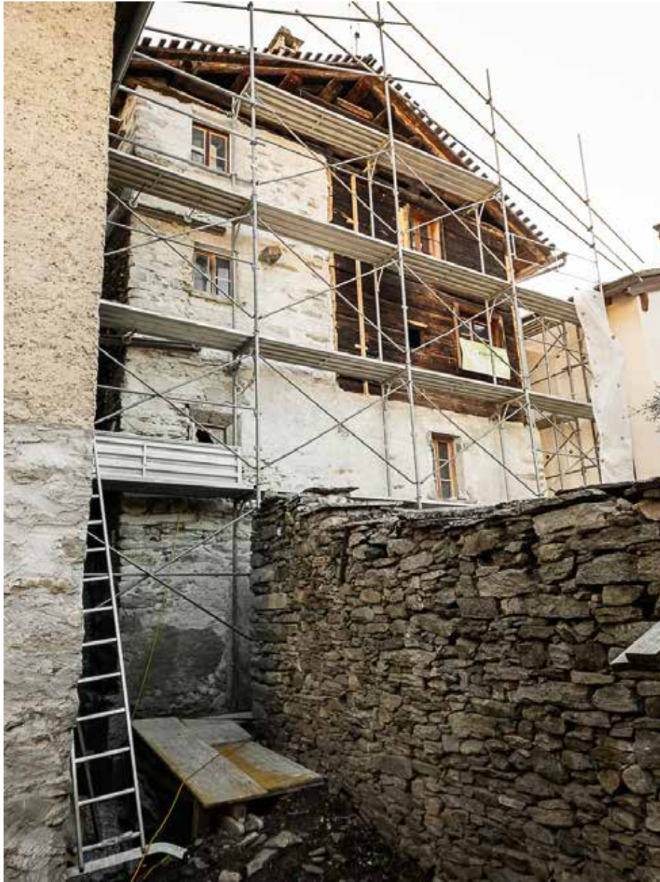
20.03.2023 – Süd-Fassade mit freigelegtem Strick
