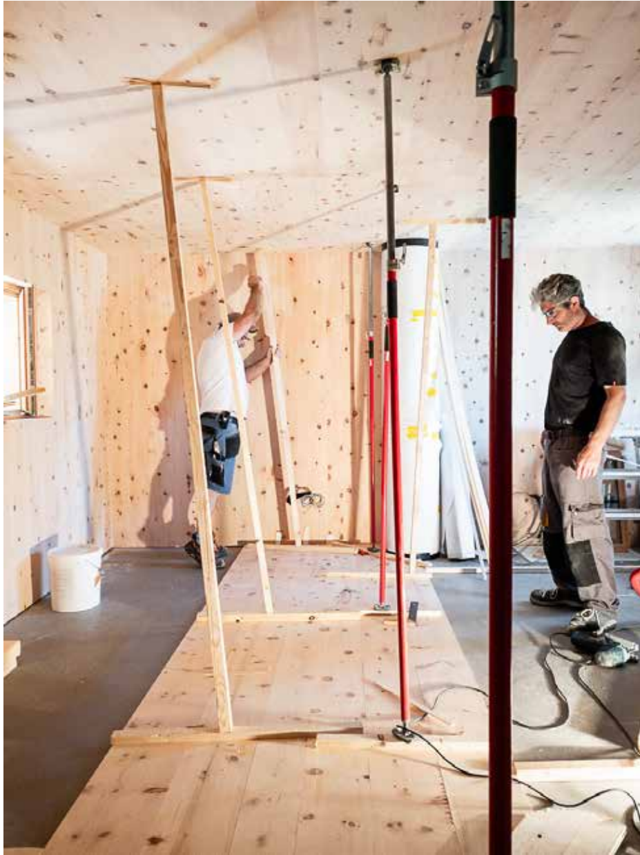
07.07.2023 - OG - Verlegen des Arvenbodens
