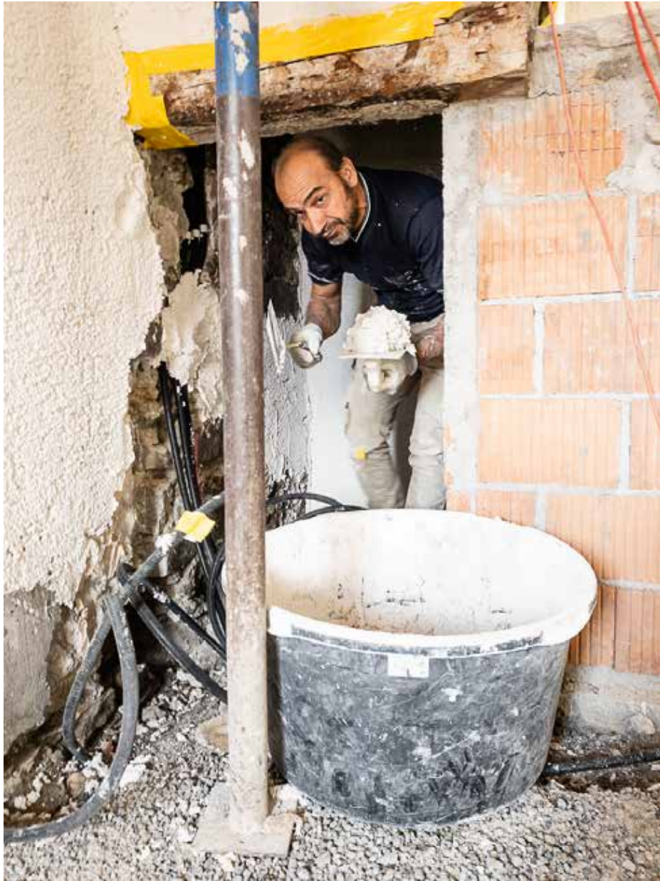
04.05.2023 – EG – Auftragen von Biotherm Wärmedämmputz
