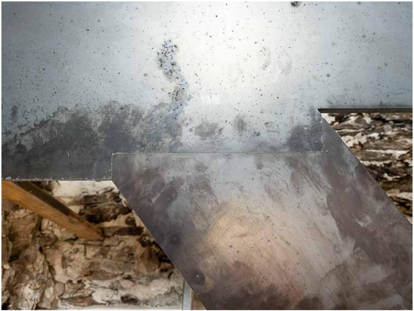
28.06.2023 - OG - Passgenaue Steckverbindung
