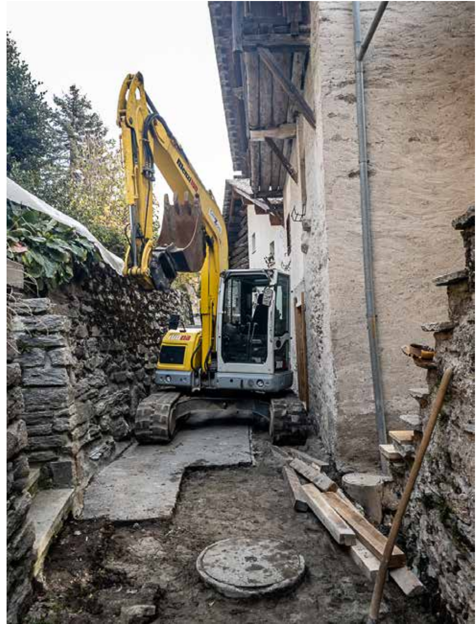
21.11.2022 – Beginn der Grabarbeiten der für Perimeterdämmung
