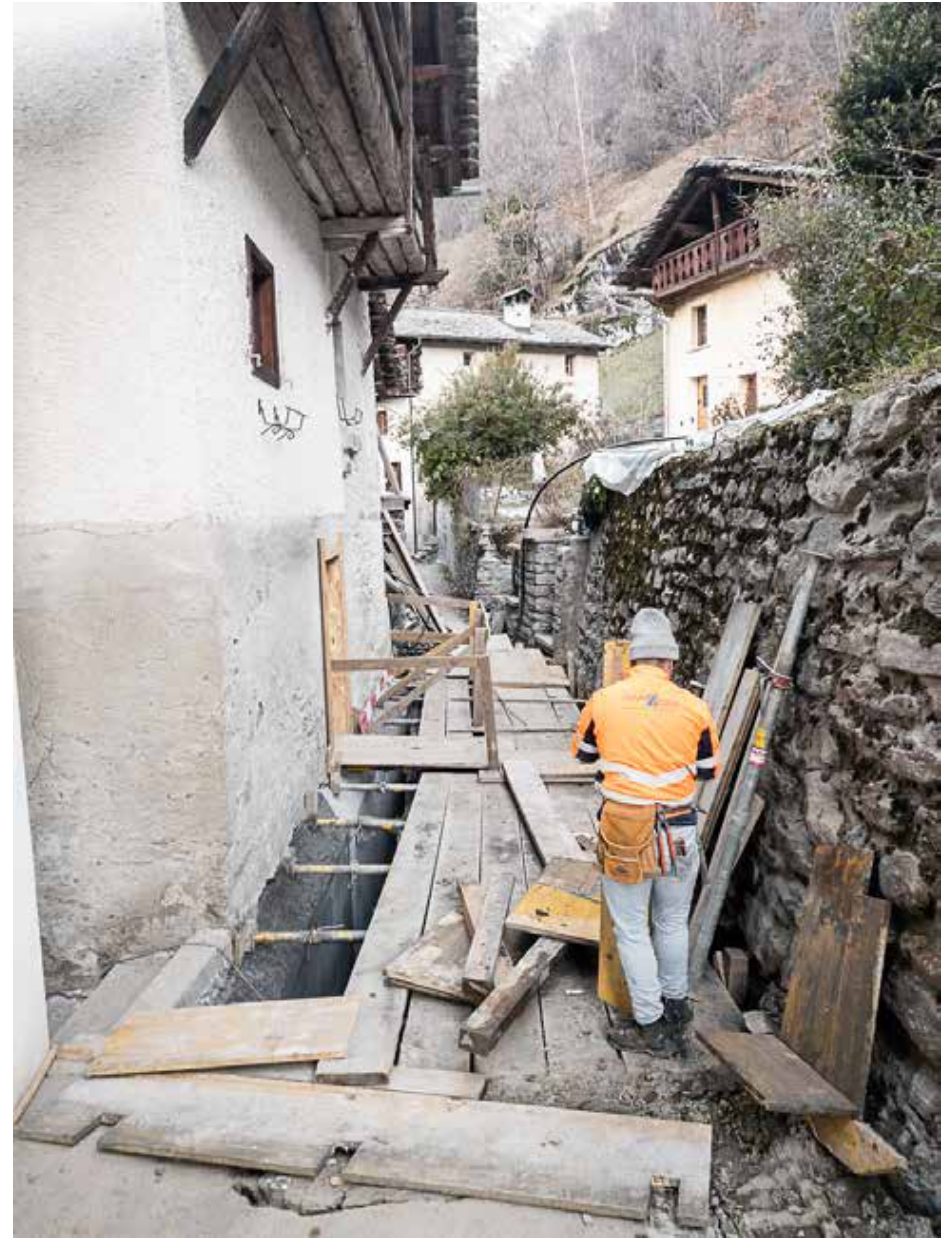
08.12.2022 – Brücke für die Passanten
