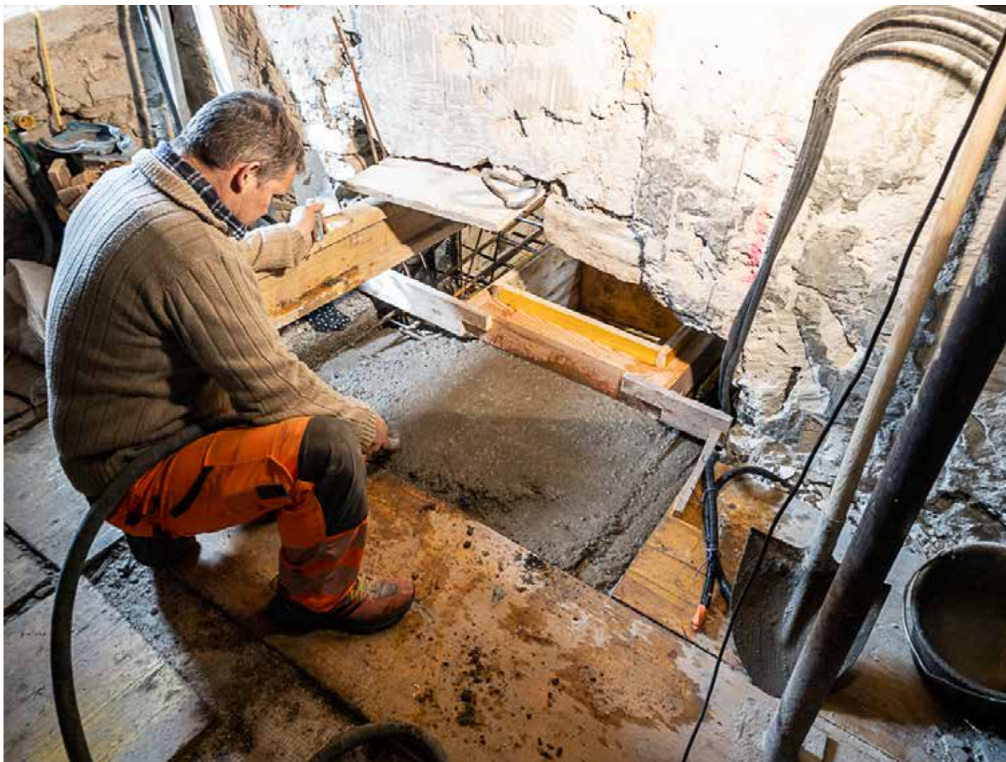
14.03.2023 – EG – Betonieren der Annex Grundmauern auf Geschosshöhe
