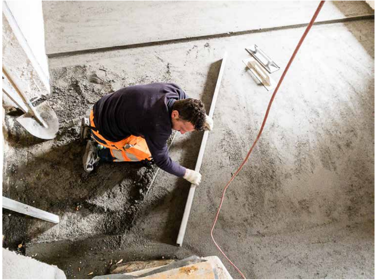
17.05.2023 – EG – Einbringen des Unterlagsbodens
