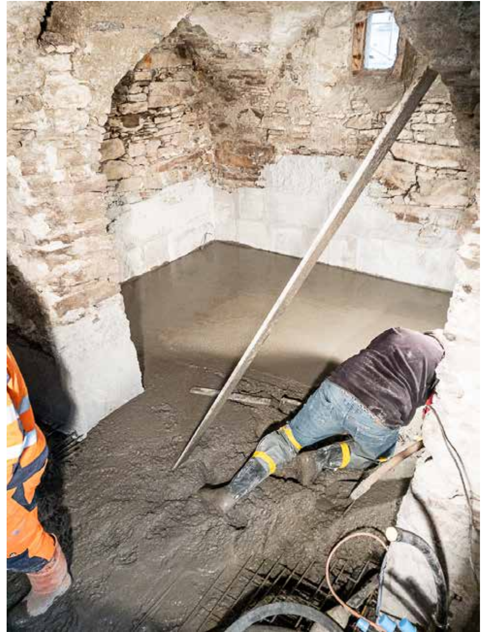
28.11.2022 – UG – Giessen der Bodenplatte
