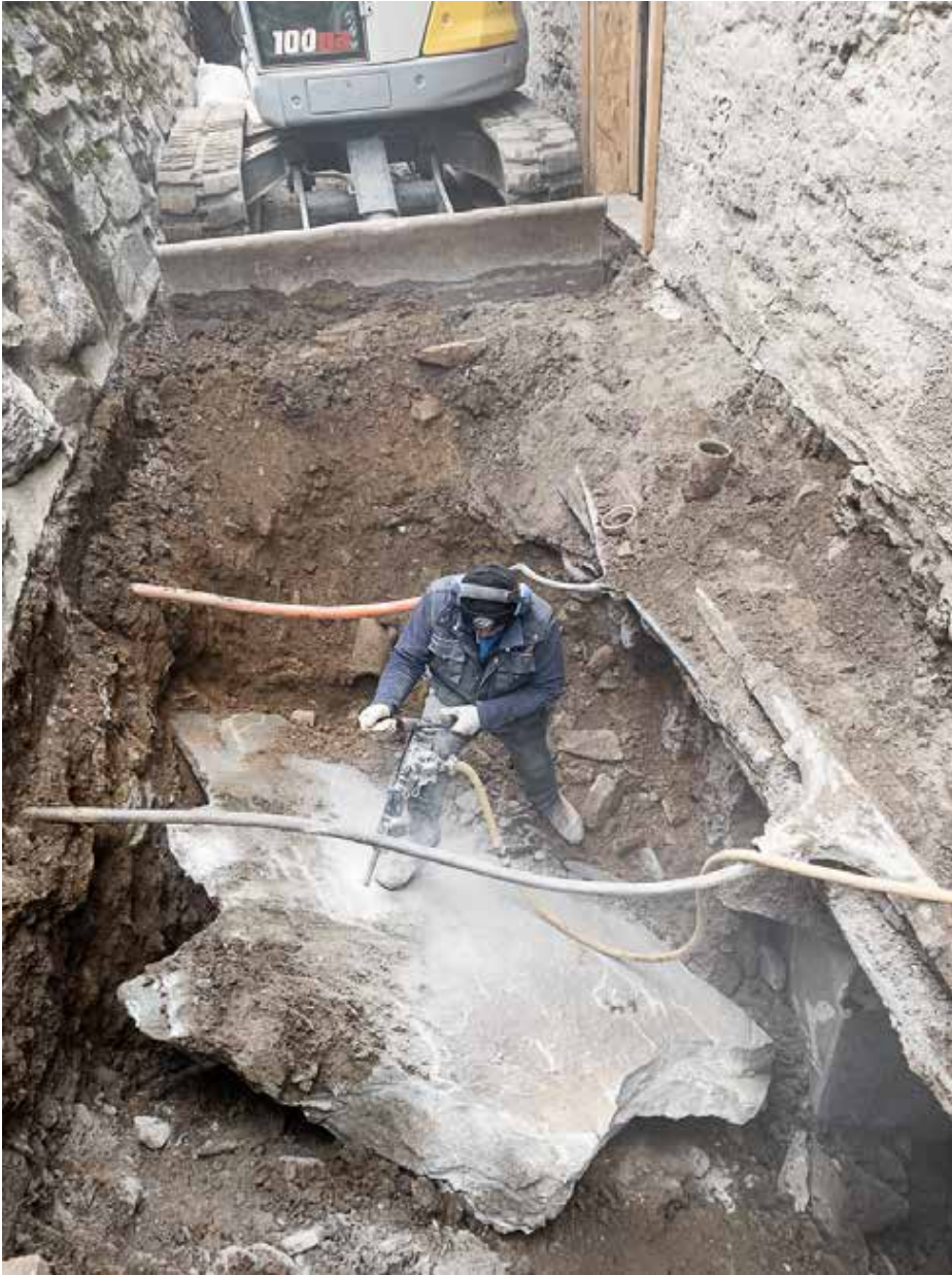
29.11.2022 – Zerkleinern eines riesigen Felsbrockens
