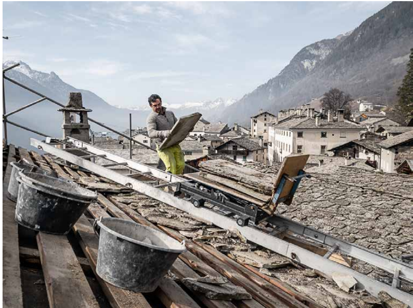
20.02.2023 – Abdecken des Steindaches und Lagerung der Platten auf der Passerelle
