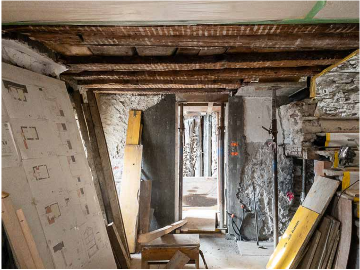
21.03.2023 – EG – Betonierter Durchgang zum Annex
