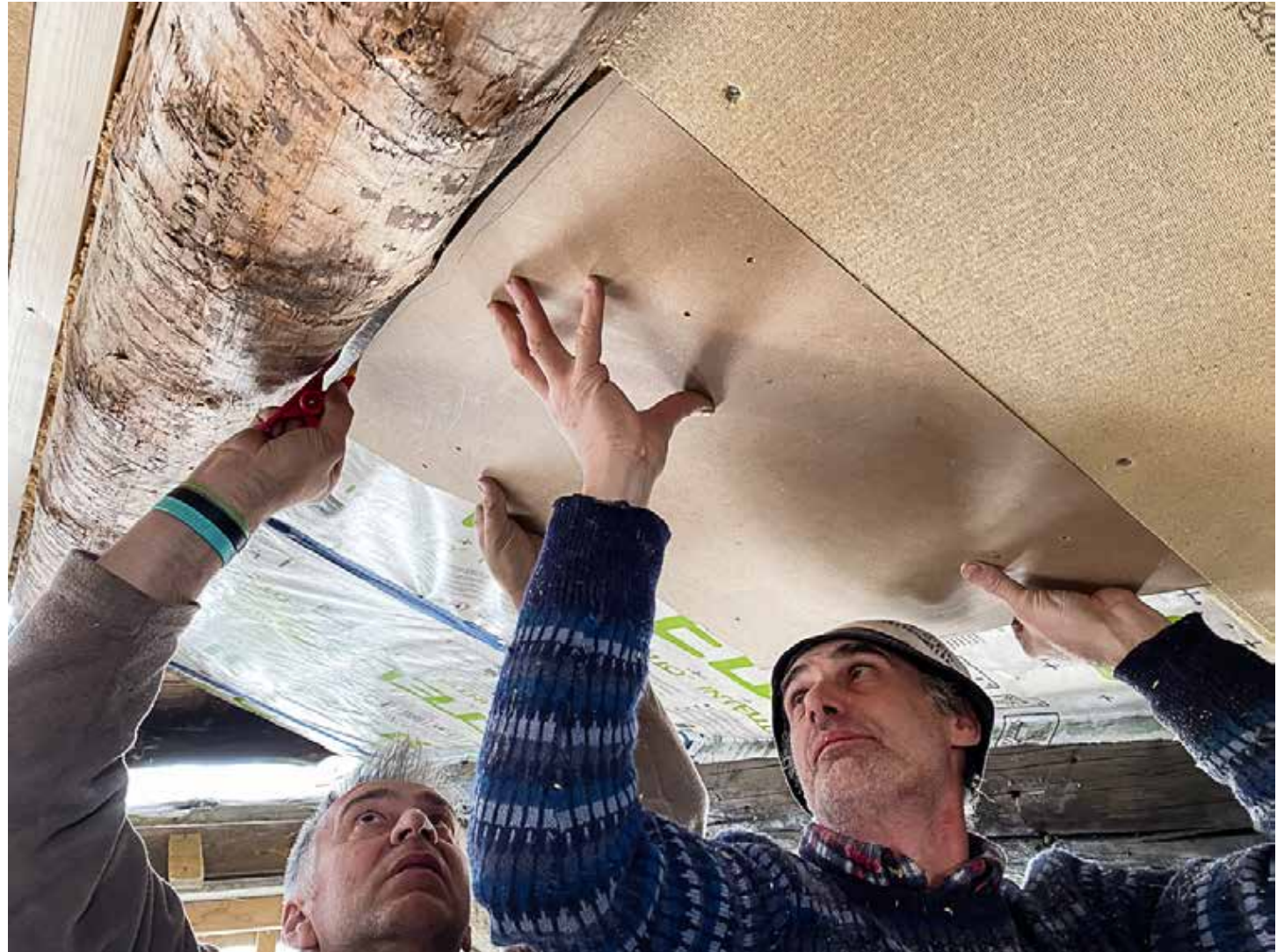
28.04.2023 – DG – Einpassen der Isolationselemente mit Schablone
