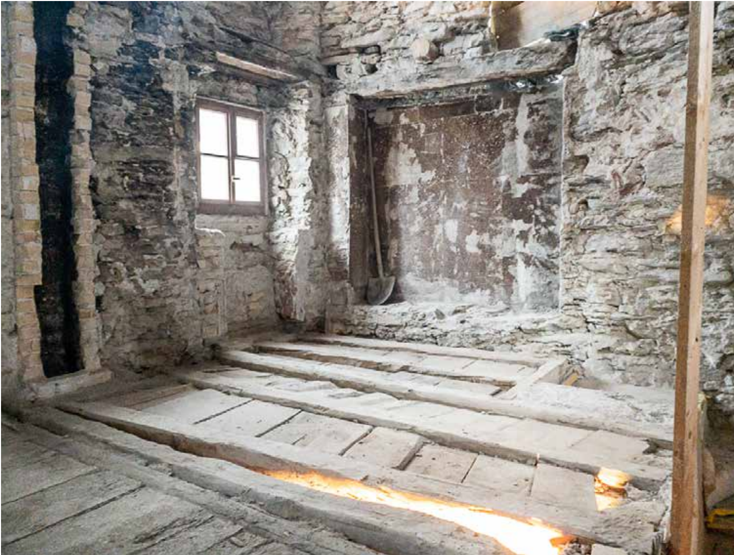
10.02.2023 – OG – Nummerieren der Steinplatten und freilegen der Balkenlage
