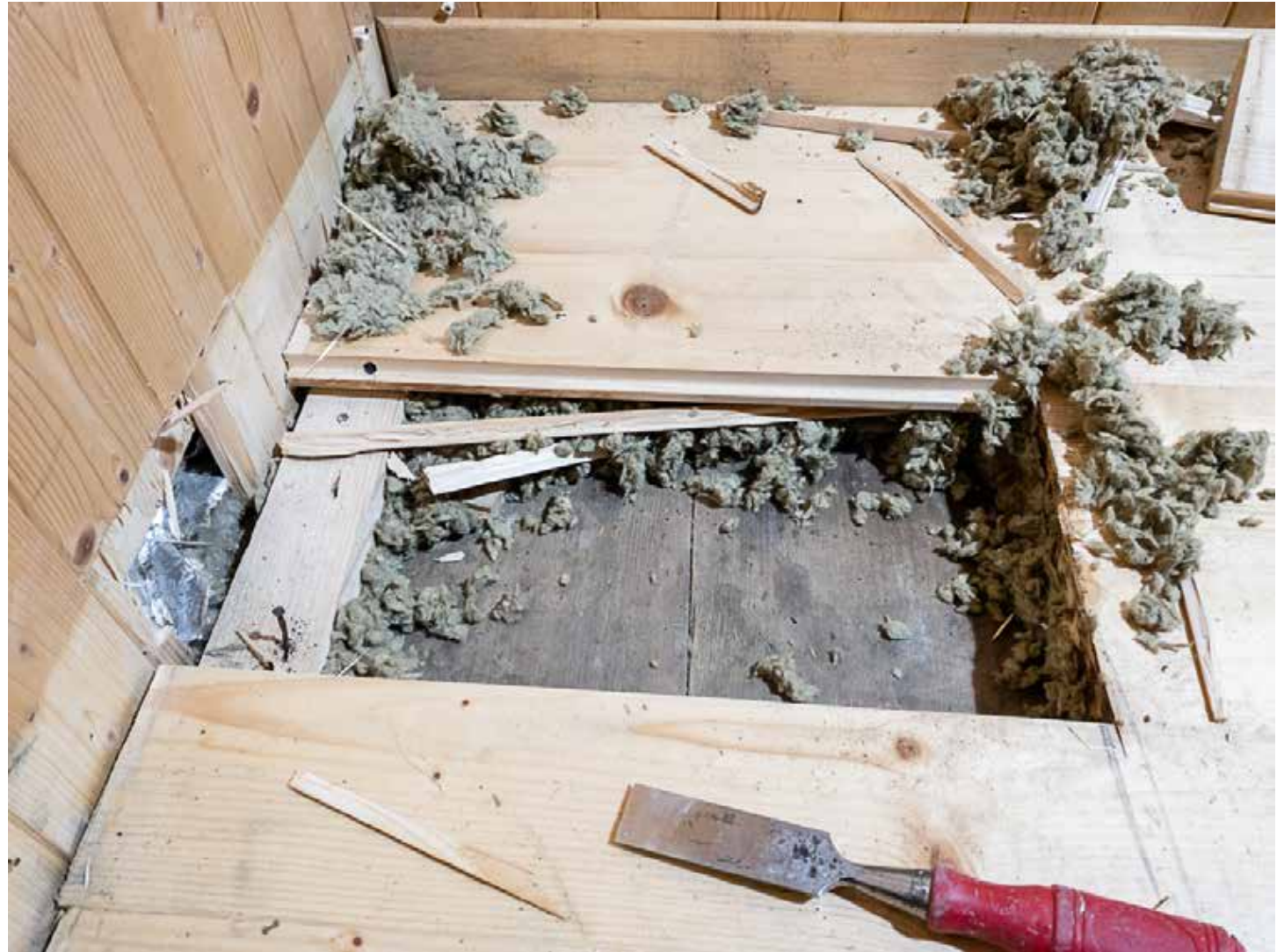
21.10.2021 – EG – Sondage Wand- und Bodenbeläge
