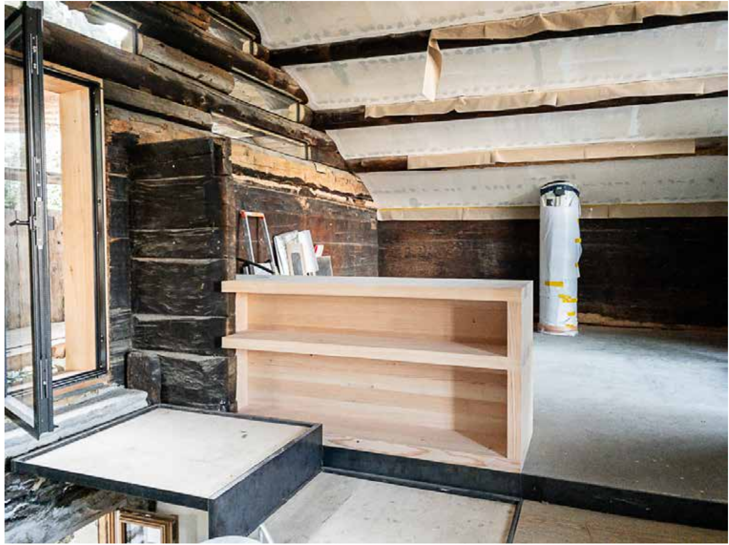
20.07.2023 – DG – Montage Bibliotheksmöbel und Vorbereitung für die Verklebung der Aluminiumfolie
