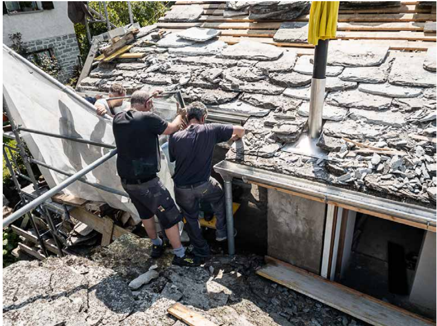
08.06.2023 – EG – Einsetzen der EI30 Gläser (230 kg)
