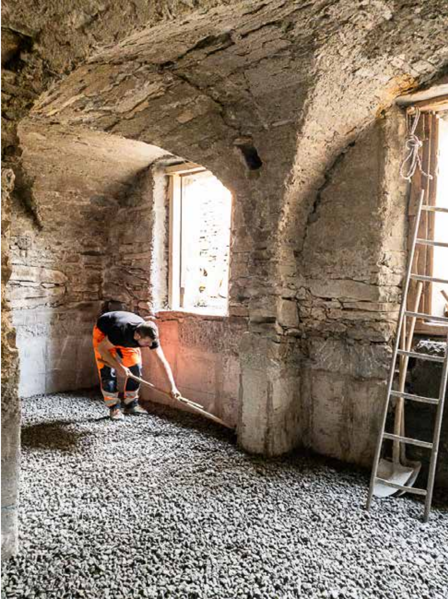
11.11.2022 - UG - Nivellierter Schotterkoffer
