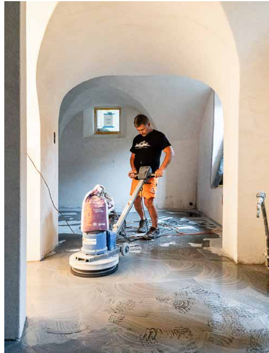
21.06.2023 – UG – Schleifen vom Betonboden
