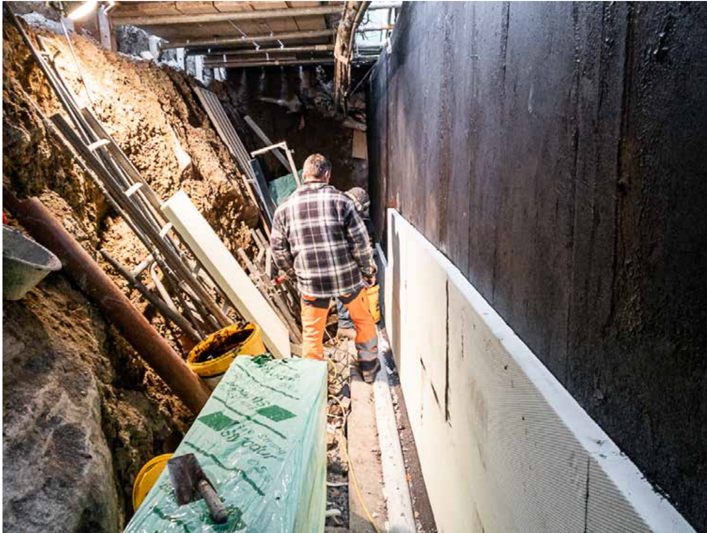
13.12.2022 – Schwarzanzstrich und Isolation der Perimeterabdichtung
