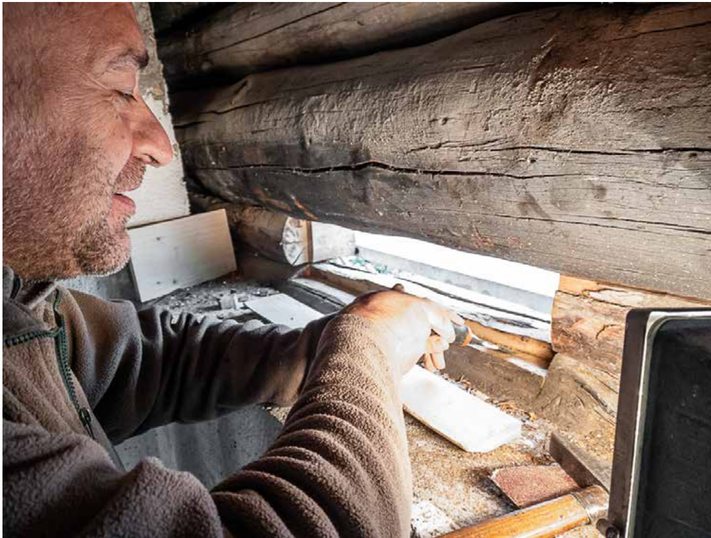
25.05.2023 - DG - Ausschneiden der Fensterleibungen im Firstbereich
