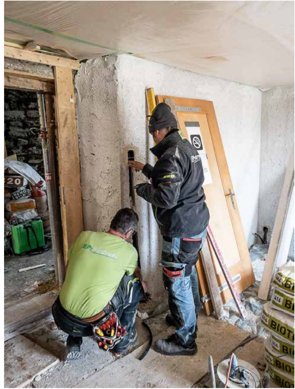
04.05.2023 – EG – Setzen der Dosen für die Elektroverteilung
