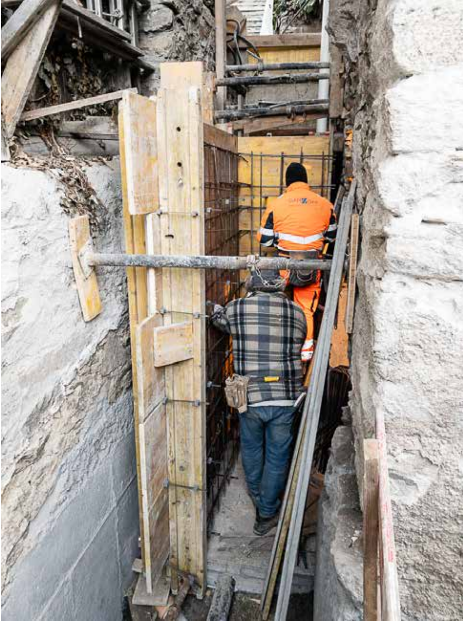
08.12.2022 – Beengte Schalung der Annex Grundmauern
