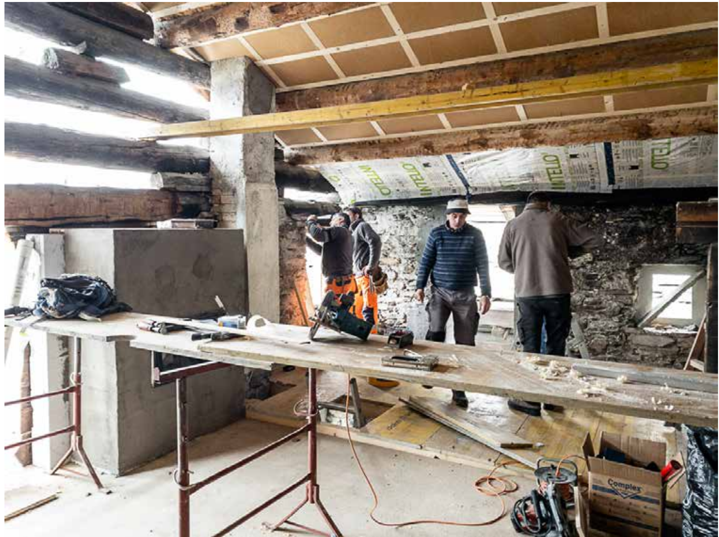
28.04.2023 – DG – Holzfaserisolation Dachbereich
