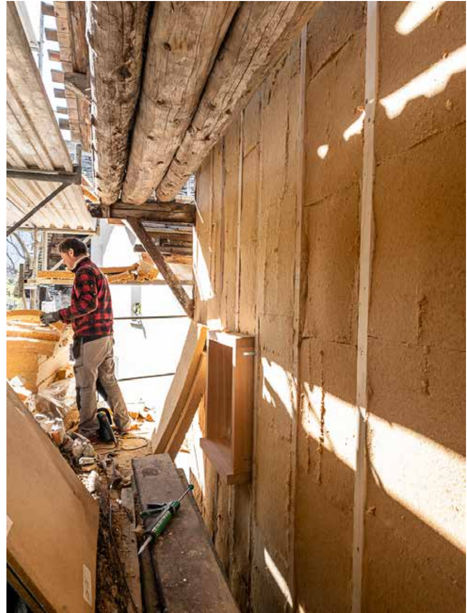
27.04.2023 – Holzfaserisolation im Bereich des Holzstrickes
