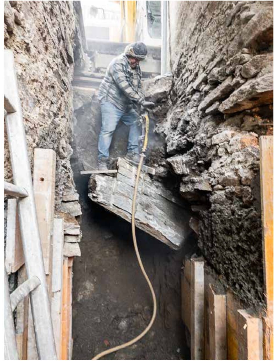
23.11.2022 – Felsbrocken erschweren die Arbeit
