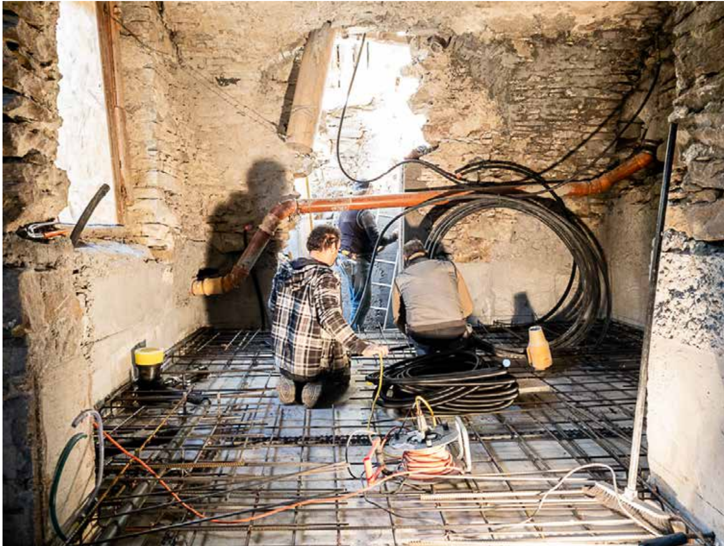
23.11.2022 – UG – Verlegen der Wasser- und Abwasserleitungen
