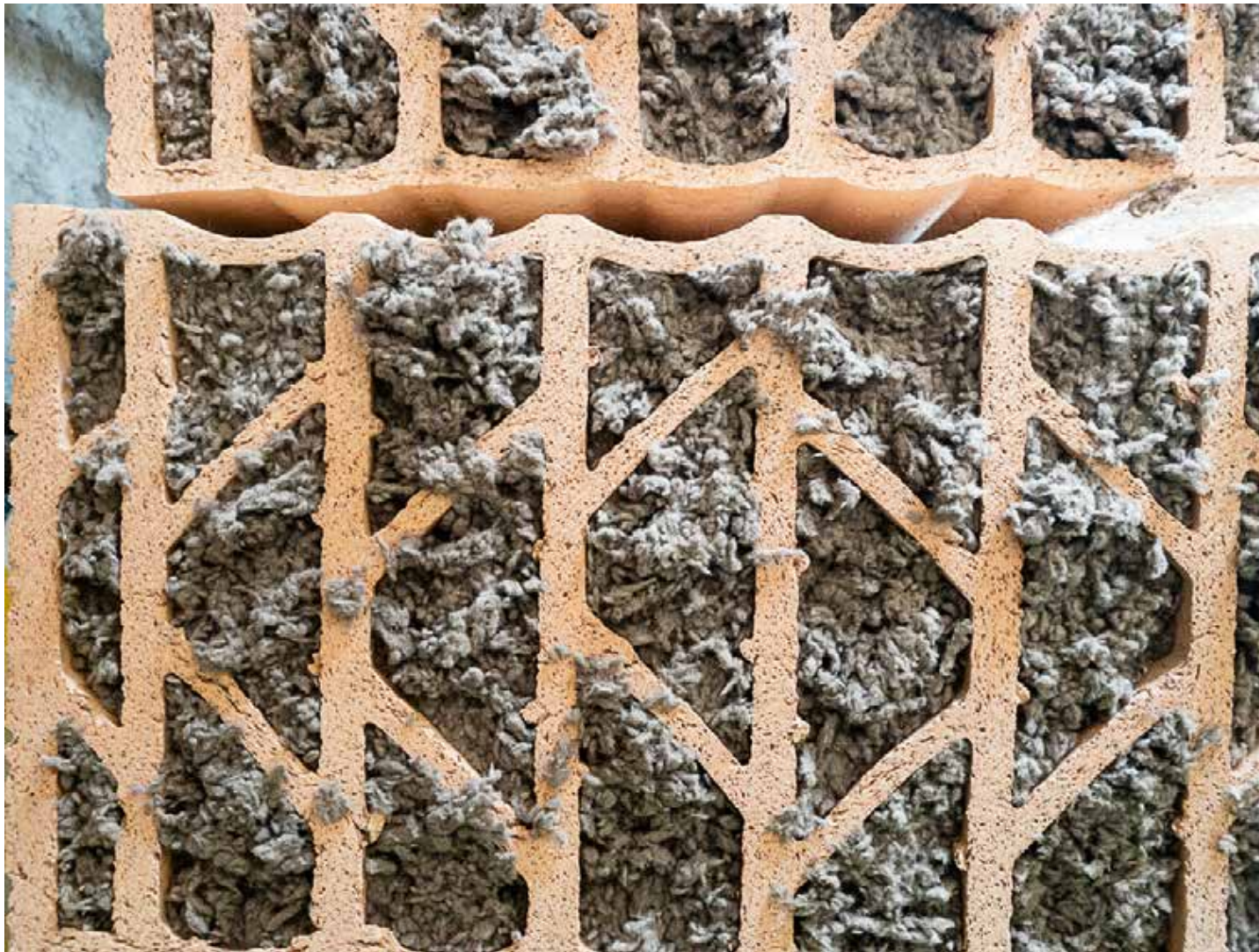
15.03.2023 – Isolationsbacksteine für die Annexaufmauerung
