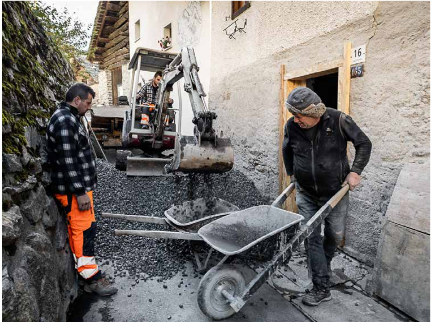
11.11.2022 – Einbringen des Sickerschotters für das UG
