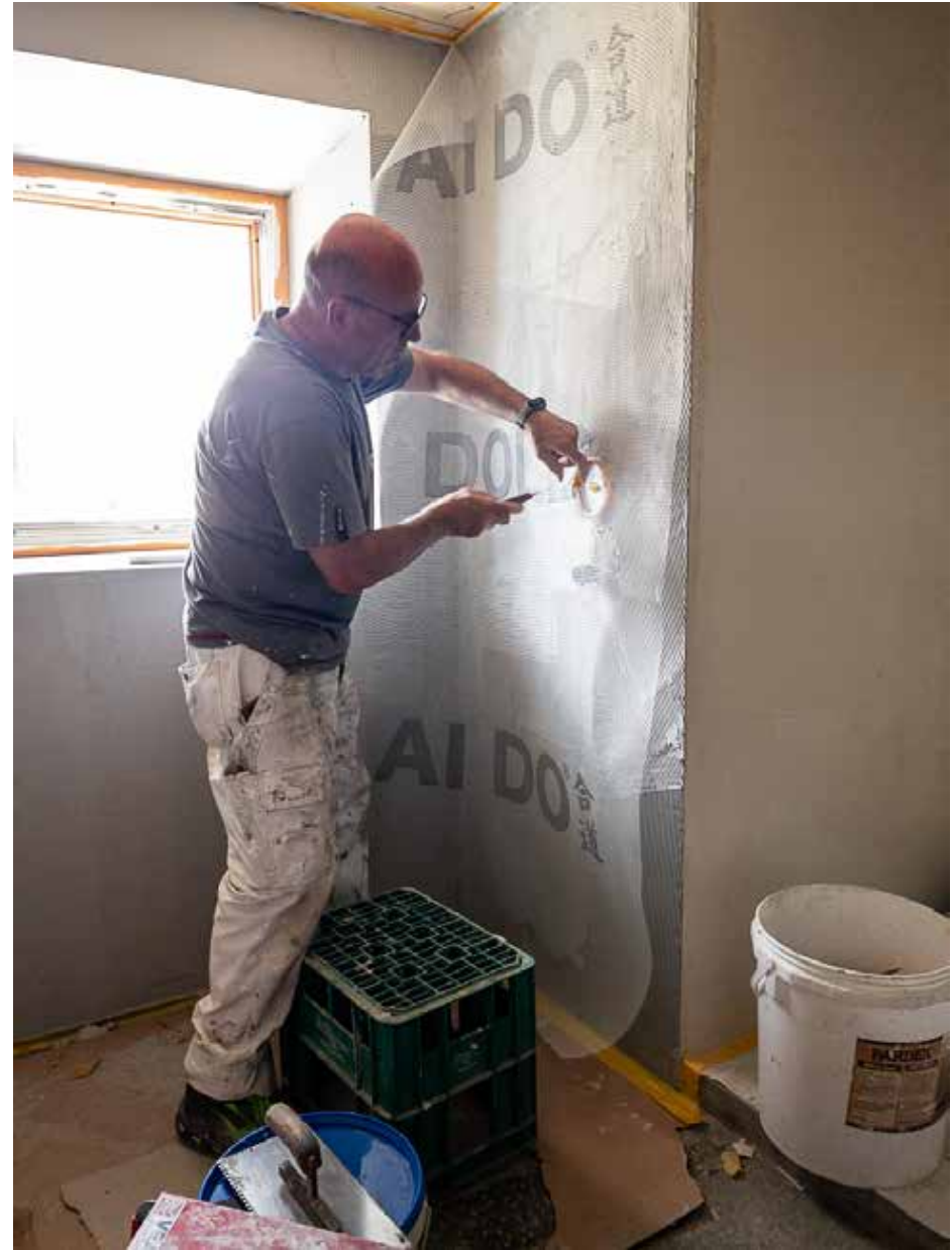
07.07.2023 – OG – Netzeinbettung für die Abdichtung im Duschbereich
