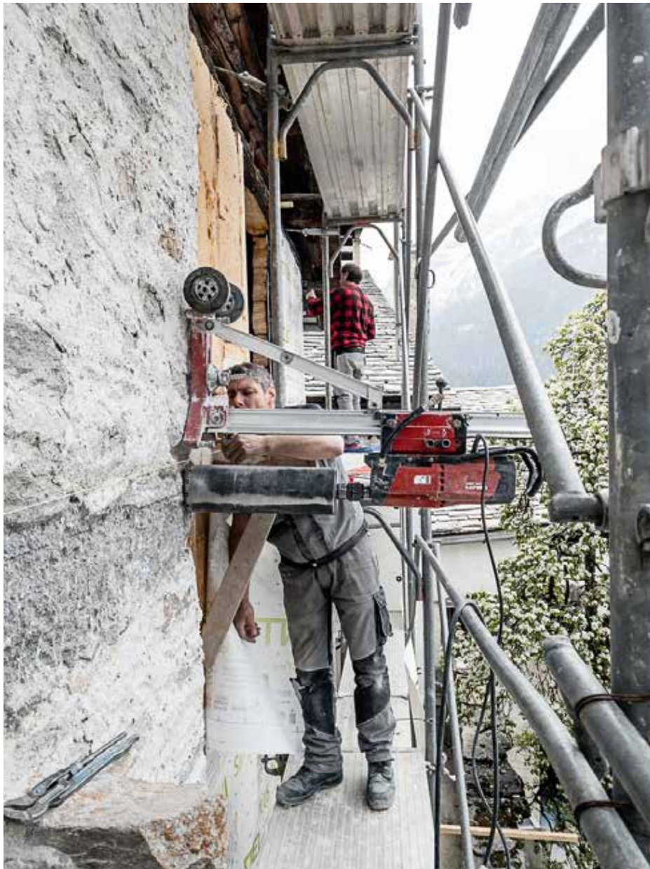
28.04.2023 – OG – Kernbohrungen für die Terrassenträger
