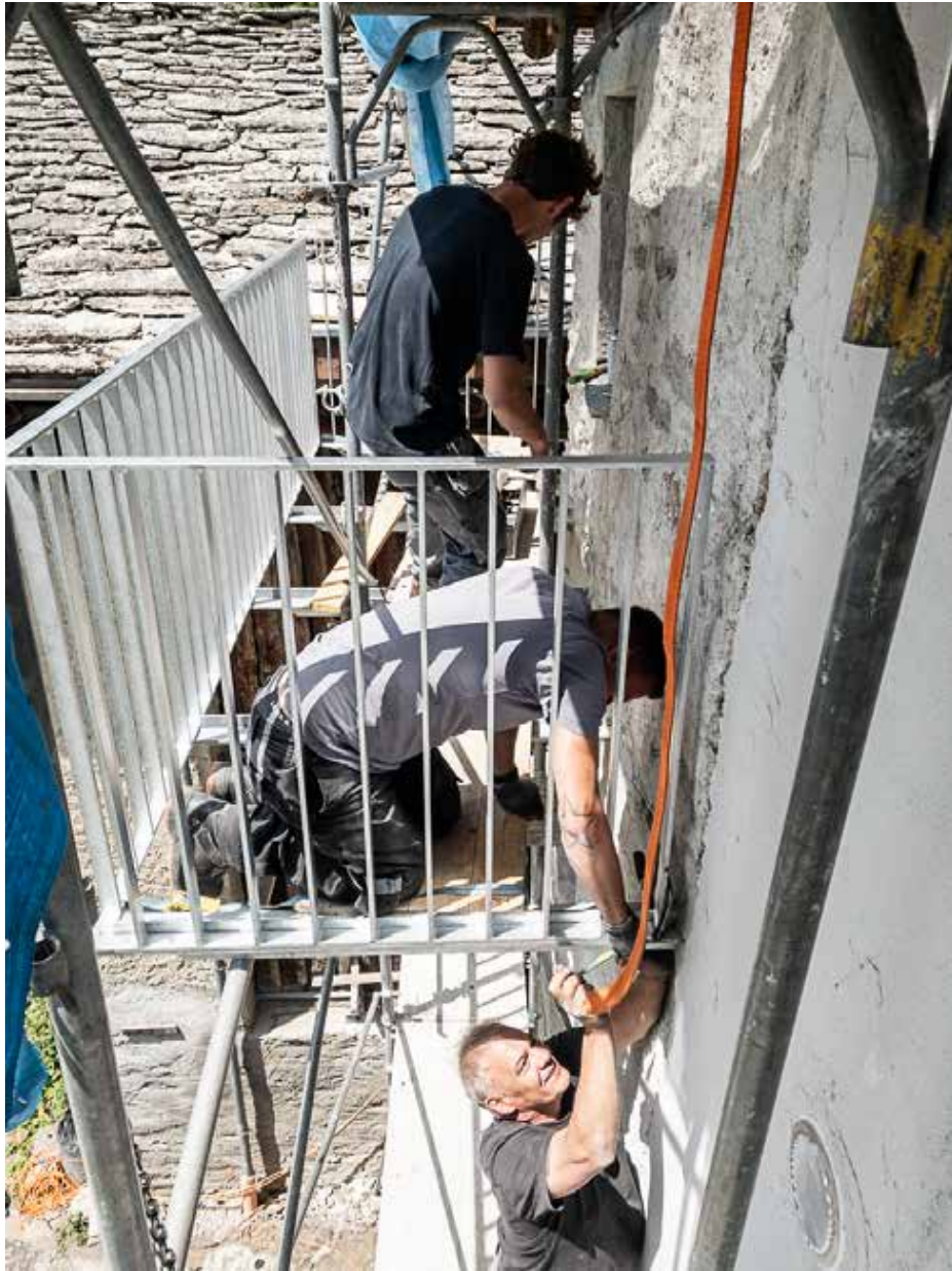
22.06.2023 – DG – Montage Balkongeländer
