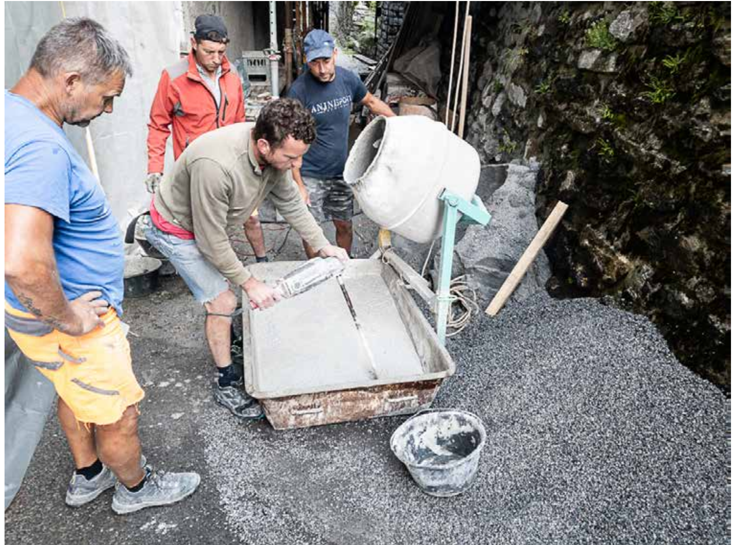
13.07.2023 – Vorbereitungen für die perfekte Mischung vom Anwurf
