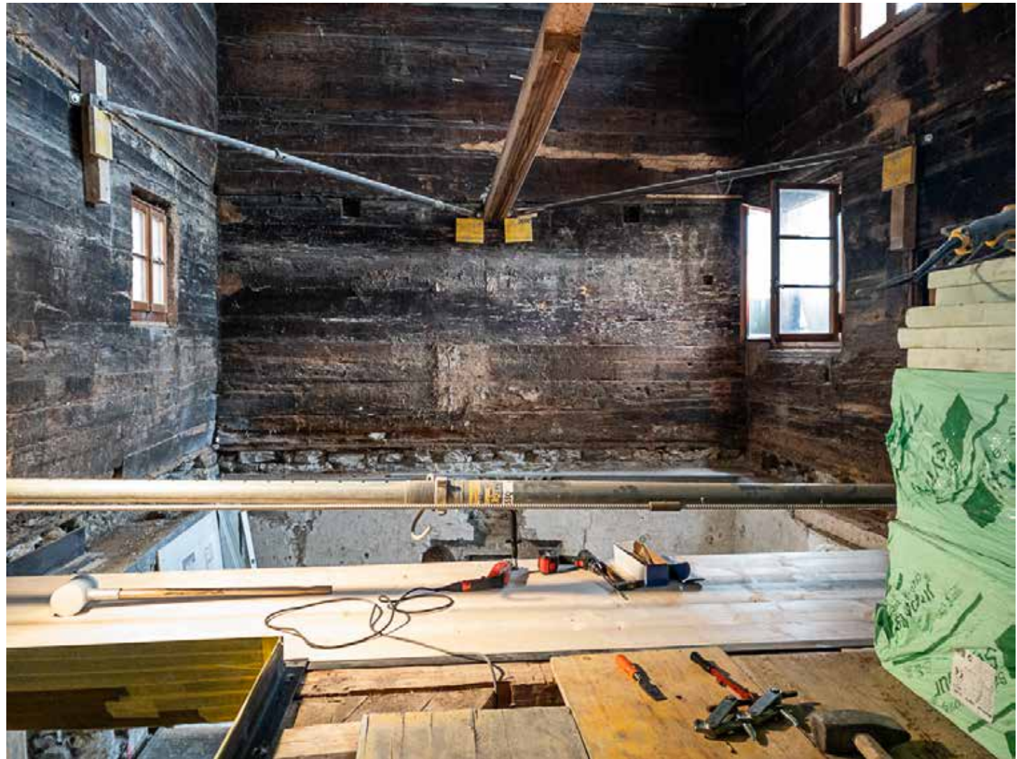
06.03.2023 – OG – Laterale Versteifung des Strickes, Einbringen der Holzbalkendecke
