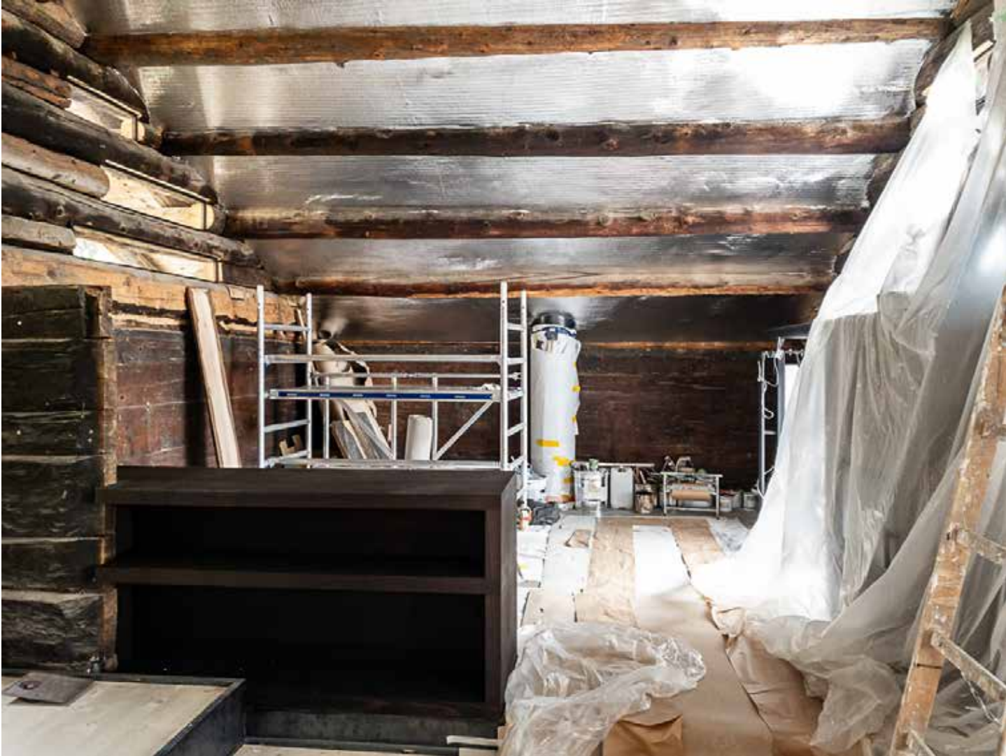
29.07.2023 – DG – Verklebung der Aluminiumstreifen
