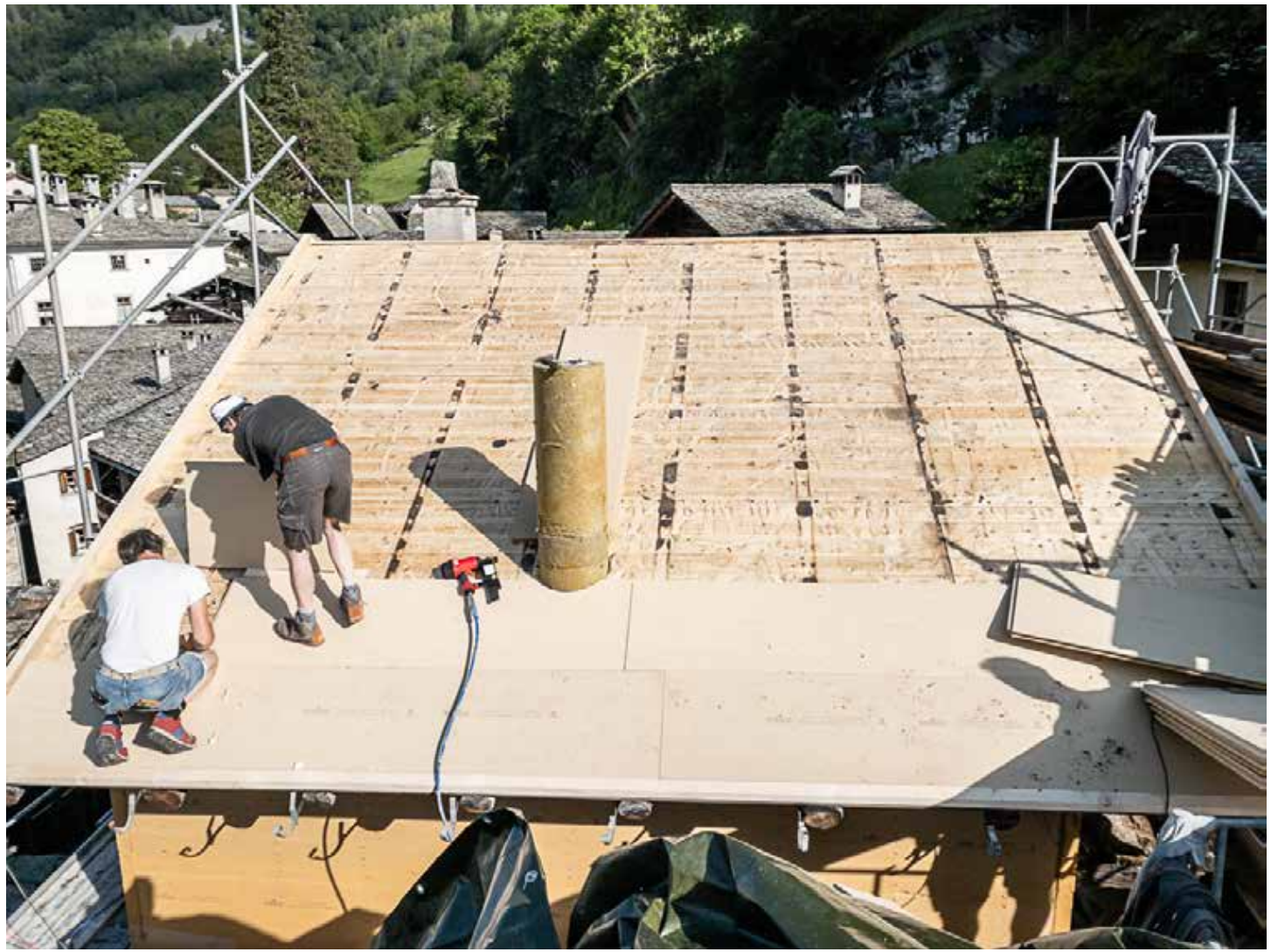
01.06.2023 – DG – Verlegen der Aufdach Holzfaserisolation
