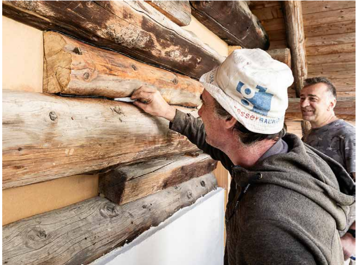
16.06.2023 – DG – Silikonisieren der Holzfugen
