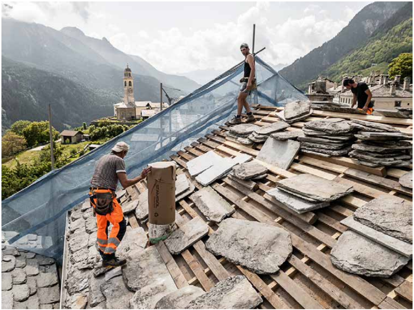
06.06.2023 – DG – Verlegen der bestehenden Steinplatten
