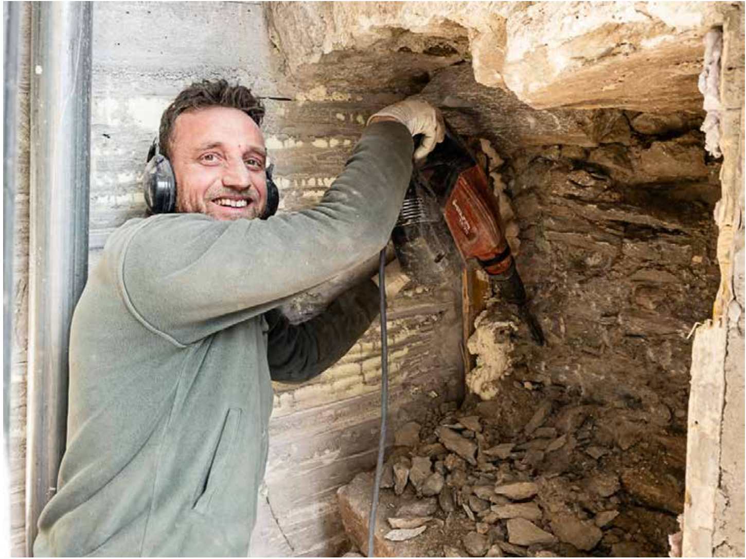
19.04.2023 – UG – Heikle Mission, gute Stimmung. Abbruch der Hausecke für die Ausseneinheit der Wärmepumpe
