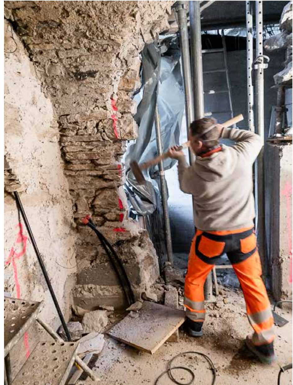
03.03.2023 – UG – Abbruch der Hausmauer im Bereich des Annexbaues
