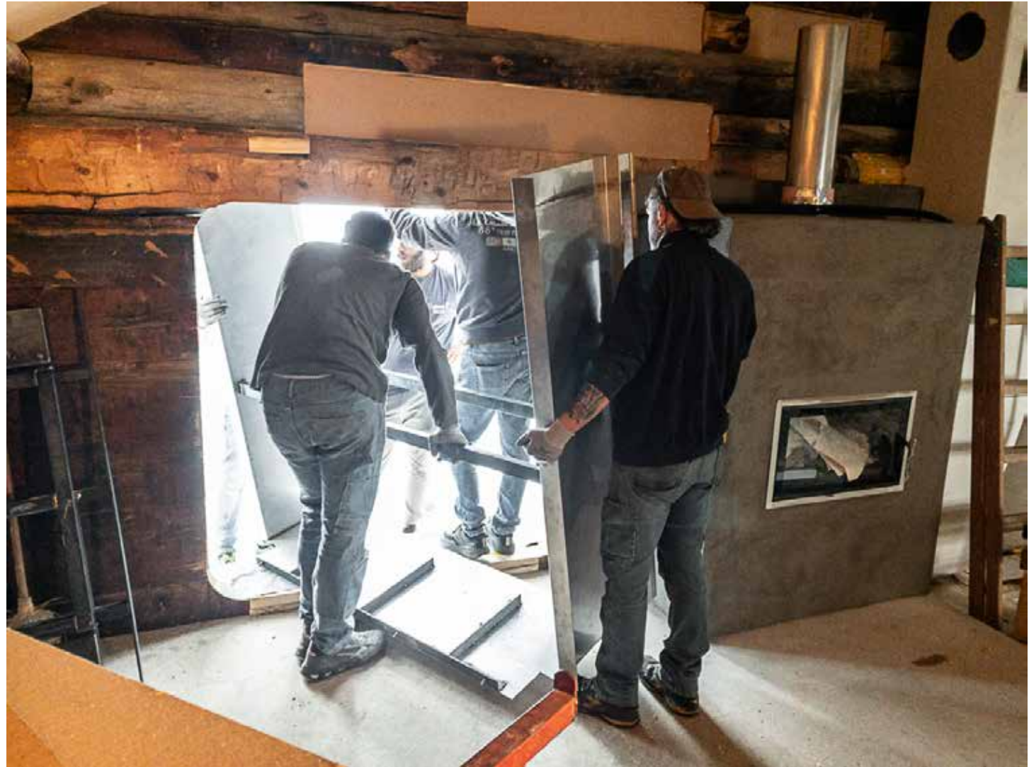
13.06.2023 – DG – Montage Aussenleibung auskragendes Fenster
