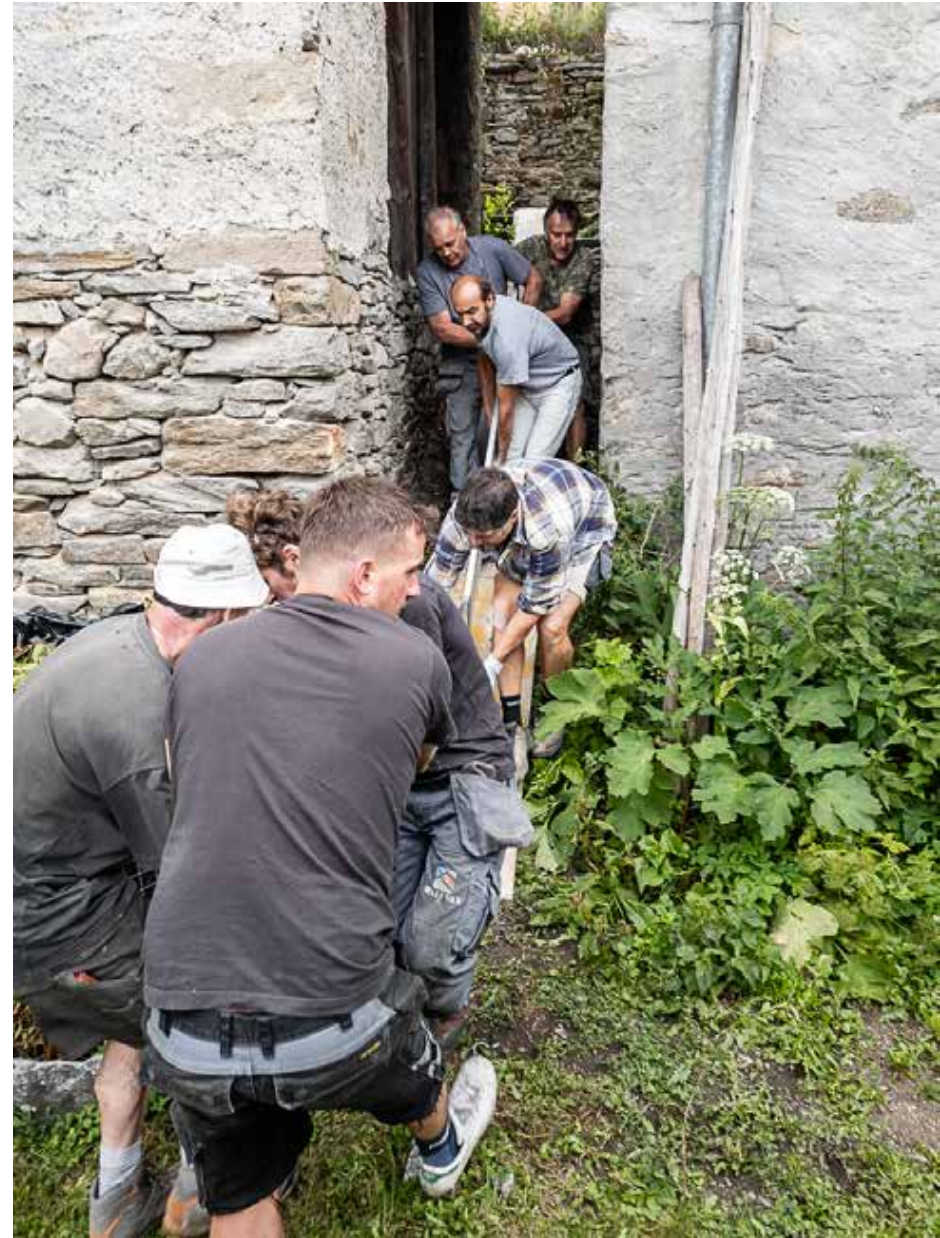
06.07.2023 – Einbringen der Stahlwangen für die Aussentreppe
