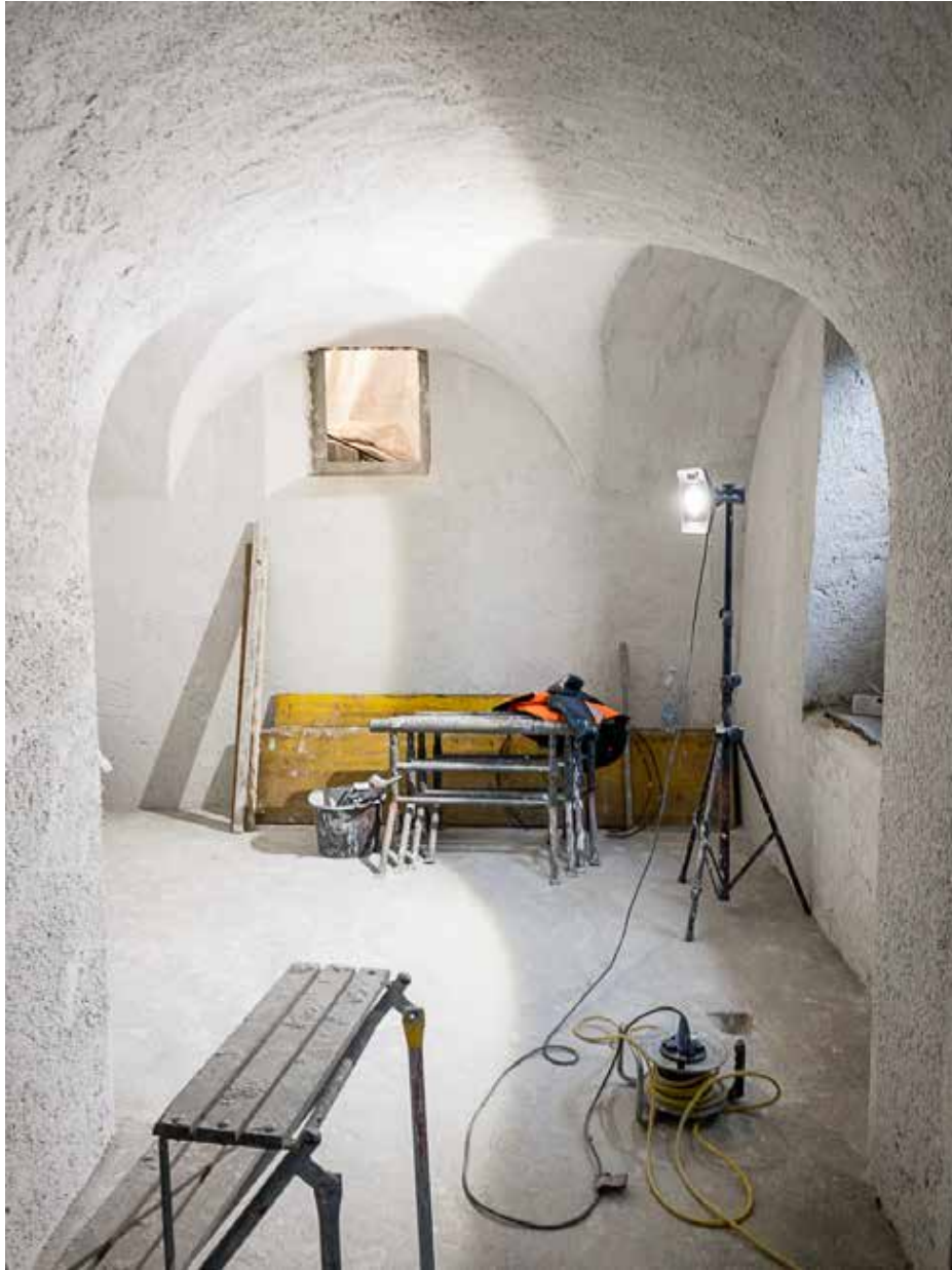
27.04.2023 – UG – Auftragen von Biotherm Wärmedämmputz
