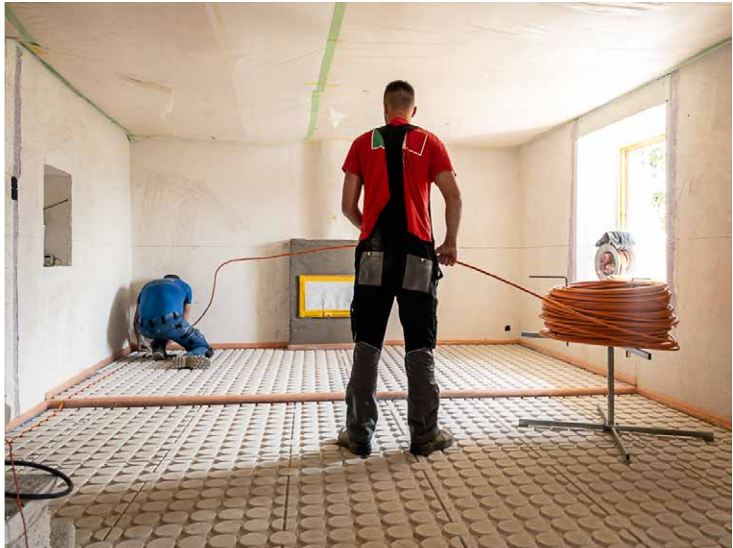
30.05.2023 – EG – Verlegen der Bodenheizung
