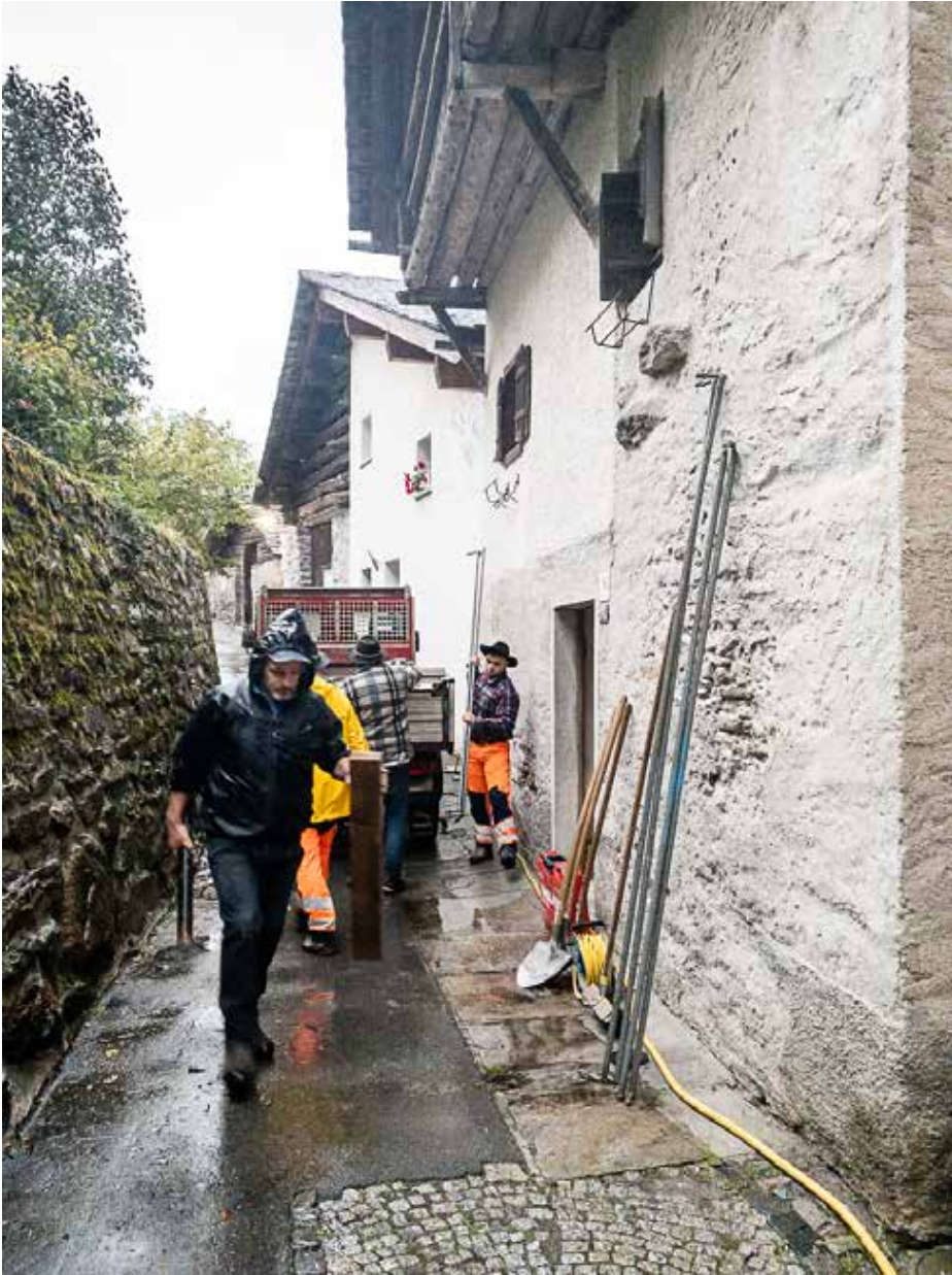
24.10.2022 – Regnerischer Start für die Umbauarbeiten
