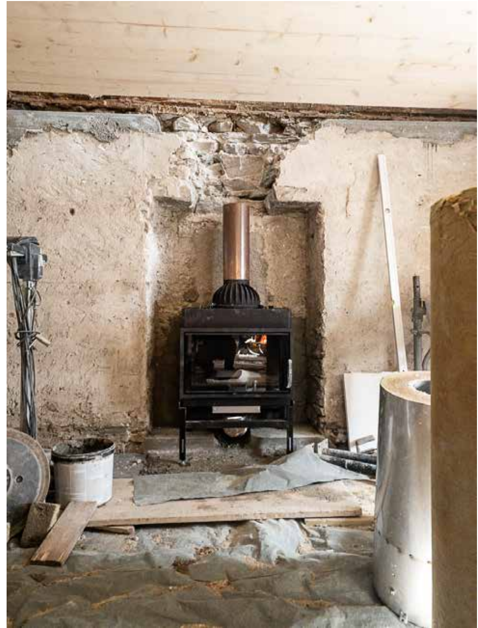
14.03.2023 – EG – Setzen vom Speichercheminée
