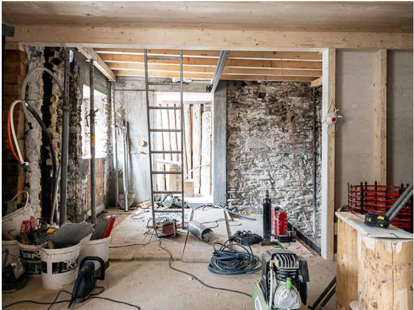
28.04.2023 – OG – Kernbohrungen für die Terrassenträger
