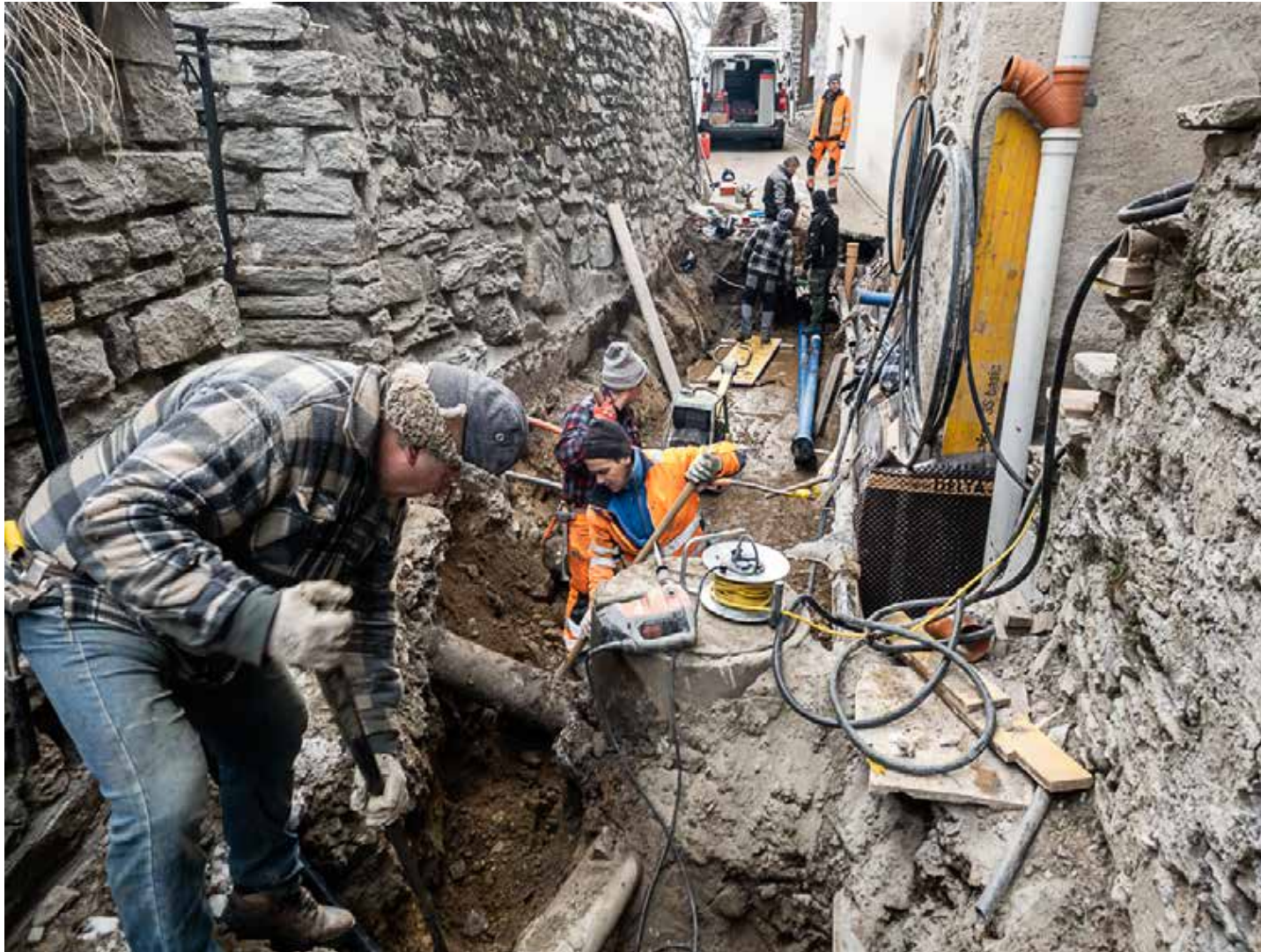
15.12.2021 – Verlegen der neuen kommunalen Wasserrohre
