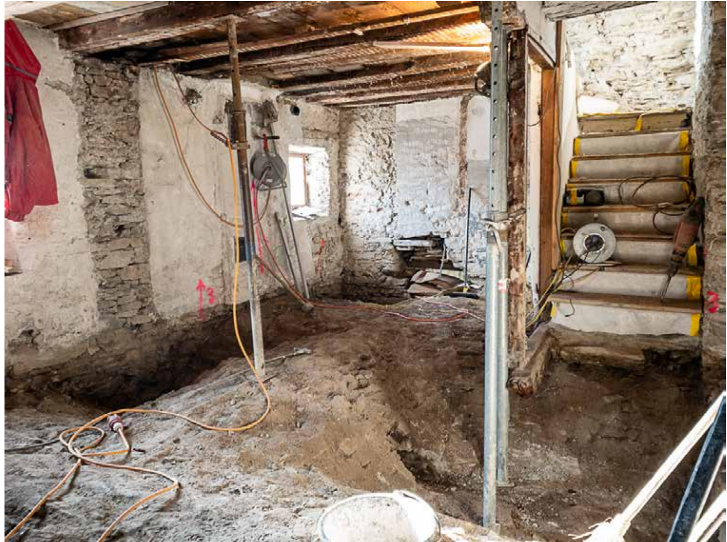
10.02.2023 – EG – Freilegen der Stein-Gewölbedecke
