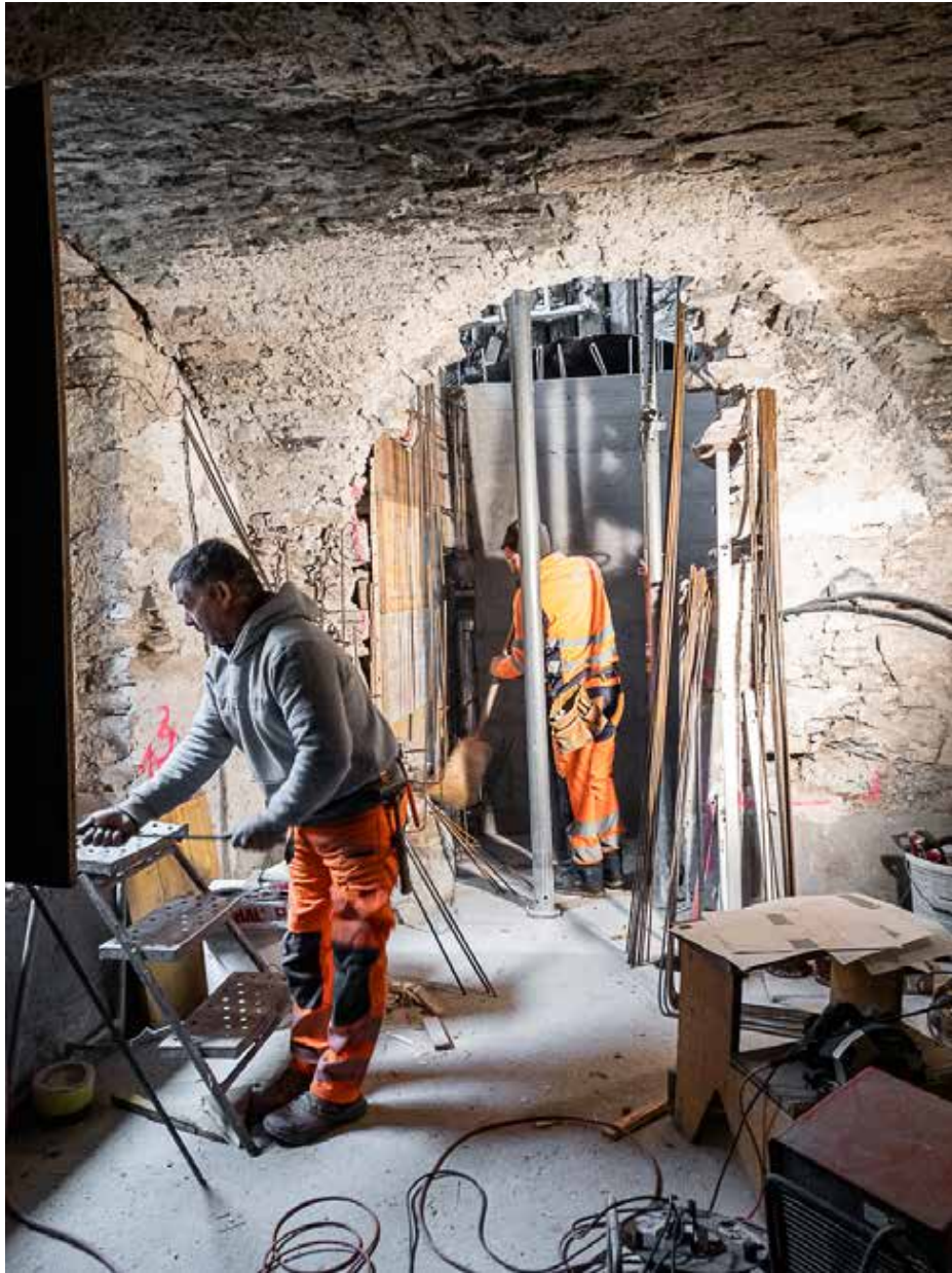
06.03.2023 – UG – Schalung und Vorbereitung zum Betonieren
