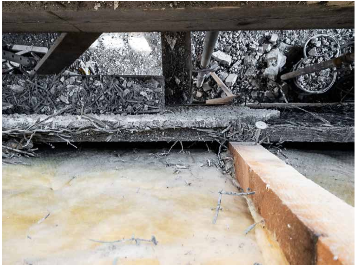
01.03.2023 – Entfernen der Aussenisolation beim Strickbau
