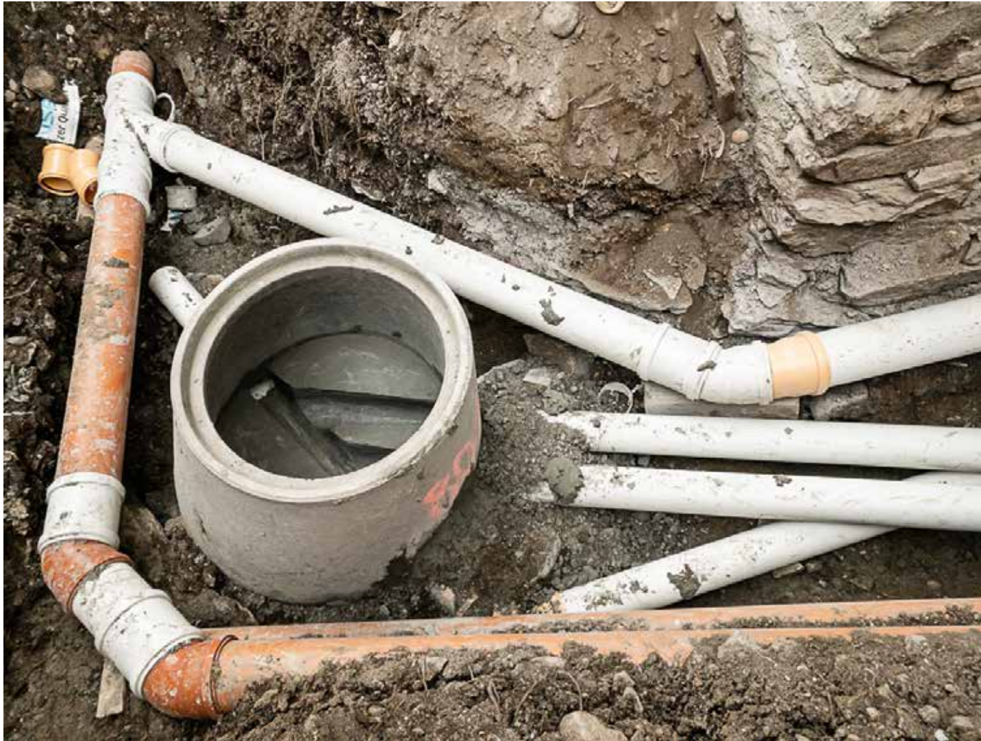
08.12.2022 – Neuer Schacht für die Fäkalleitungen, Rohre für das Meteorwasser
