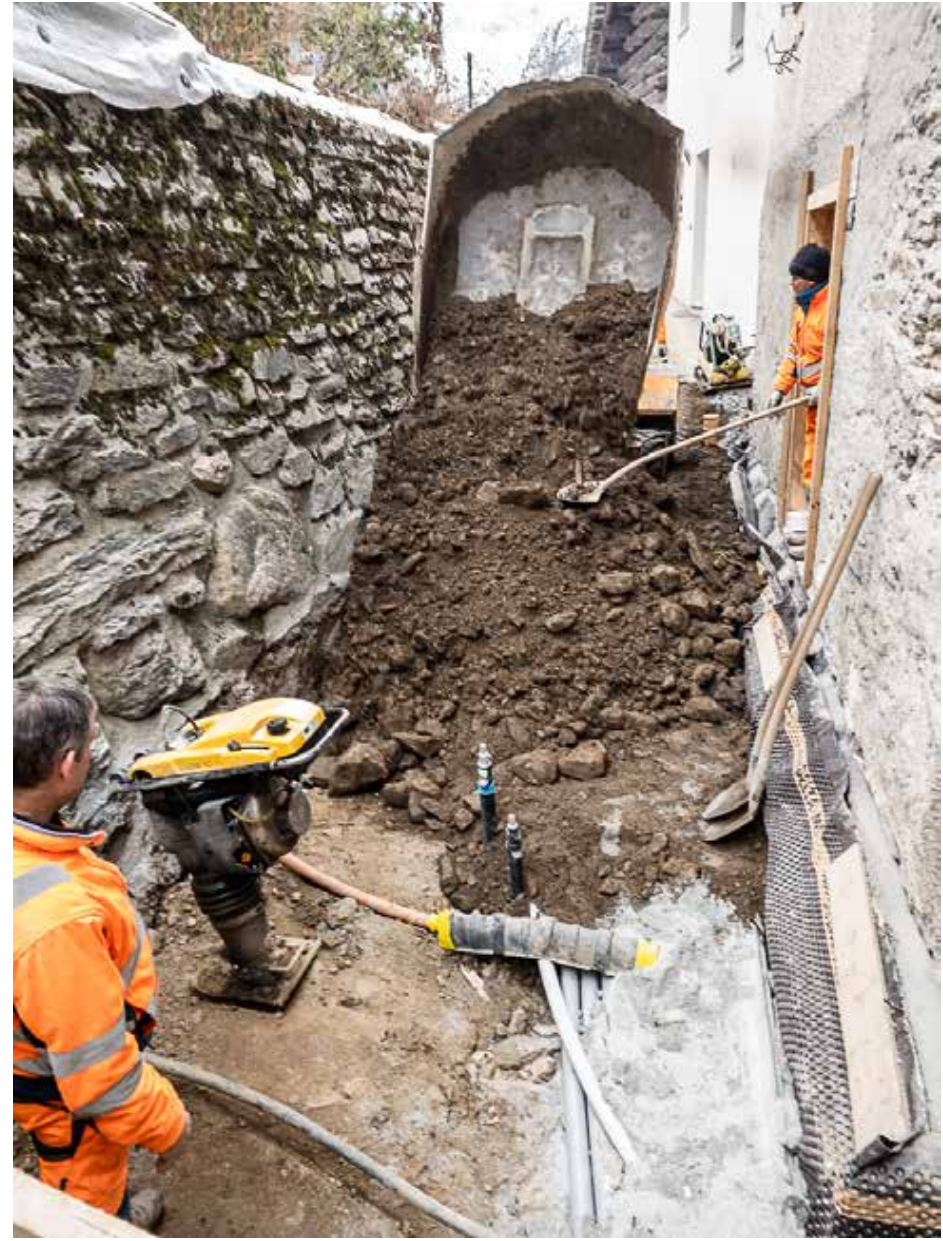
20.12.2022 – Zuschütten der Installationsebene
