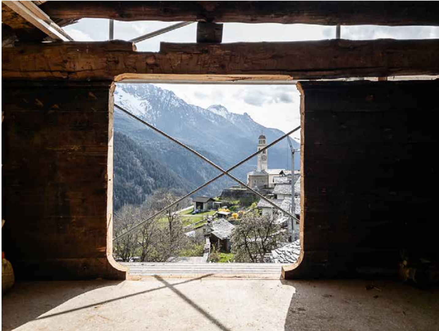
11.04.2023 – DG – Ausschnitt aus dem Strick für das ausragende Fenster
