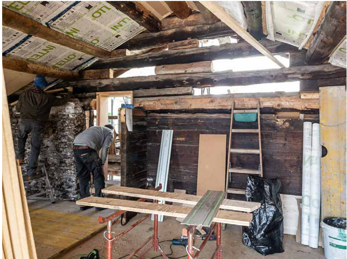
04.05.2023 – DG – Einpassen der neuen alten Firstbalken
