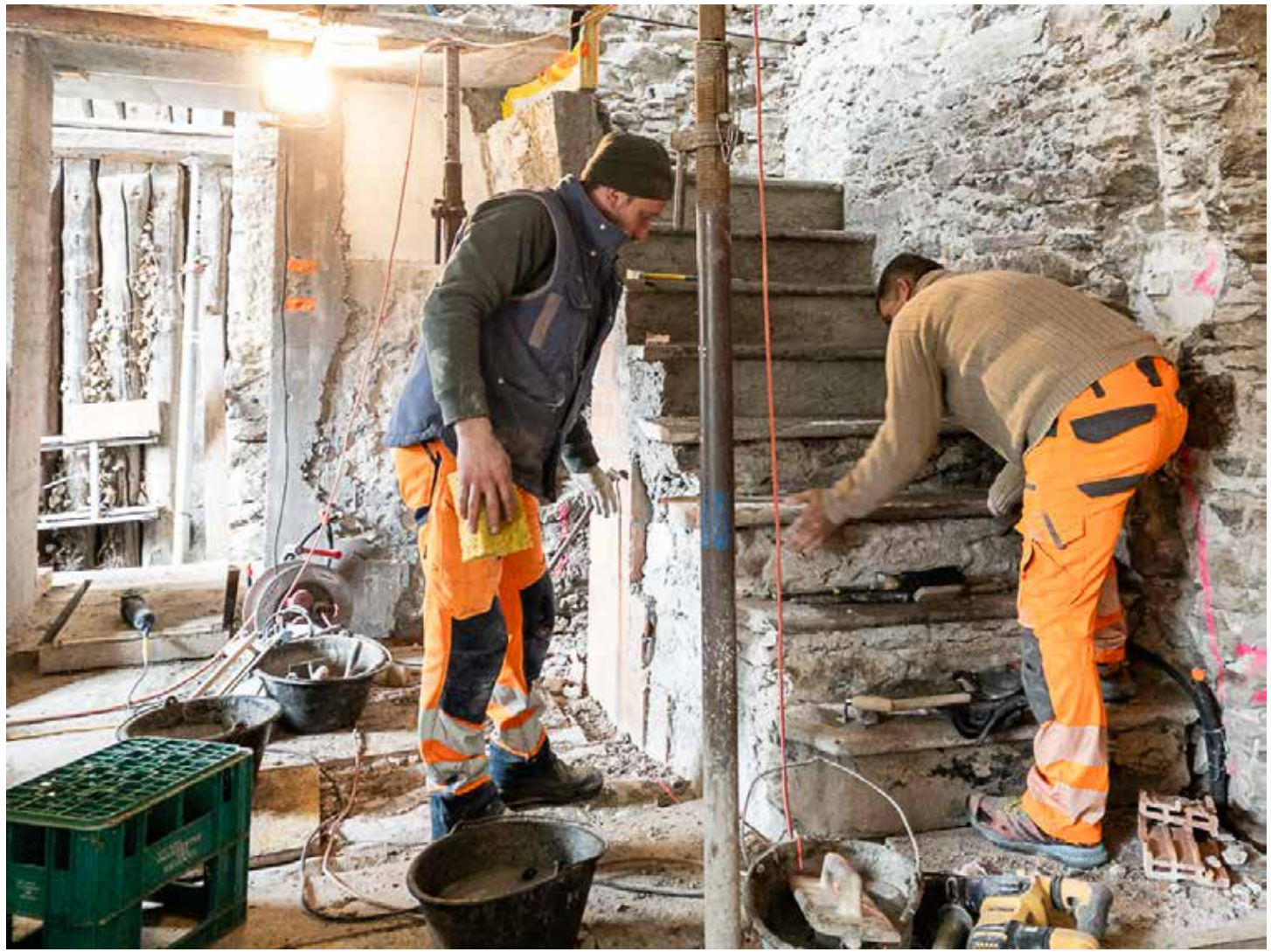
21.04.2023 – EG – Versetzen der Steinstufen
