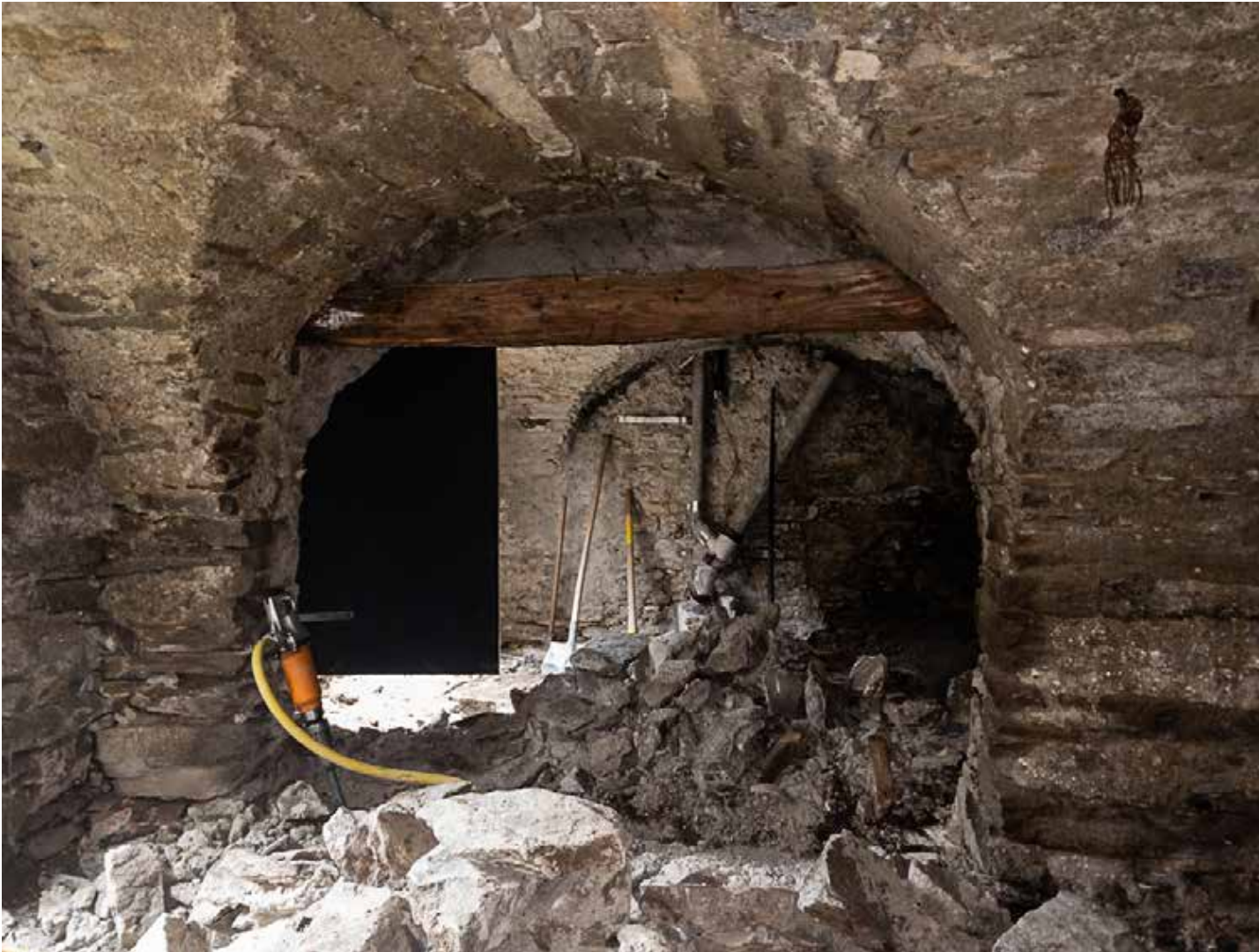
24.10.2021 – UG – Abbruch der freistehenden Steinwand zwischen den Kellergewölben
