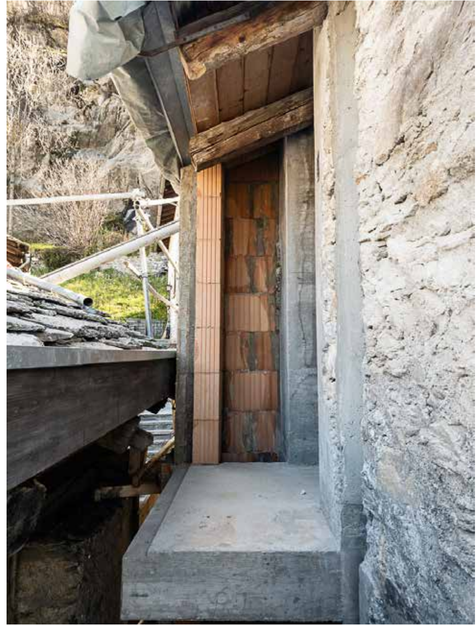
27.04.2023 – DG – Fertiges Podest
