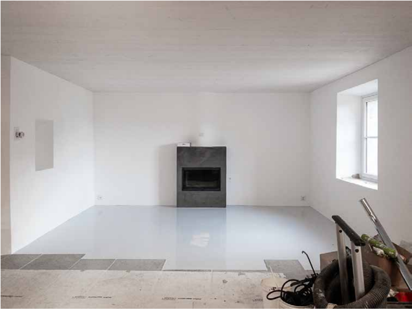
31.07.2023 – EG – PU-Boden ohne Versiegelung
