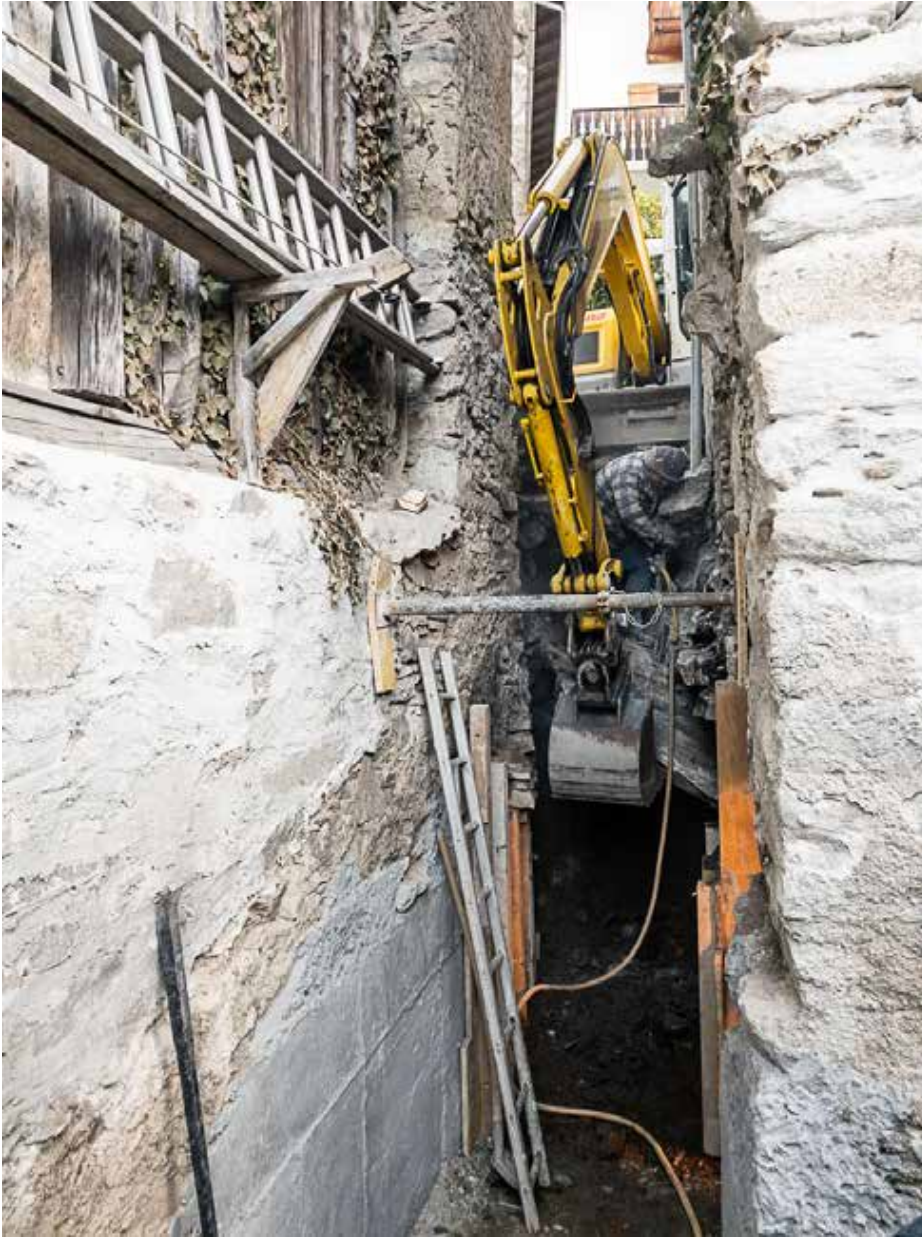
23.11.2022 - Pragmatisches Hilfsgerüst
