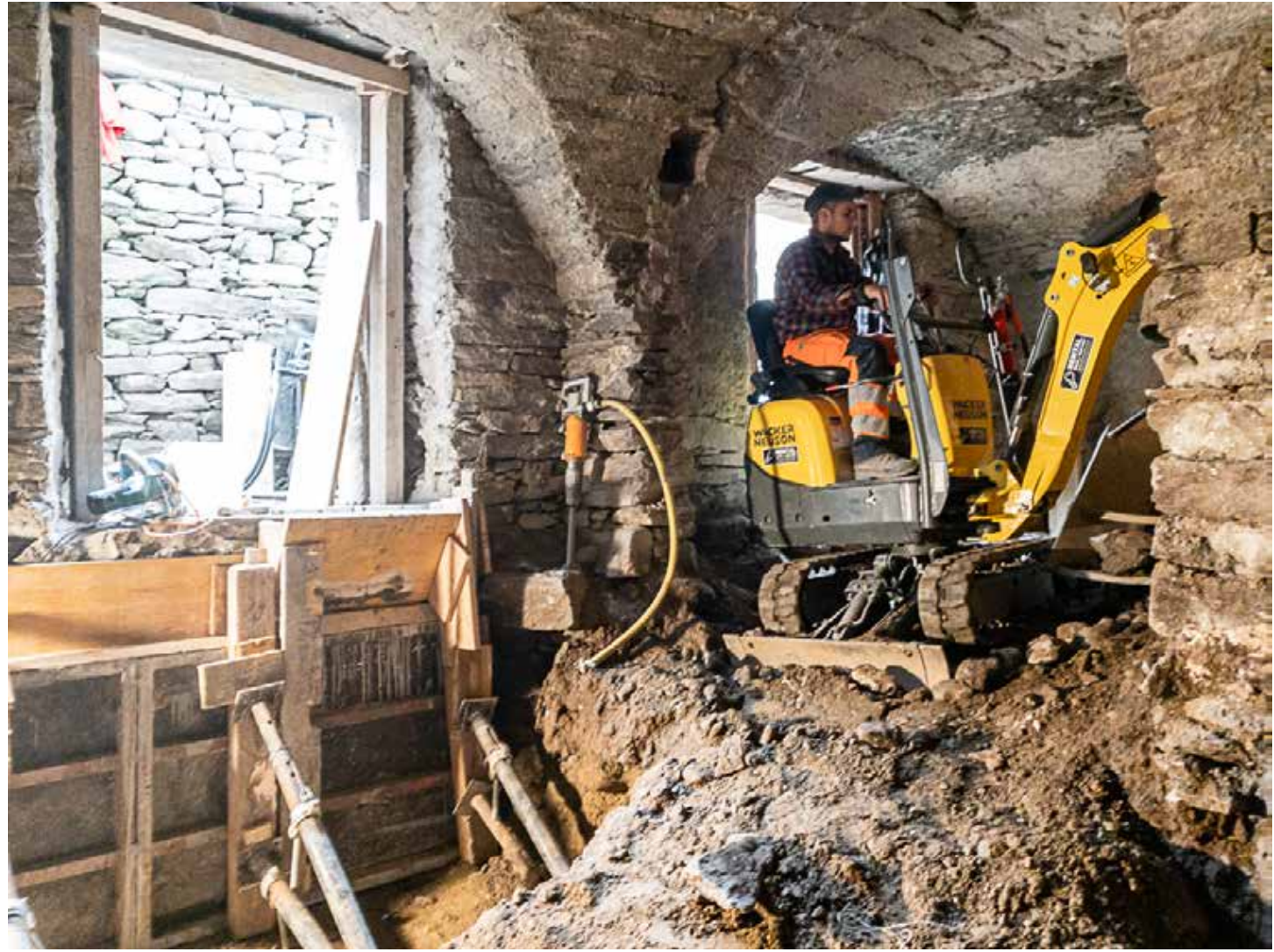
03.11.2022 – UG – Betonieren der Unterfangung bei den Grundmauern
