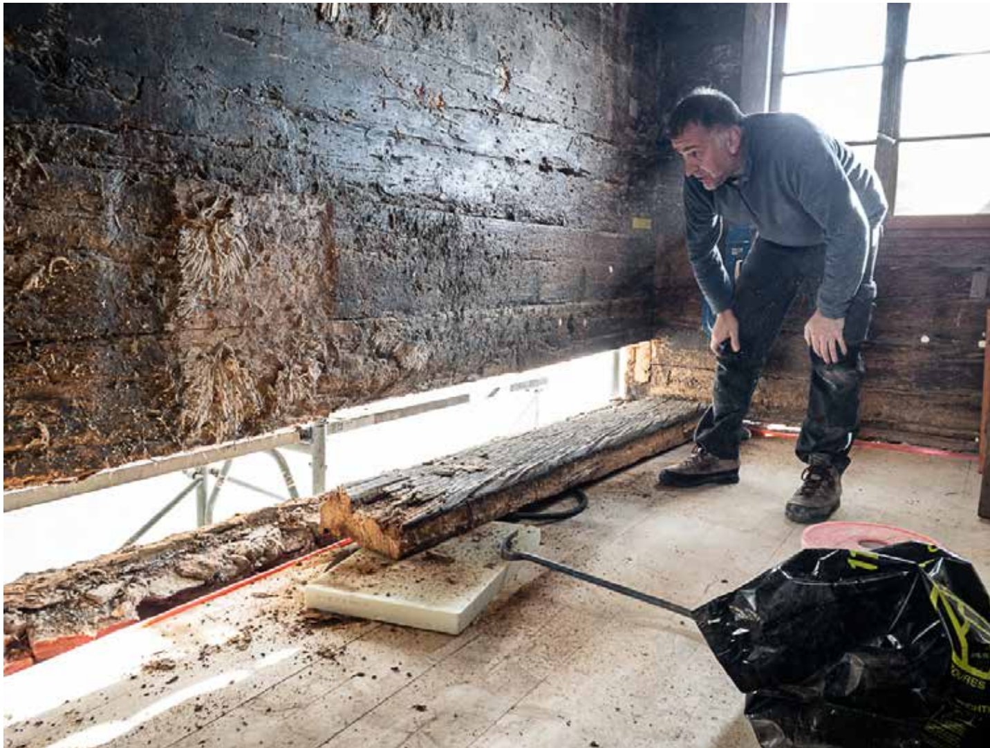
20.03.2023 – OG – Auswechseln der morschen Strickelemente
