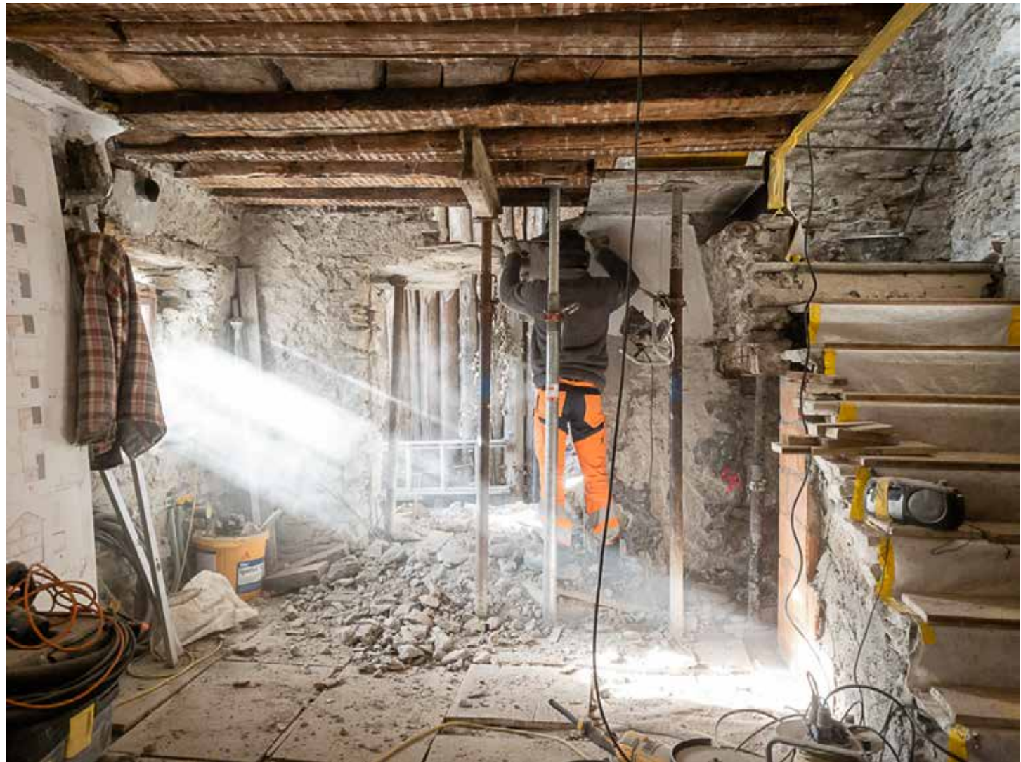
15.03.2023 – EG – Partielle Öffnung der Aussenmauer beim Annex
