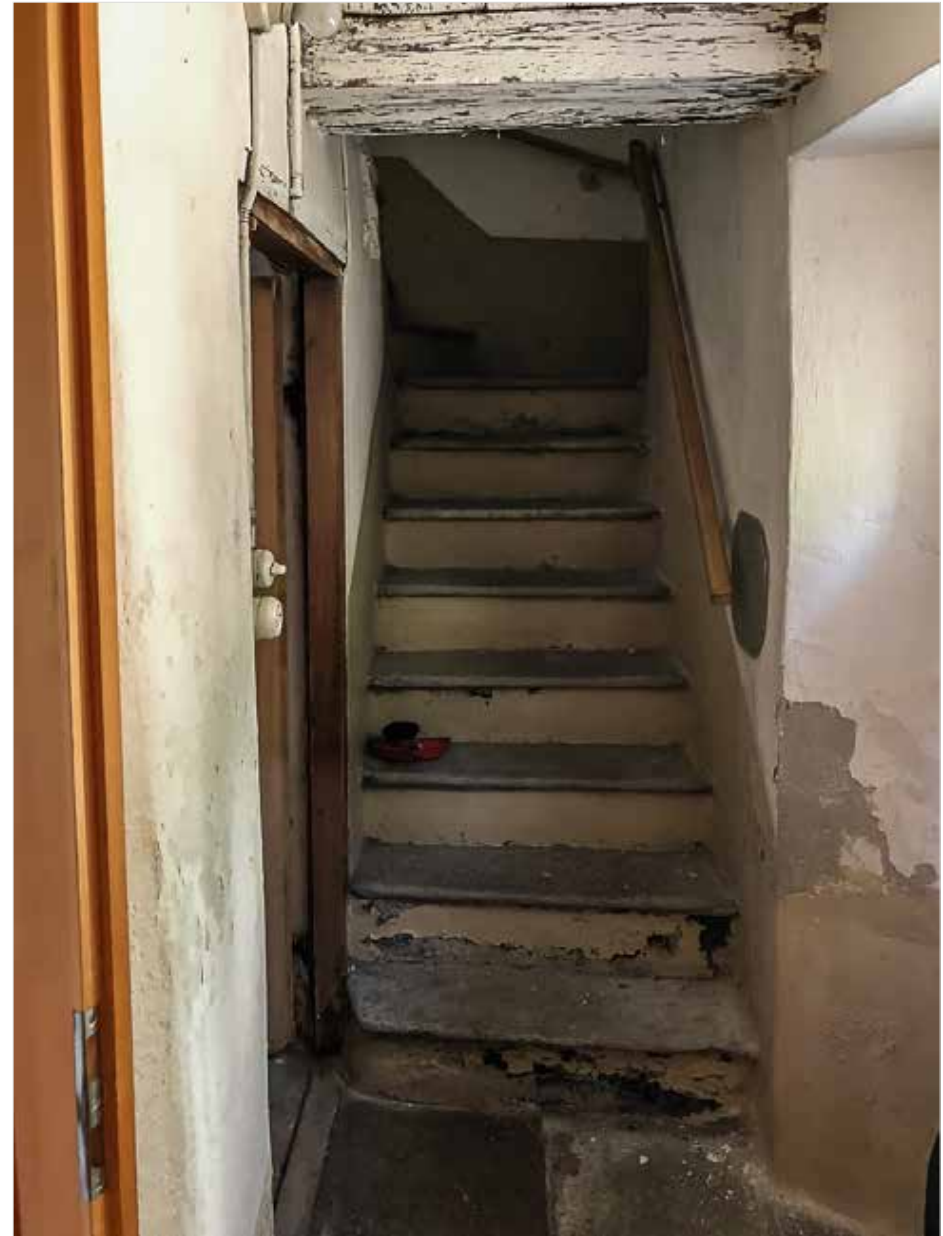
EG Eingangsbereich mit Treppe in das OG
