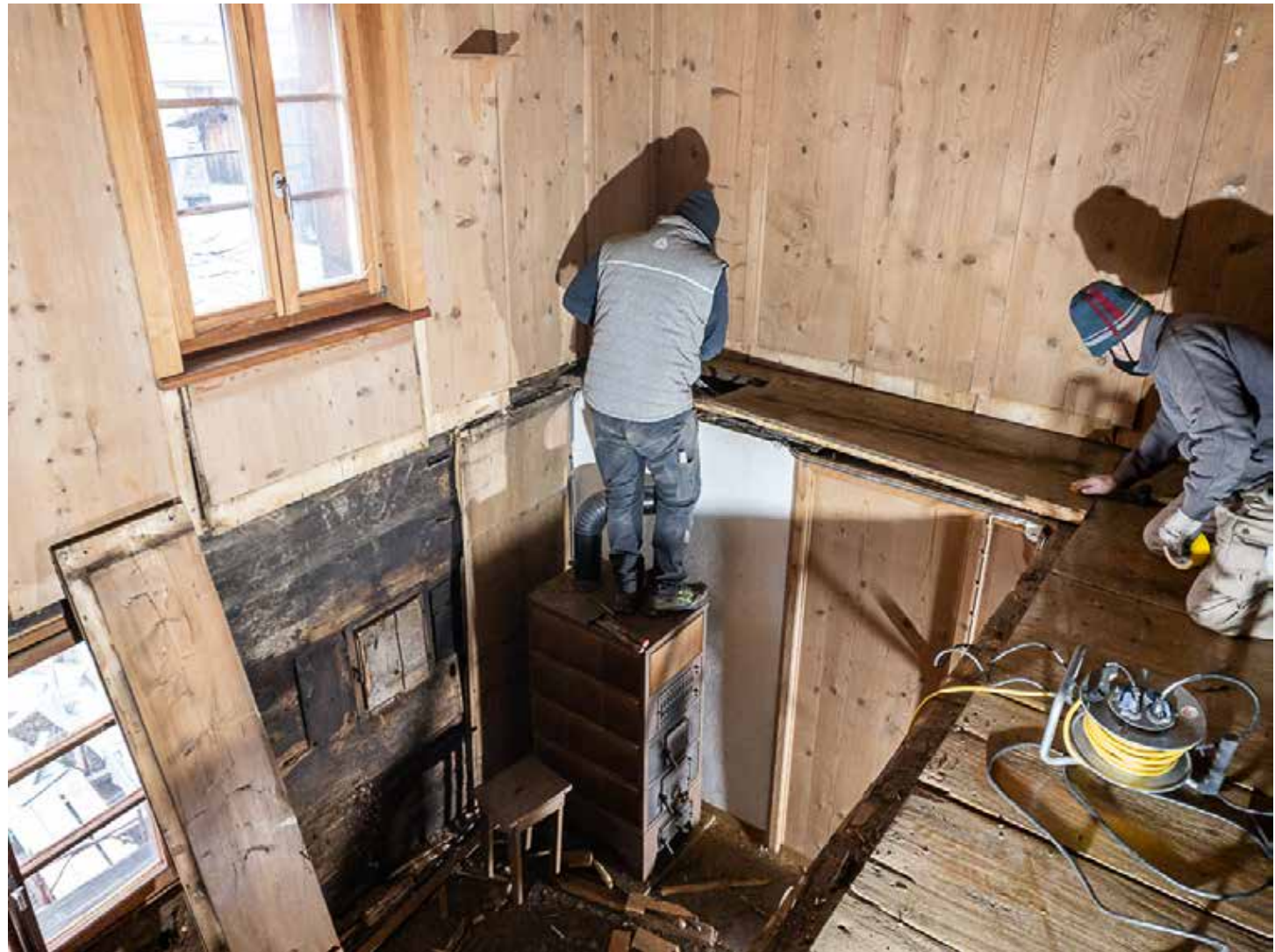
21.12 .2021 - DG - Sorgfältiges Entfernen des Riemenbodens
