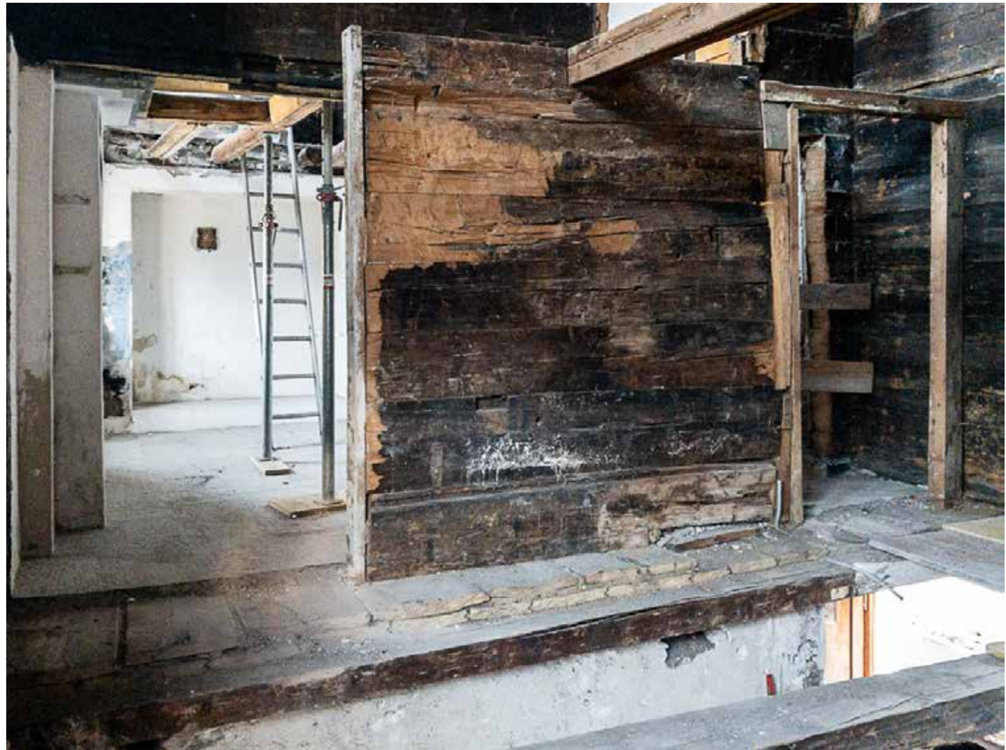
08.02.2022 – OG – Entfernung Gipsstellwand Kachelofen und Bretterboden
