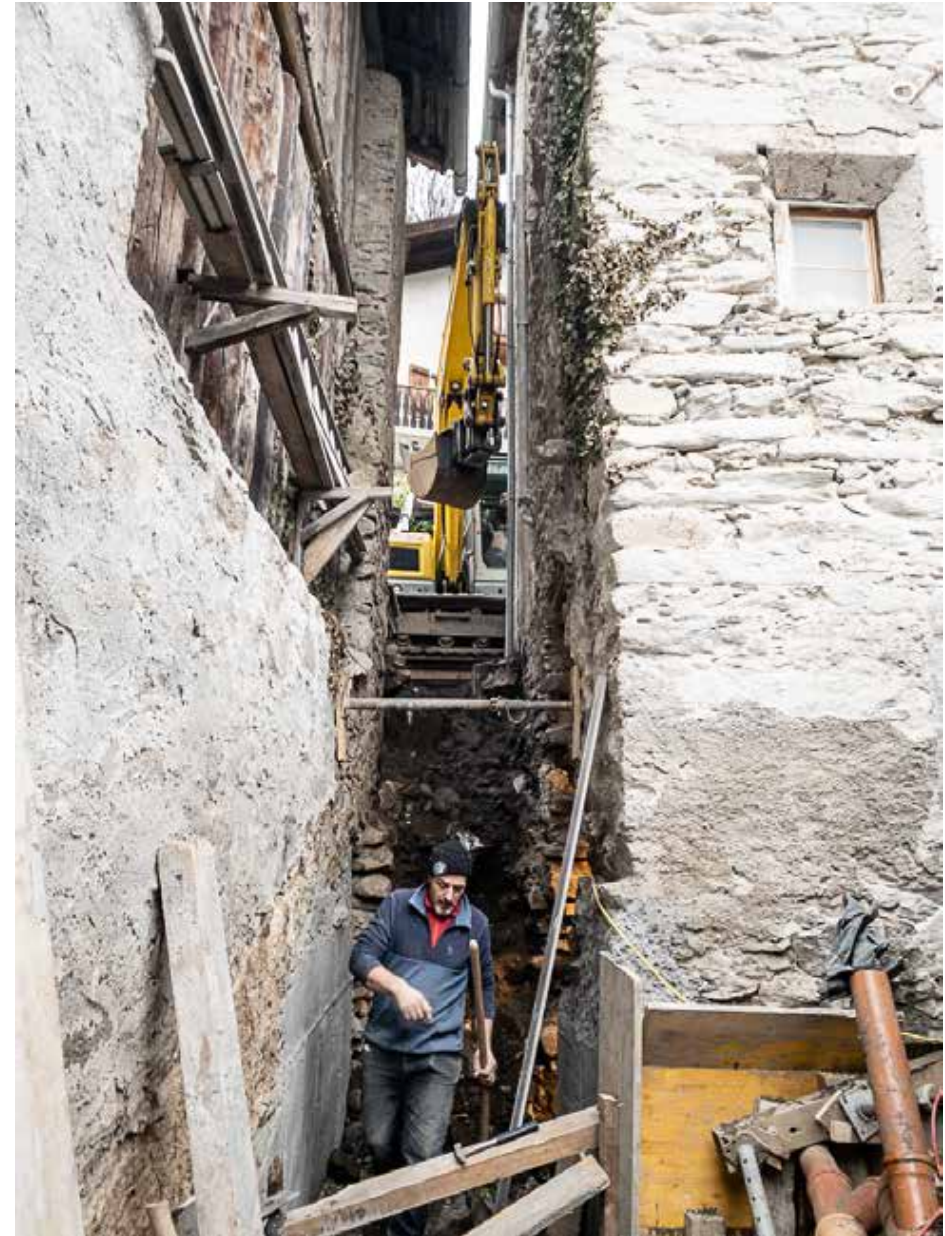
21.11.2022 – Baggerführer mit viel Fingerspitzengefühl
