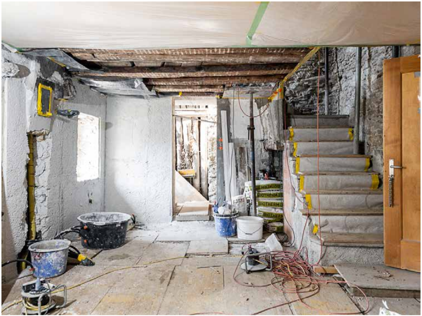
02.05.2023 – EG – Auftragen von Biotherm Wärmedämmputz
