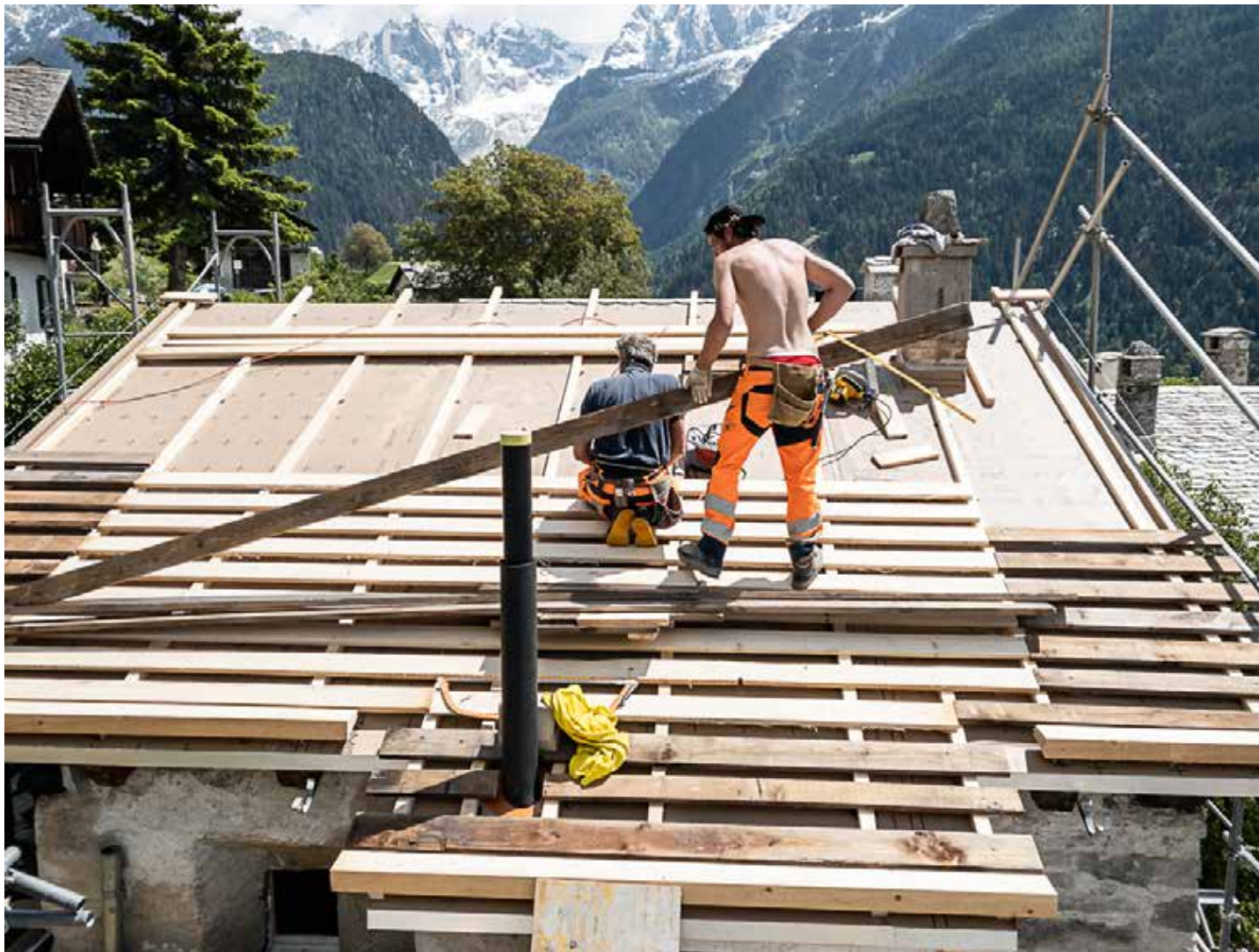
02.06.2023 – DG – Anbringen der Querlatten für die Steinplatten
