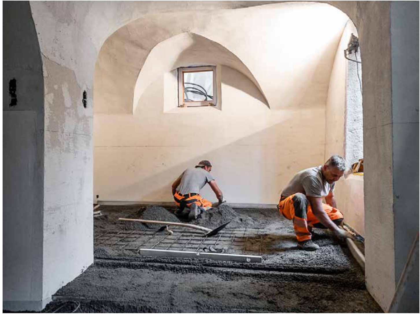
25.05.2023 – UG – Einbringen des Zementbodens
