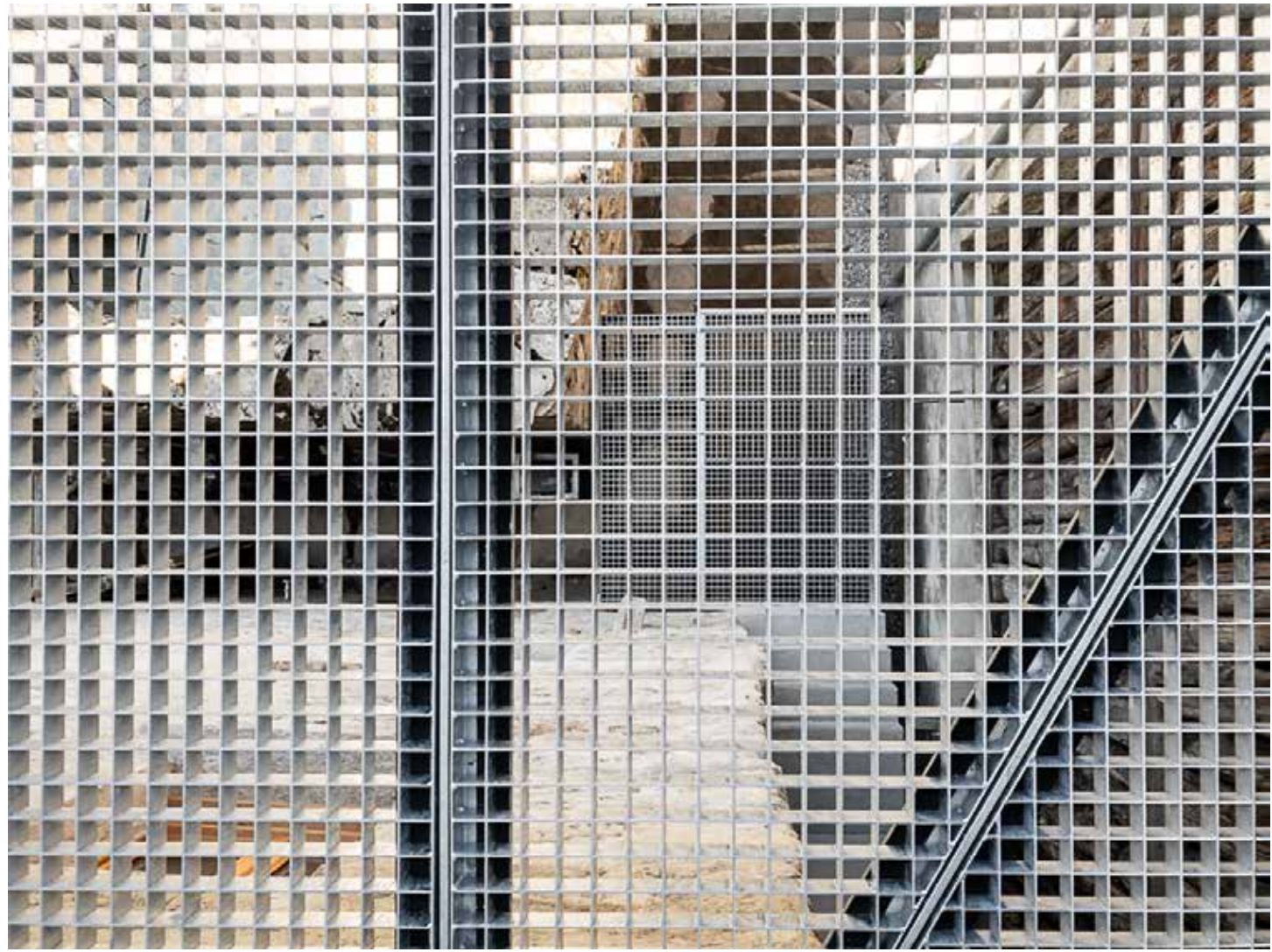
16.08.2023 – DG – Montage der Gitterroste auf der Terrasse und dem Podest
