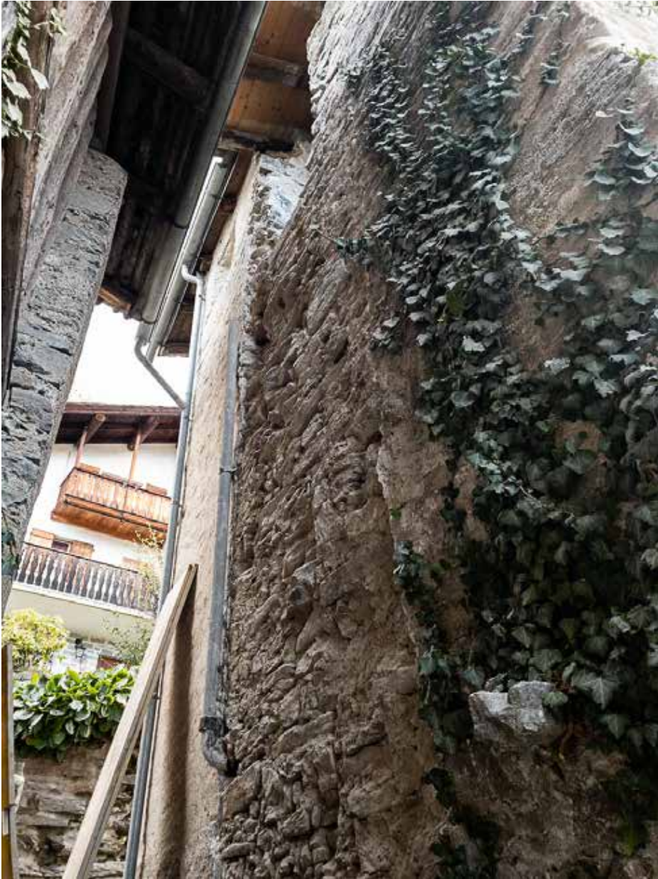
26.10.2023 – Freigelegte West-Fassade ohne Abort
