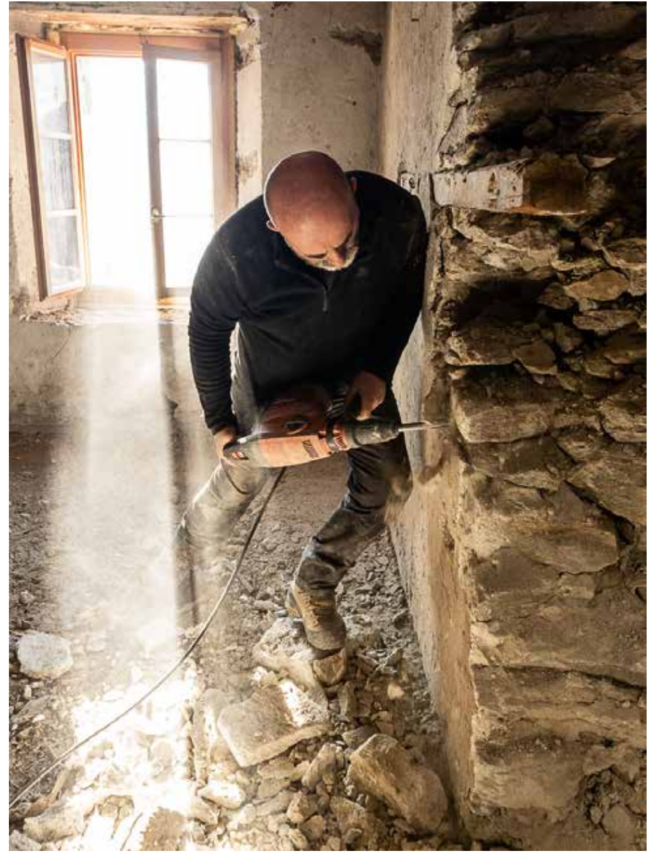
10.02.2022 – EG – Abbruch der massiven Stein-Zwischenwand
