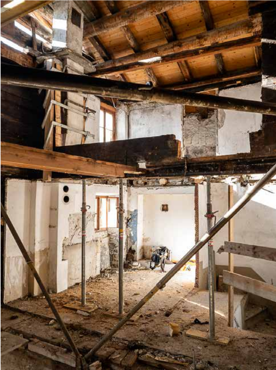
10.02.2022 – OG – Freier Blick durch die Geschosse
