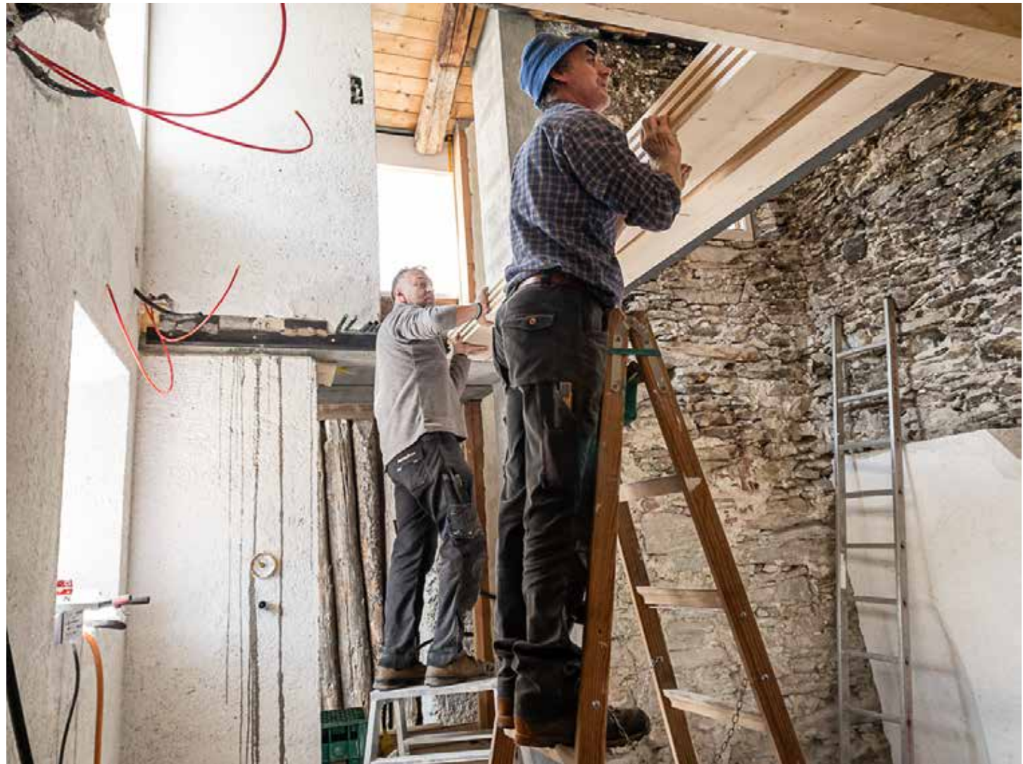
26.05.2023 – OG – Montage der Holzbalkendecke
