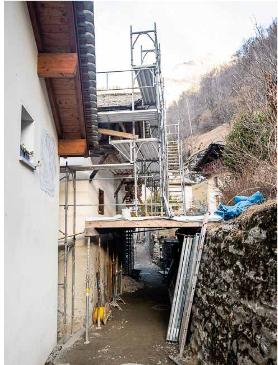
17.02.2023 – Erstellen einer Passerelle und Aufbau eines Gerüsts
