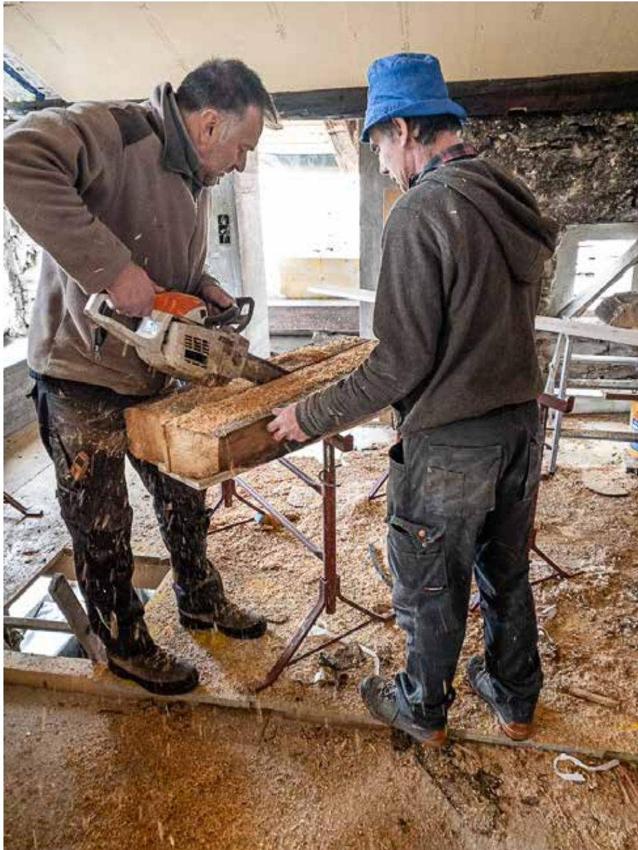
02.05.2023 – DG – Einpassen von neuen alten Firstbalken
