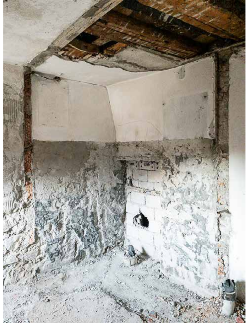
08.02.2022 – EG – Abbruch Sanitärkabine und Freilegung der Wände
