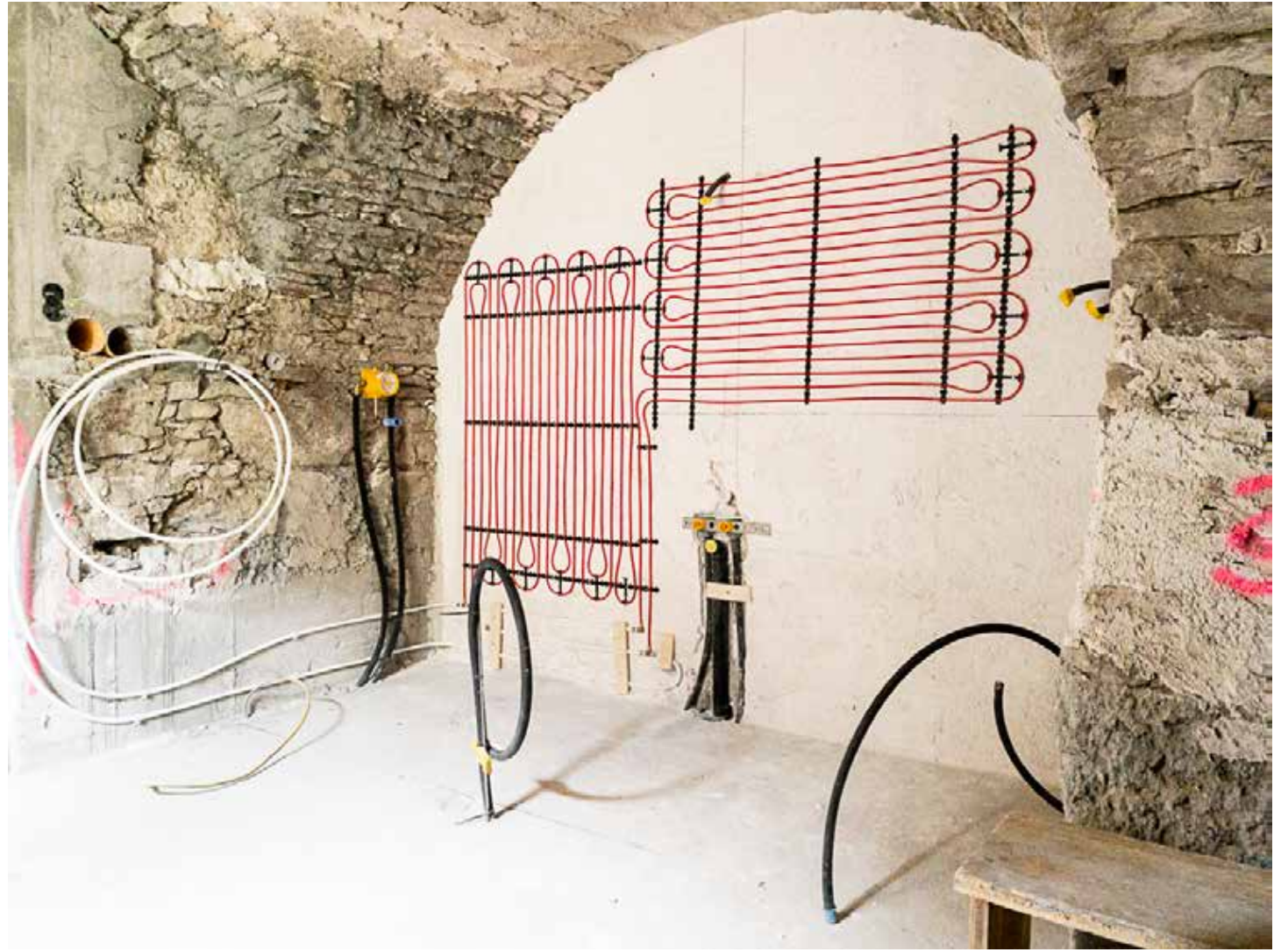
14.04.2023 – UG – Montage Wandheizung
