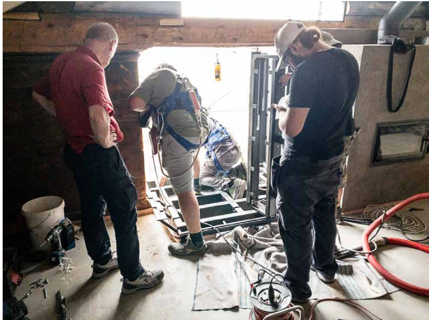
18.07.2023 – DG – Montage Stahlkonstruktion auskragendes Fenster
