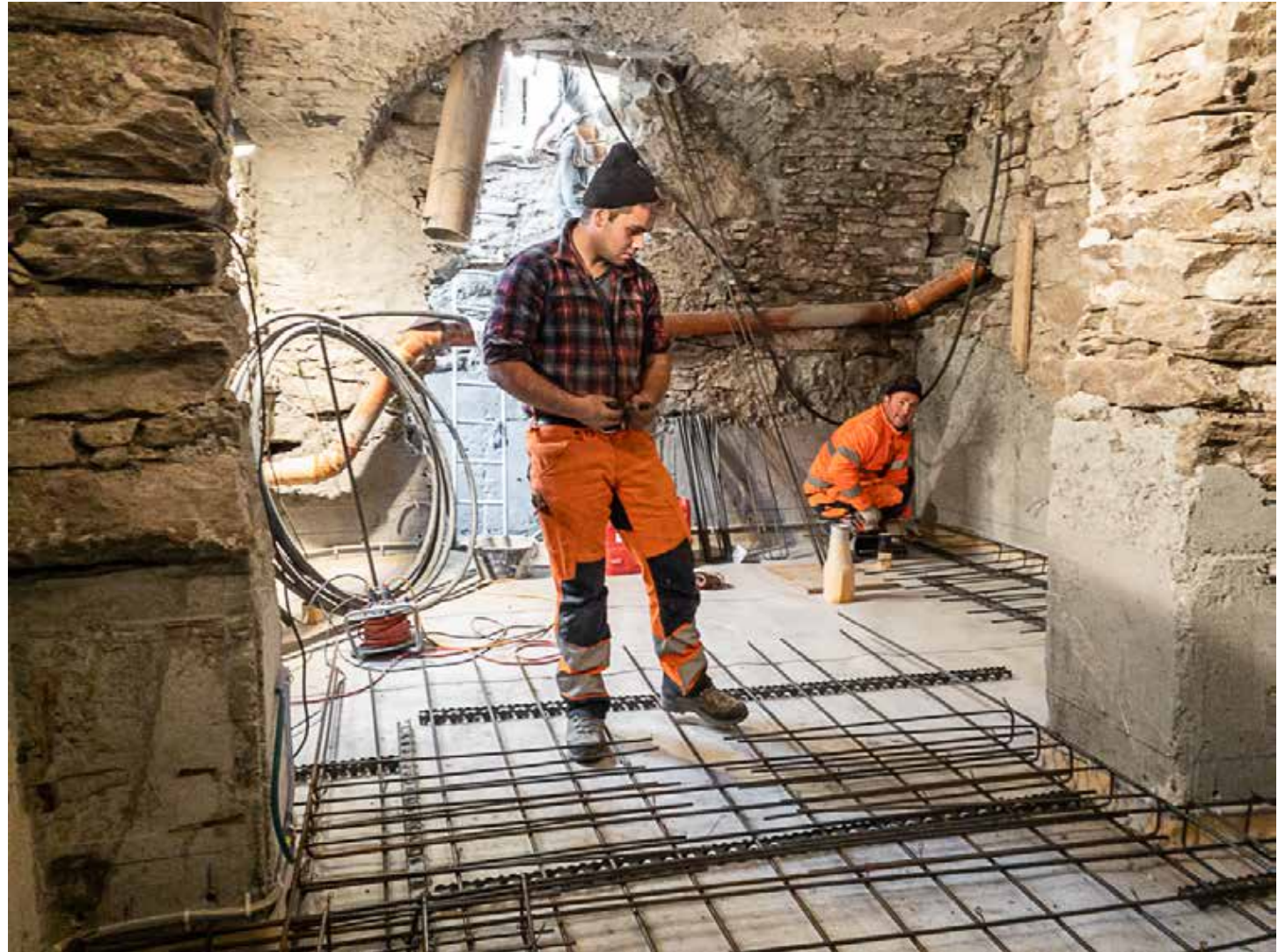
23.11.2022 – UG – Verlegen der Armierungseisen
