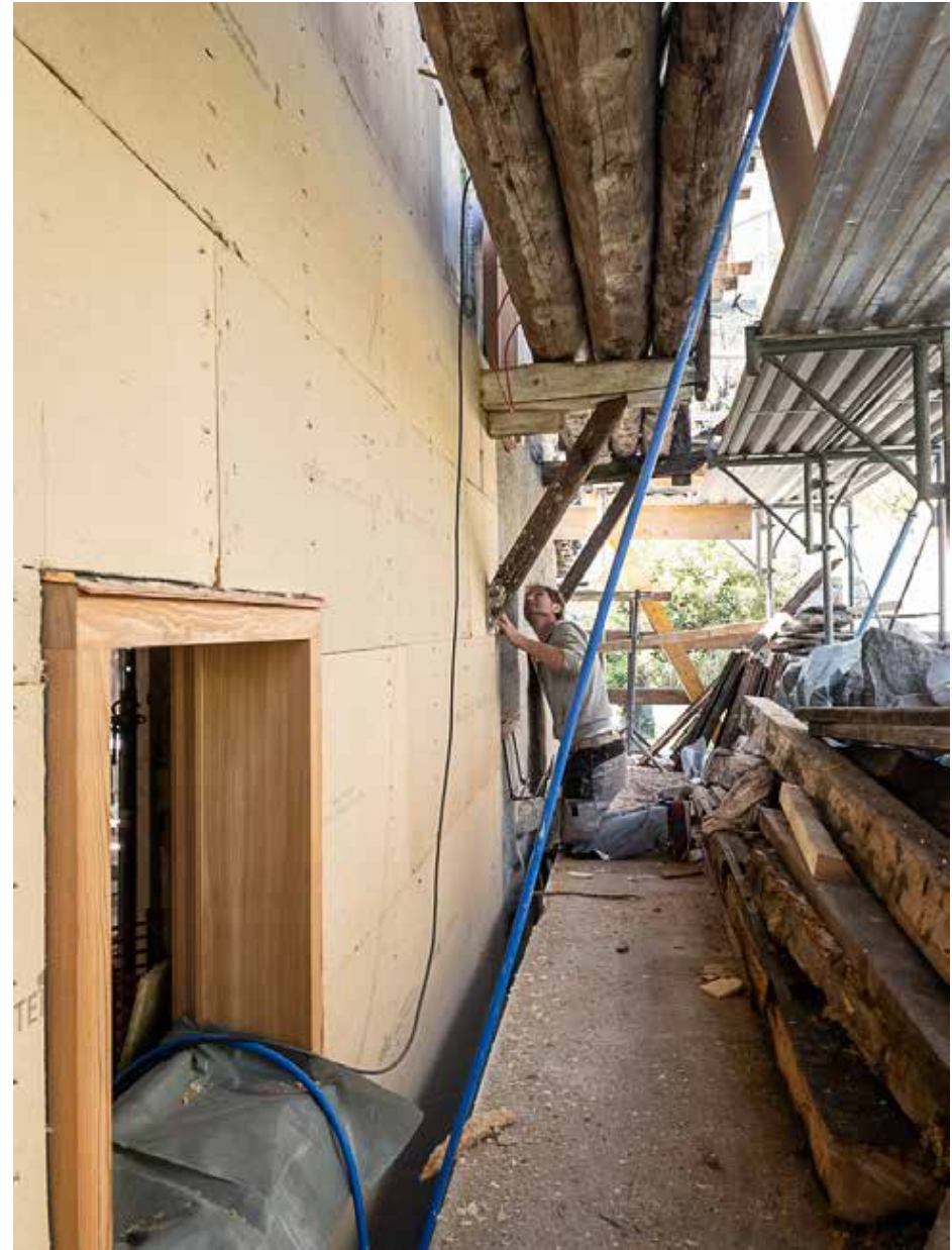
04.05.2023 – OG – Montage WDV S Steico Platten
