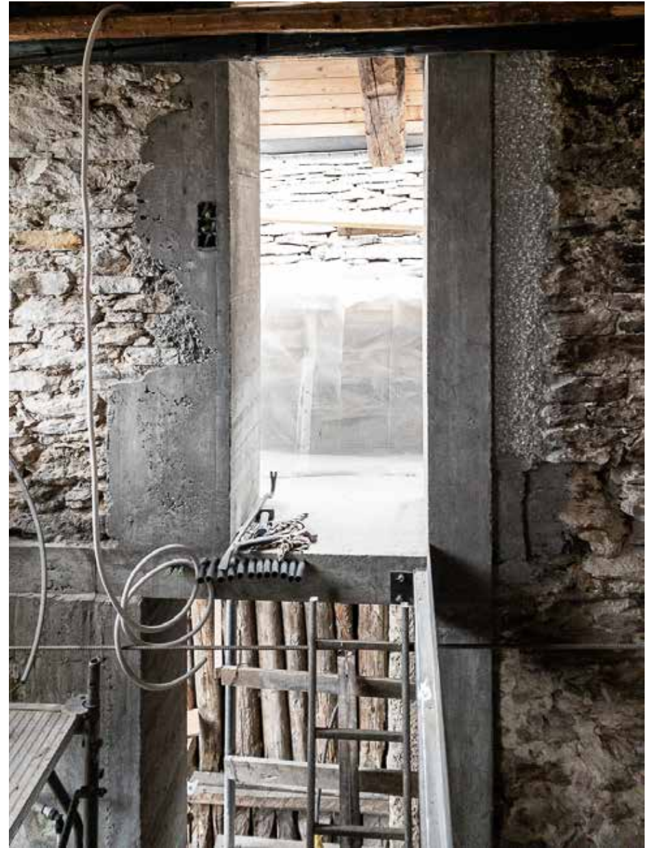
12.04.2023 – DG – Betonierte Fassadenöffnungen mit Podest
