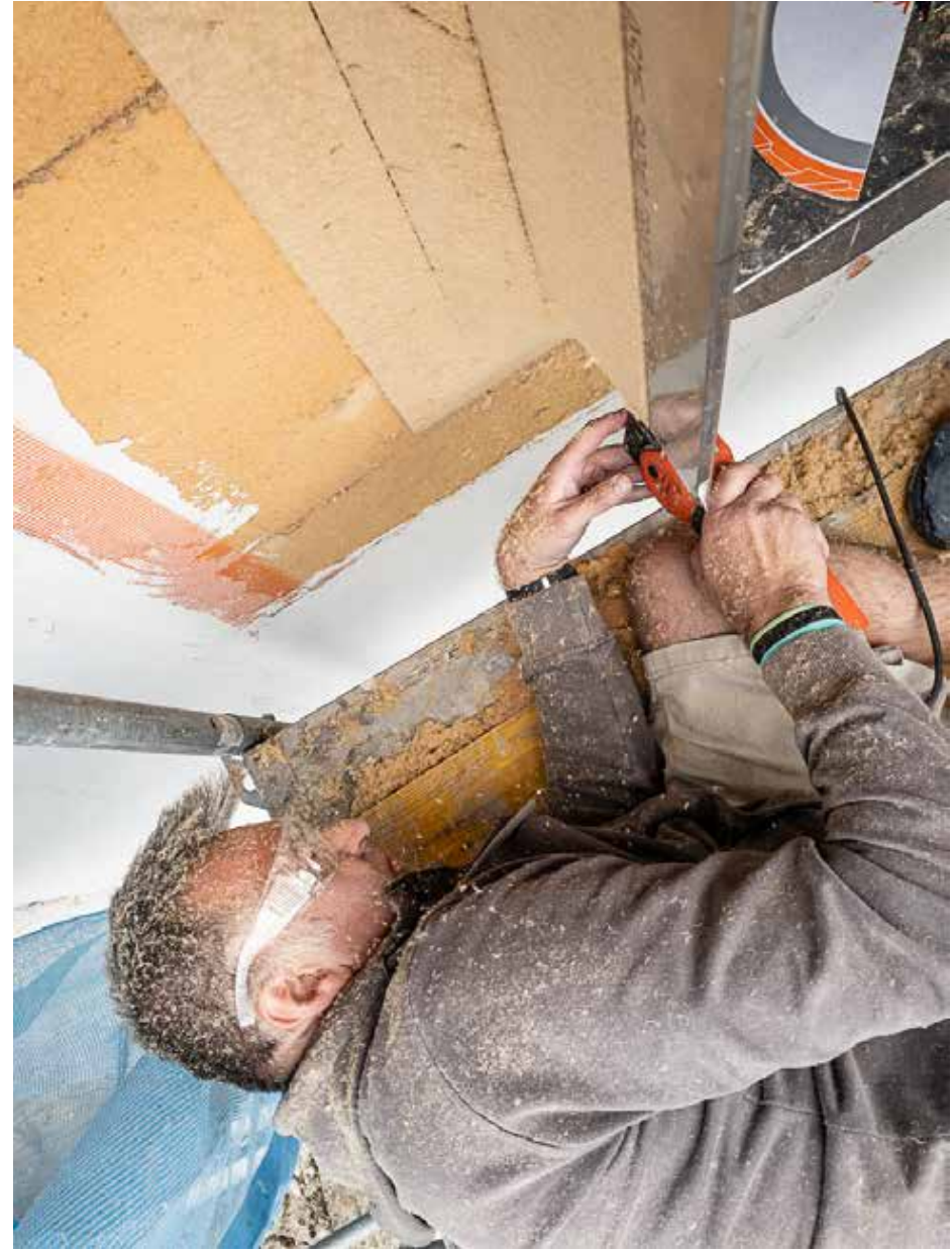
16.06.2023 – DG – Erstellen der Leibungsrundung mit Holzfaserplatten
