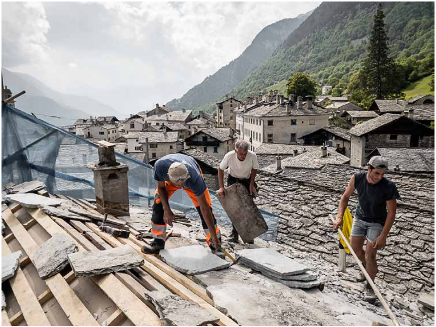
09.06.2023 – DG – Fertigstellen des Steindaches
