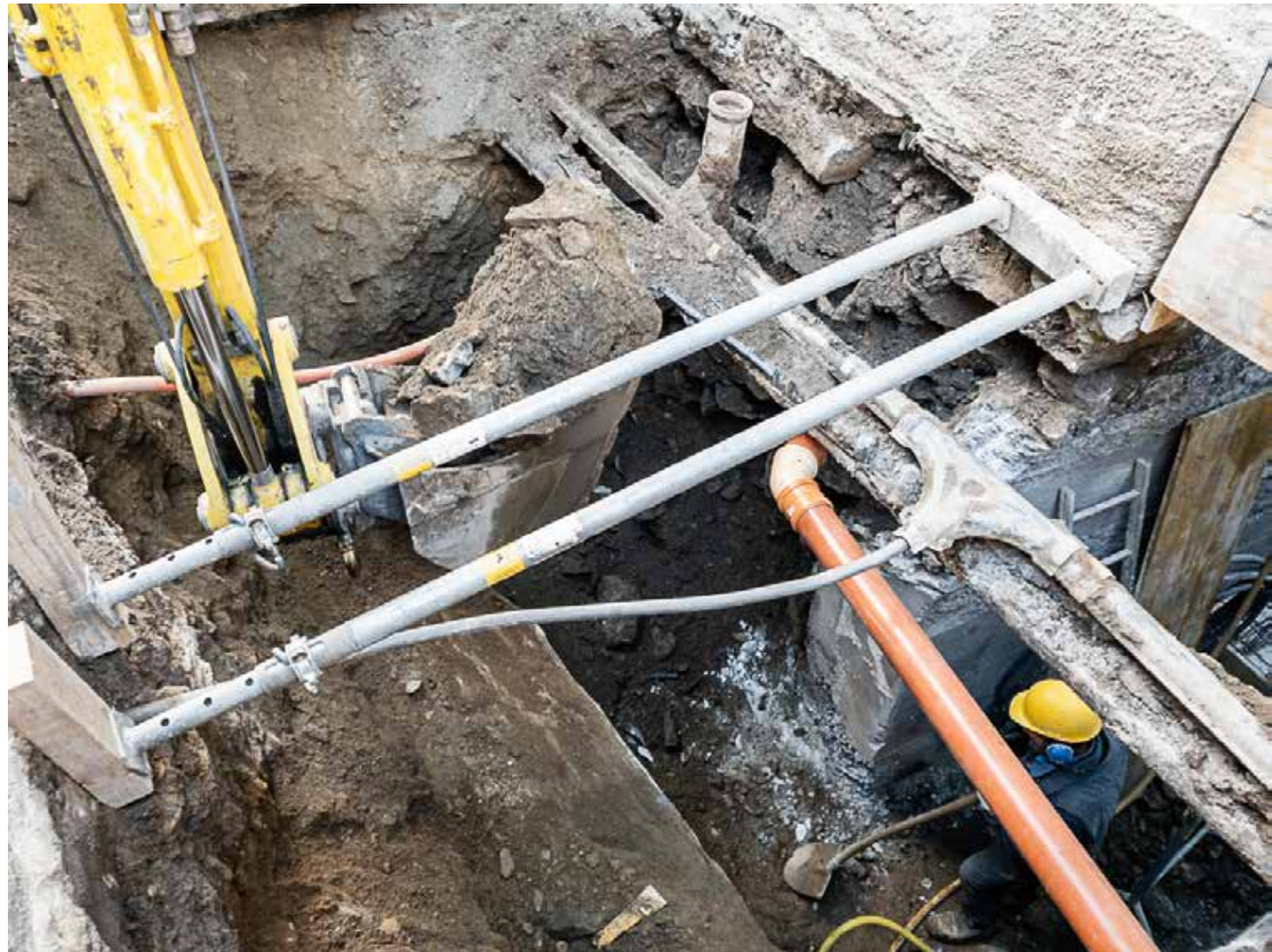
30.11.2022 – Aushub zwischen Elektro-Hauptleitungen, eine ruhige Hand ist von Vorteil
