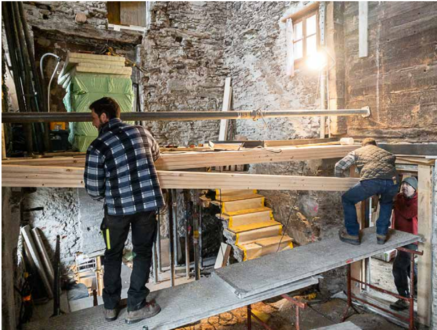
06.03.2023 - EG - Einbringen der Holzbalkendecke
