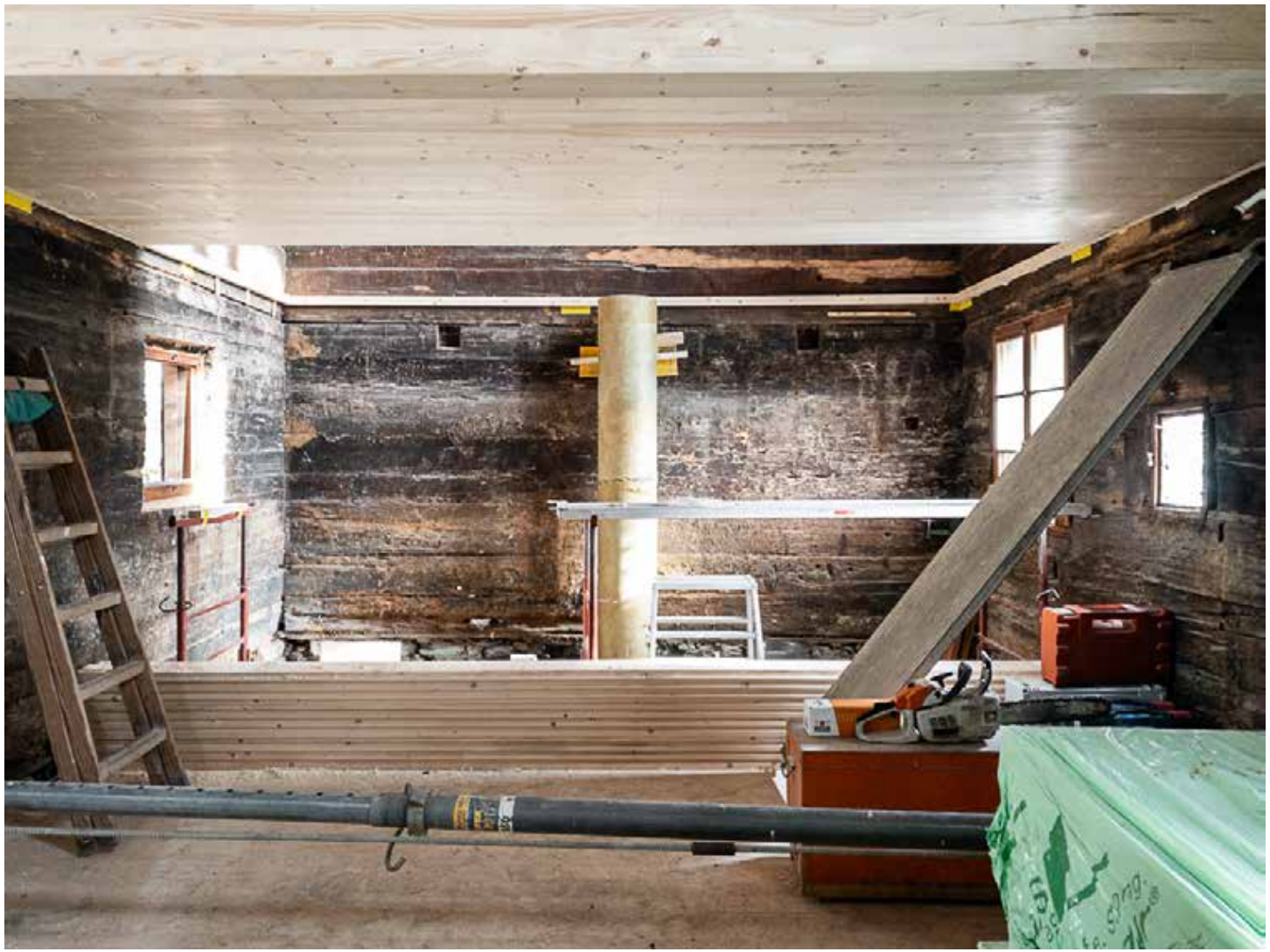
14.03.2023 – OG – Setzen des Kaminzuges
