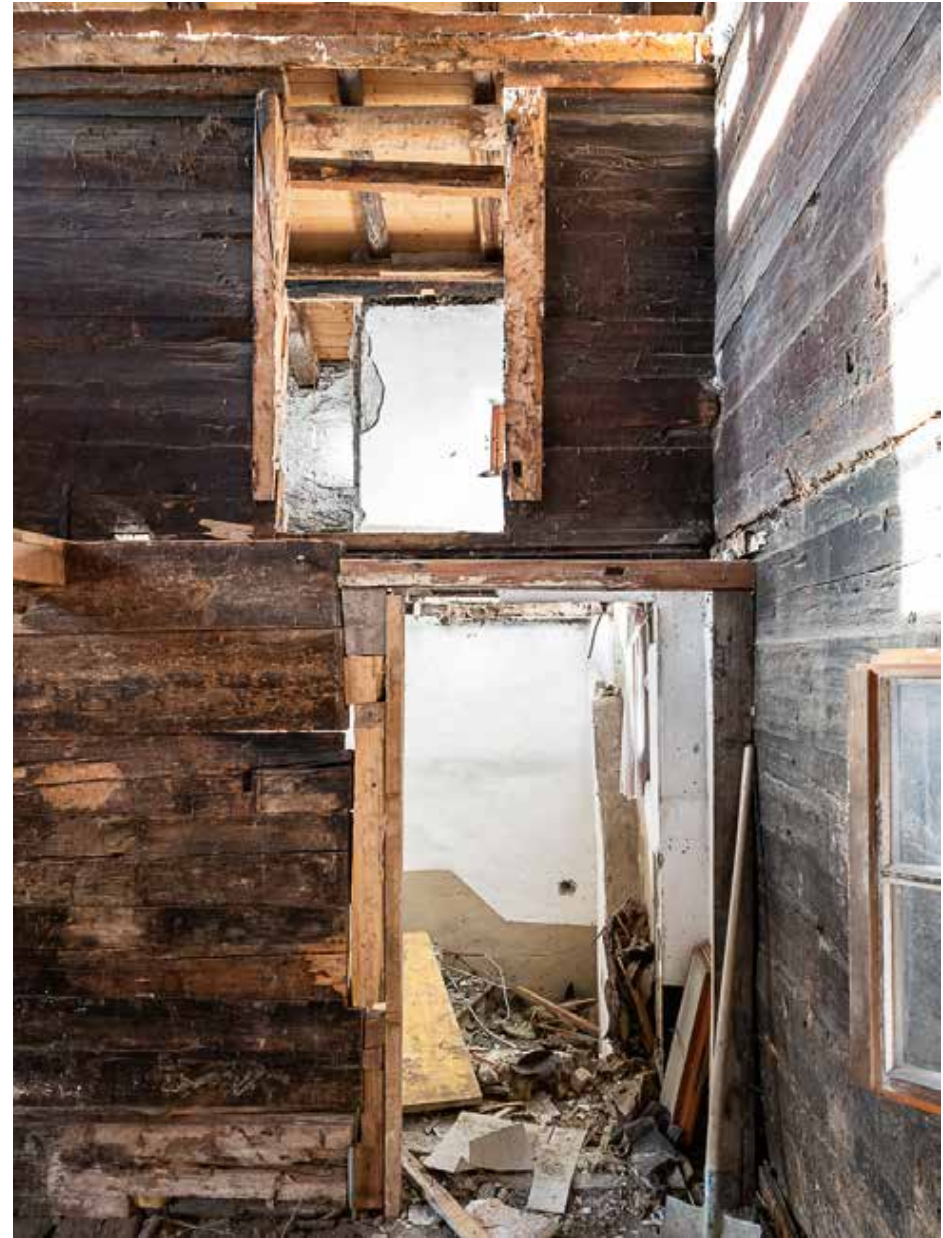
03.02.2022 – OG – Zerschnittener historischer Strick, Abbruch der Holztreppe ins DG
