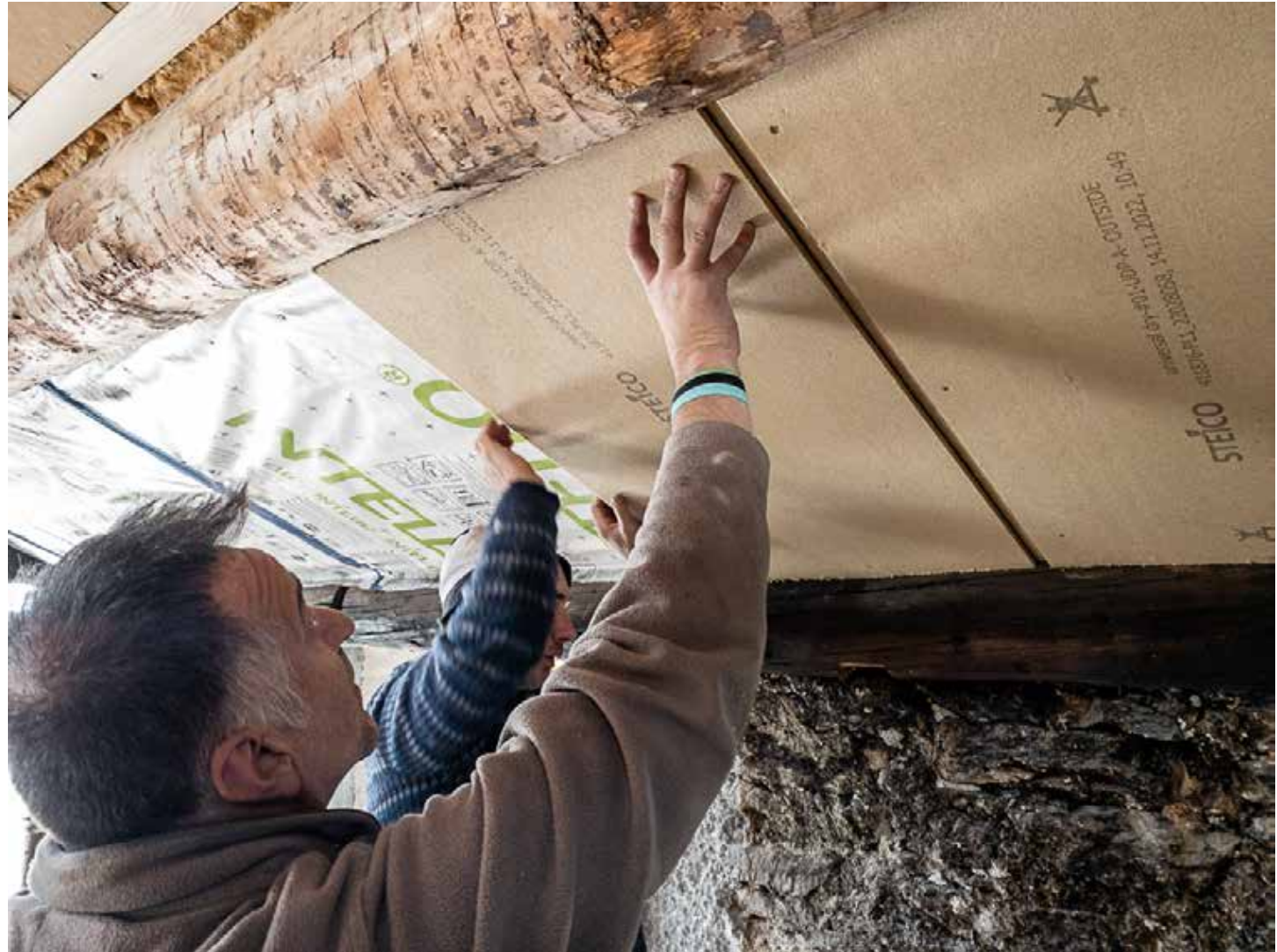
28.04.2023 – DG – Einpassen der Isolationselemente aus Holzfaser
