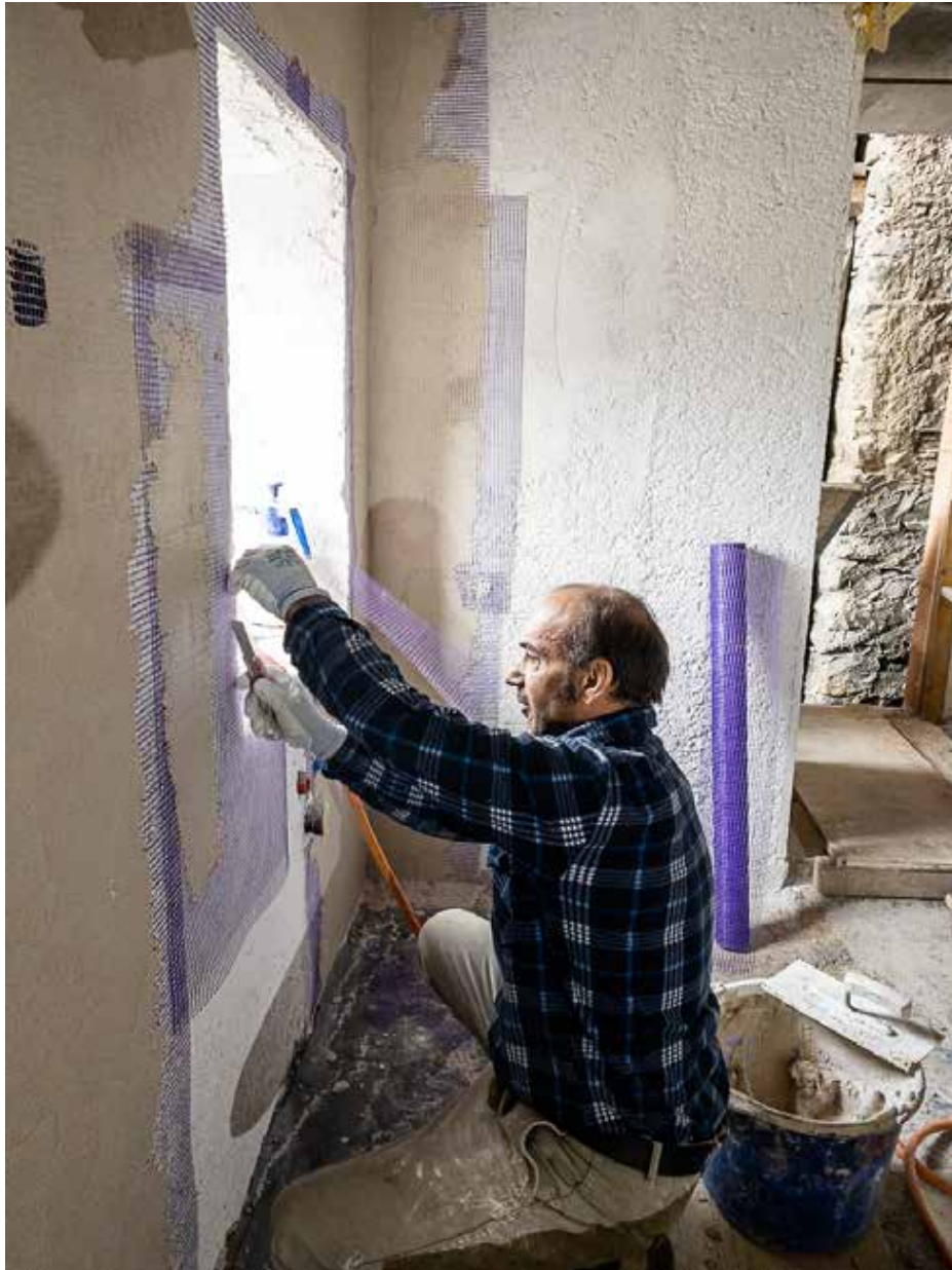
12.05.2023 – EG – Netzeinbettung mit Bio-Einbettmörtel
