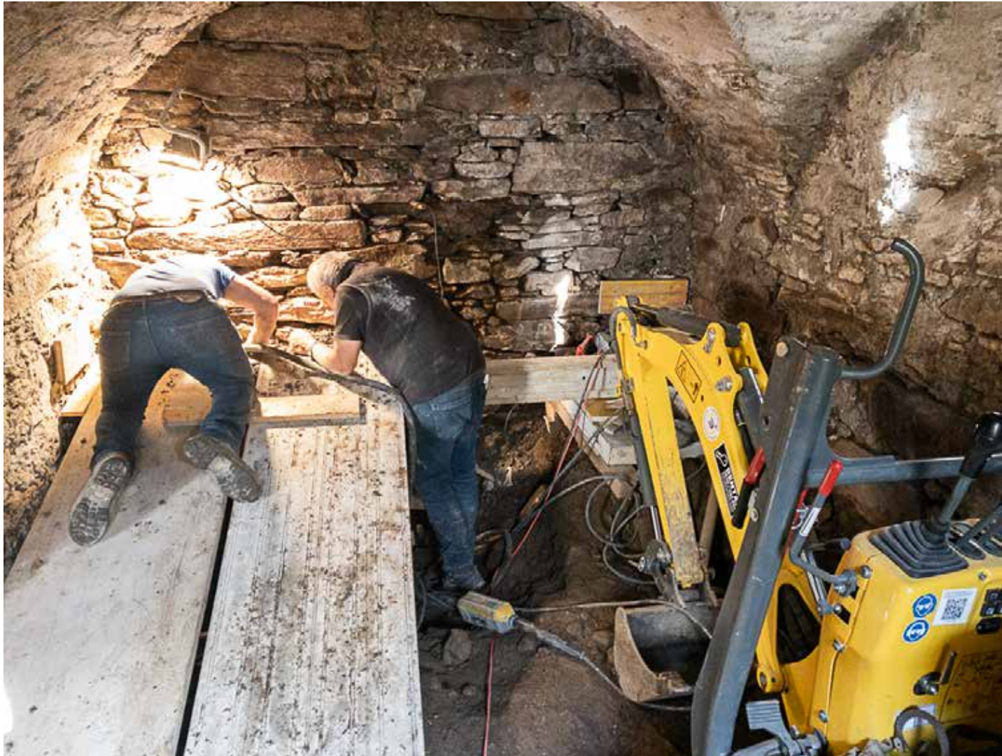
28.10.2022 – UG – Betonieren der Unterfangung bei den Grundmauern
