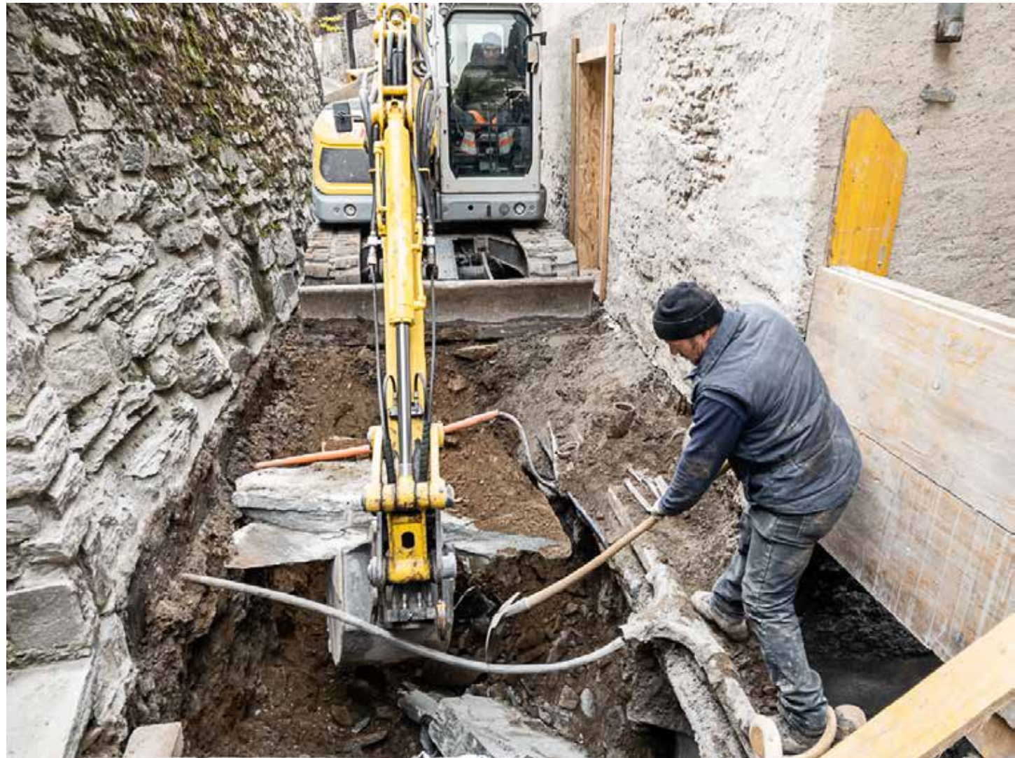
29.11.2022 – Entfernen der Felsbrocken zwischen den Gemeindeinfrastruktur
