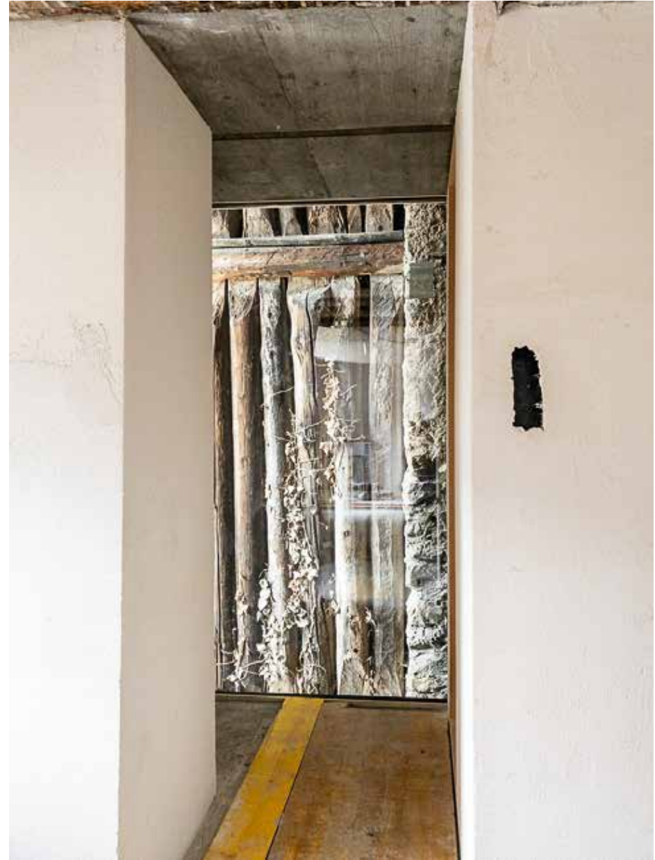
08.06.2023 – EG – Eingesetztes Glas im bündigen Fensterrahmen
