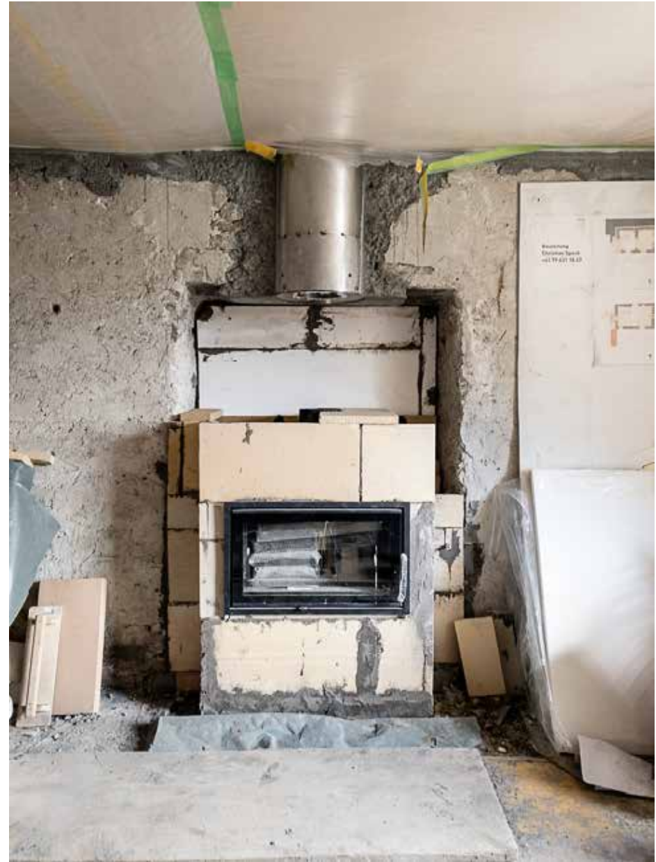
25.04.2023 – EG – Aufmauerung Speichercheminée
