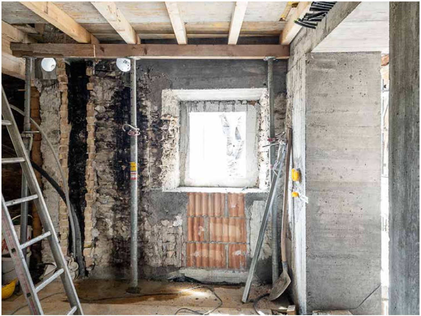
28.04.2023 - OG - Kernbohrungen für die Terrassenträger
