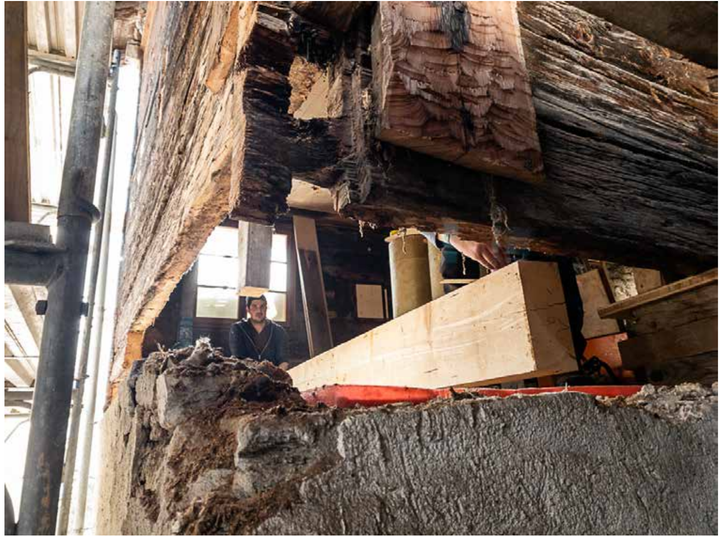
20.03.2023 – OG – Einsetzen der neuen Strickelemente
