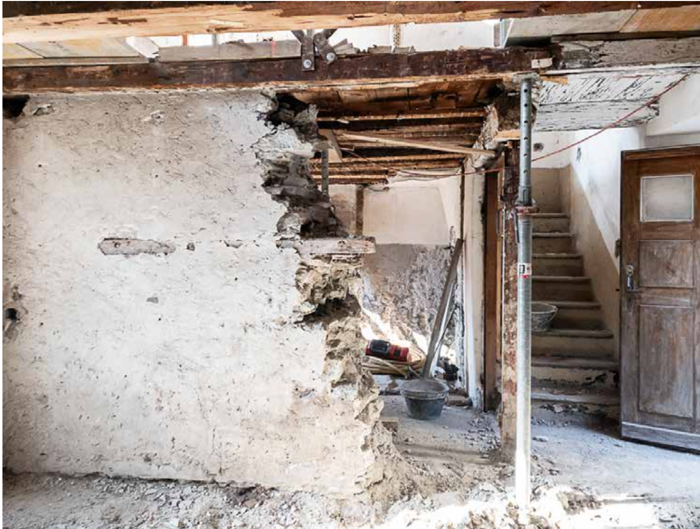
10.02.2022 – EG – Abbruch der tragenden und massiven Zwischenwand
