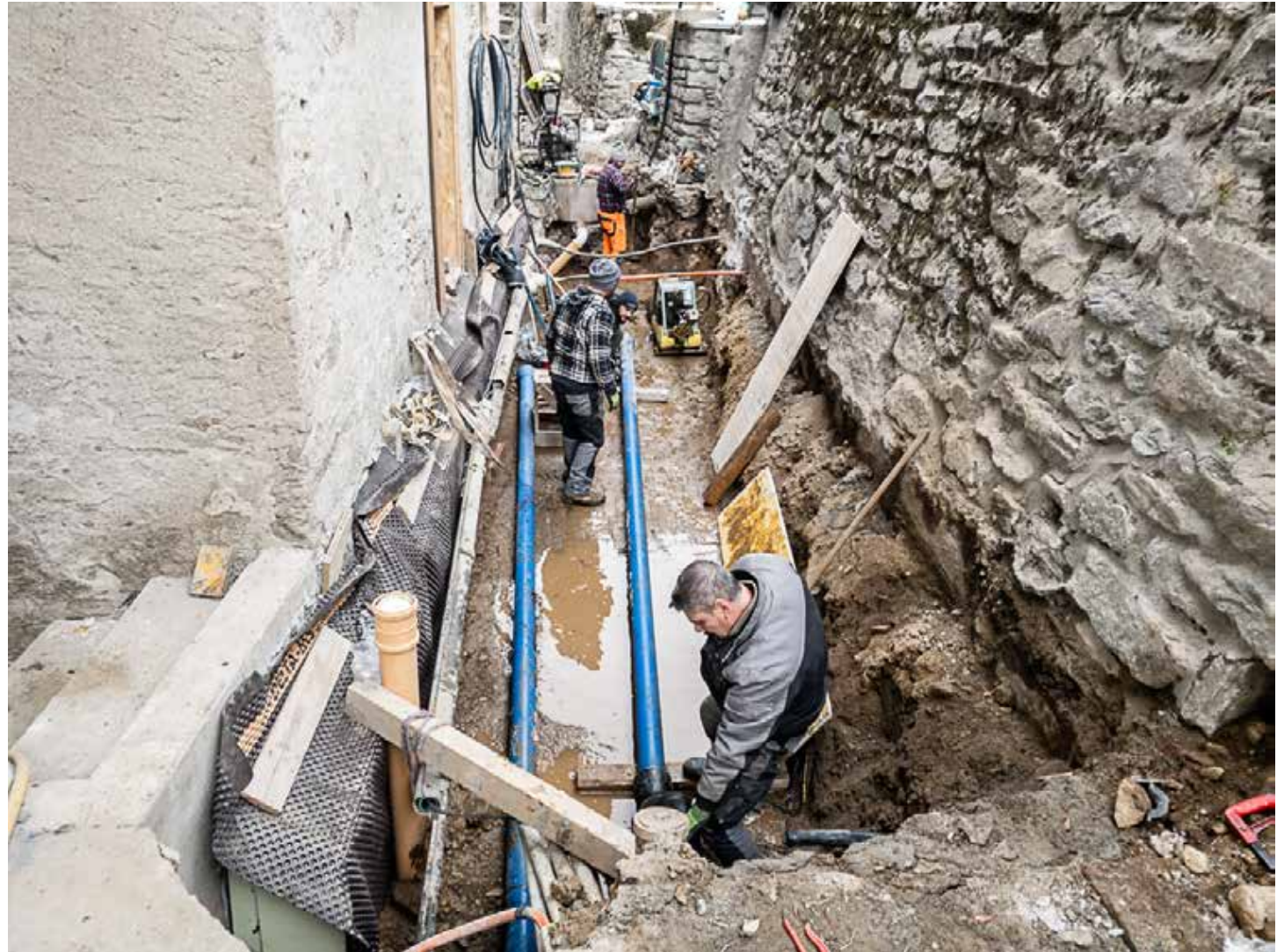
15.12.2021 – Verlegen der neuen kommunalen Wasserrohre
