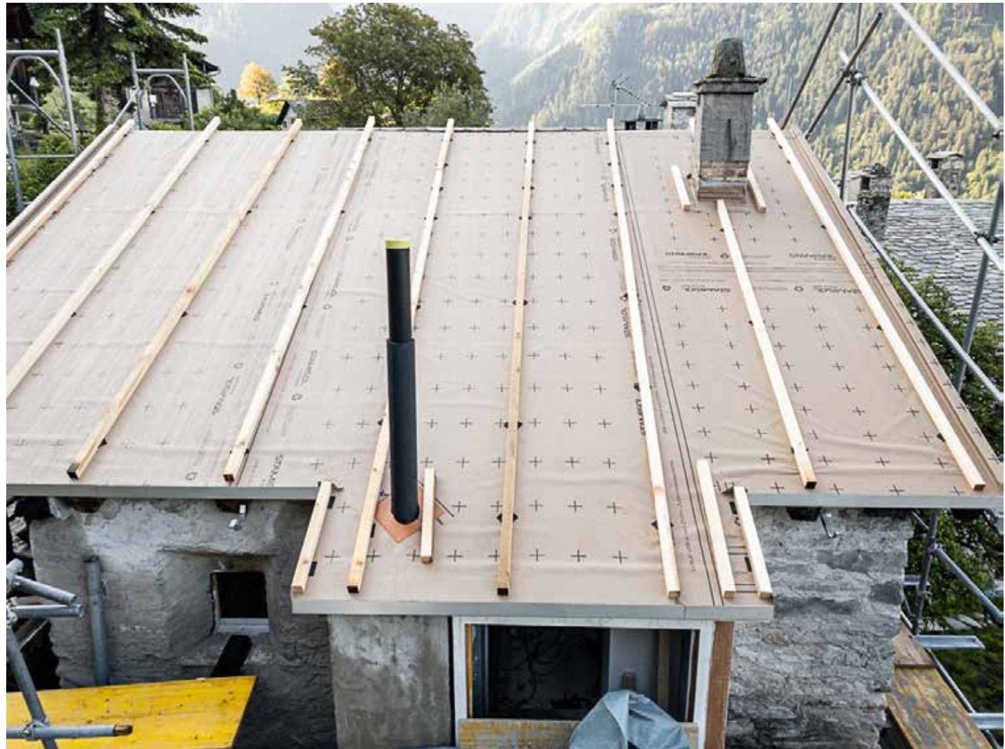
02.06.2023 – DG – Anbringen der Stamisol Abdichtung mit Konterlattung
