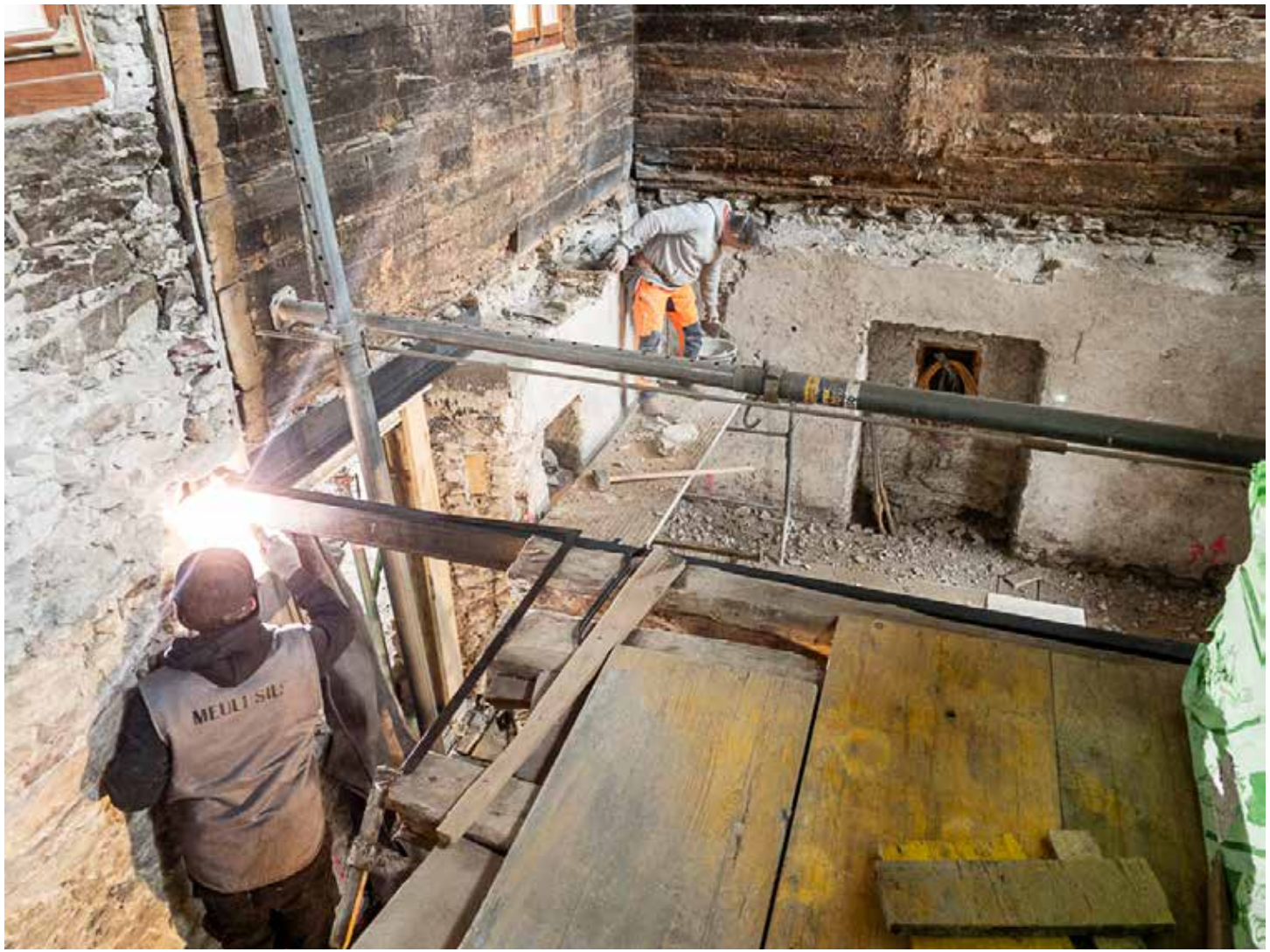
27.02.2023 - EG - Versetzen des neuen statischen Metallträgers
