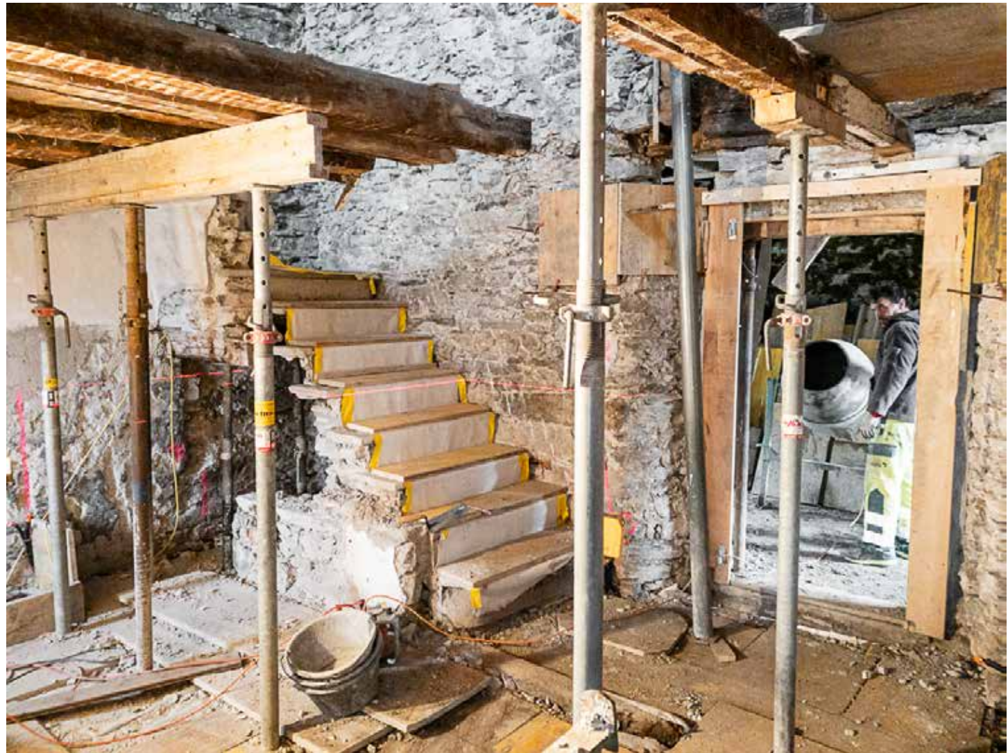
24.02.2023 – EG – Entfernen der statischen Holzträger
