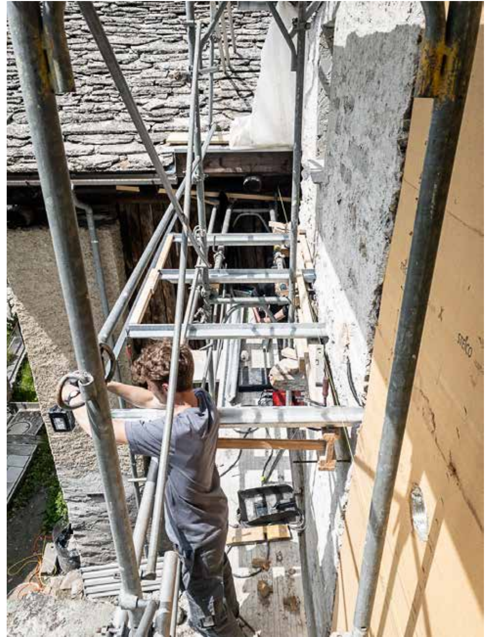
23.05.2023 – DG – Millimetergenaue Montage der Terrassenträger
