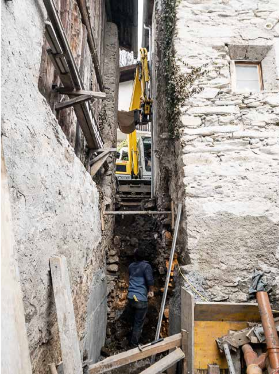
21.11.2022 – Baggerführer mit viel Fingerspitzengefühl
