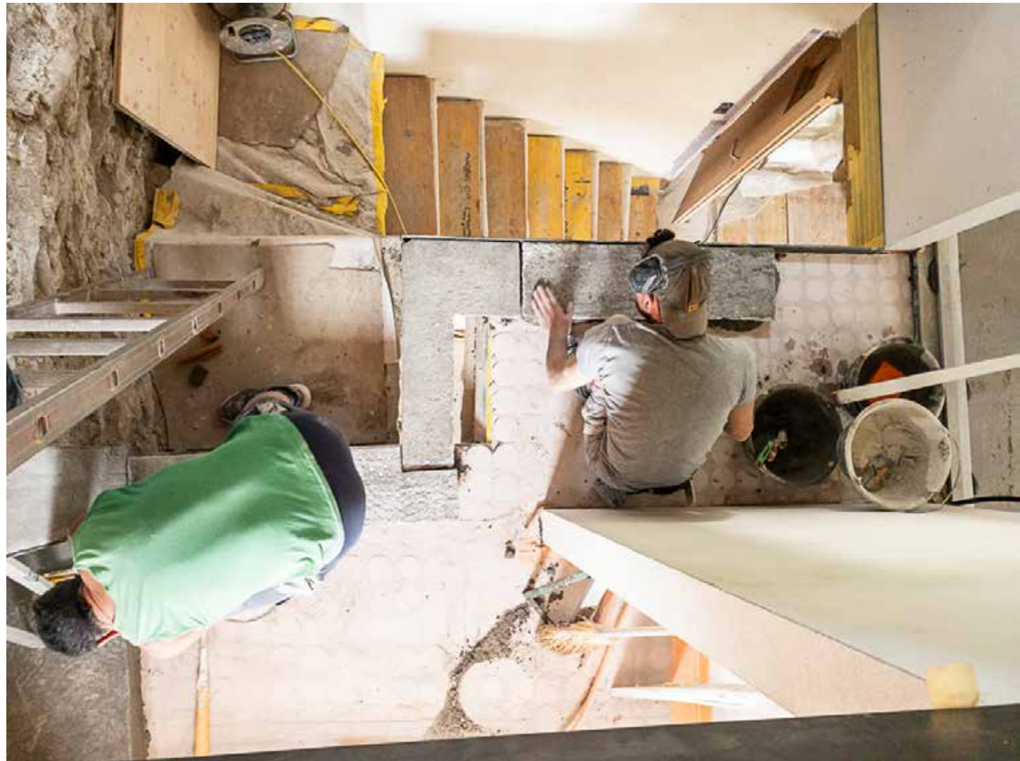
22.06.2023 – OG – Verlegen der bestehenden Steinplatten
