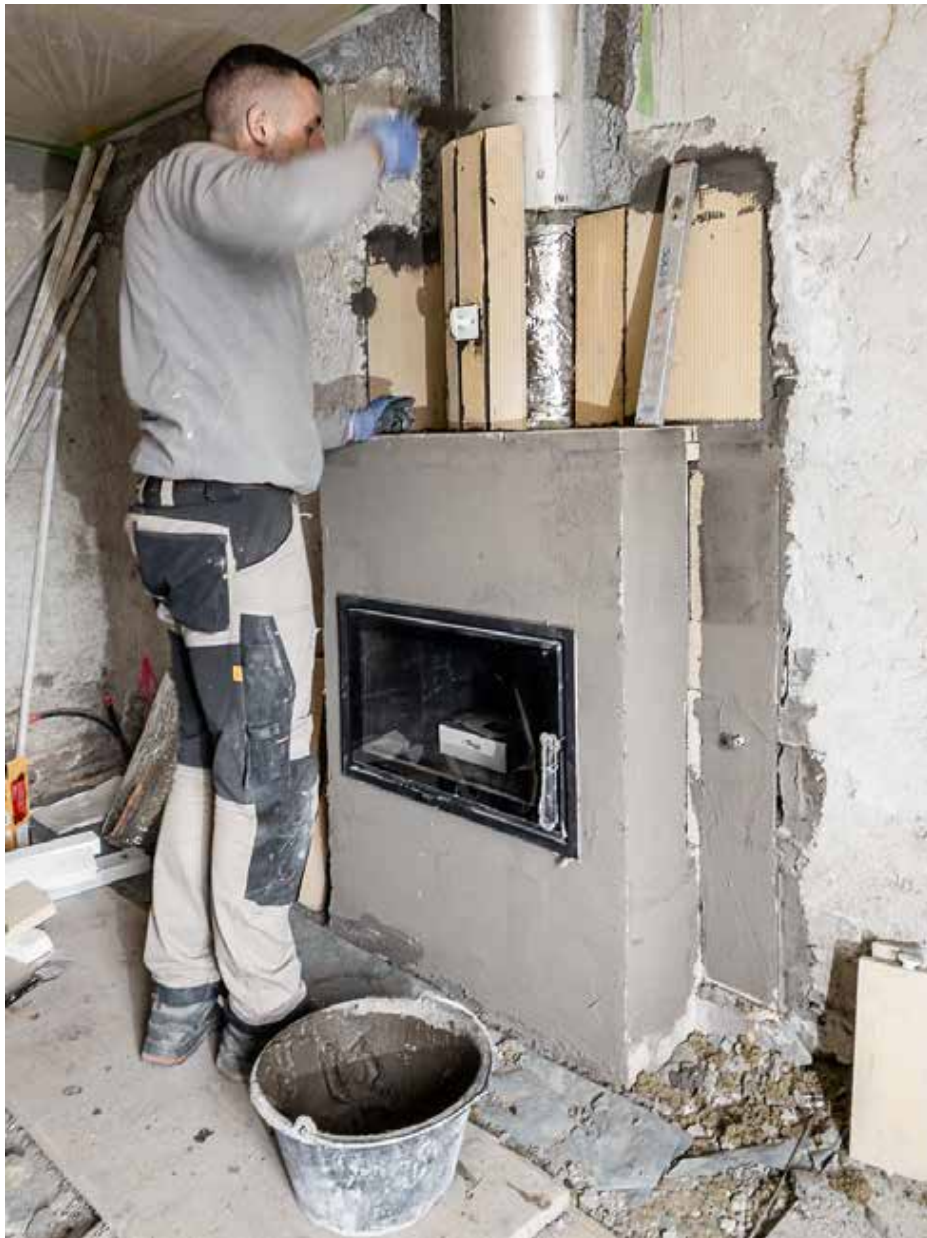
28.04.2023 – EG – Fertigstellung Speichercheminée
