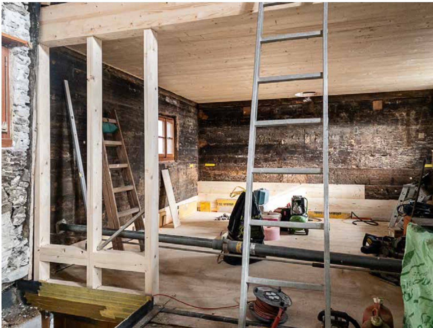
21.03.2023 – OG – Strickelemente abgesenkt und belastet
