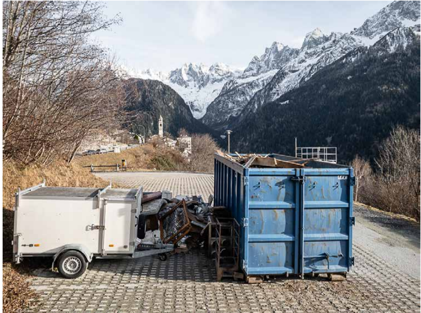
03.02.2022 – Wegführen des nicht benötigten Mobiliars und der Holzabfälle
