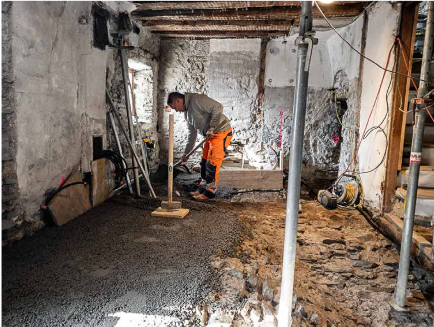
22.02.2023 - EG - Einbringen von Leccabeton und nivellieren der Geschosshöhe
