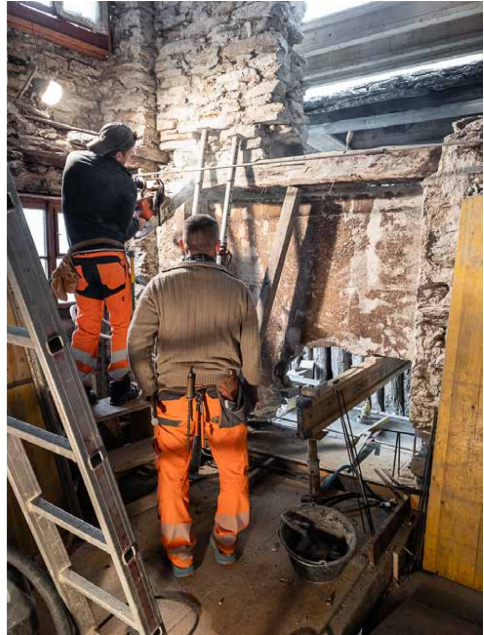
24.03.2023 – OG – Ausbrechen der Hausmauer
