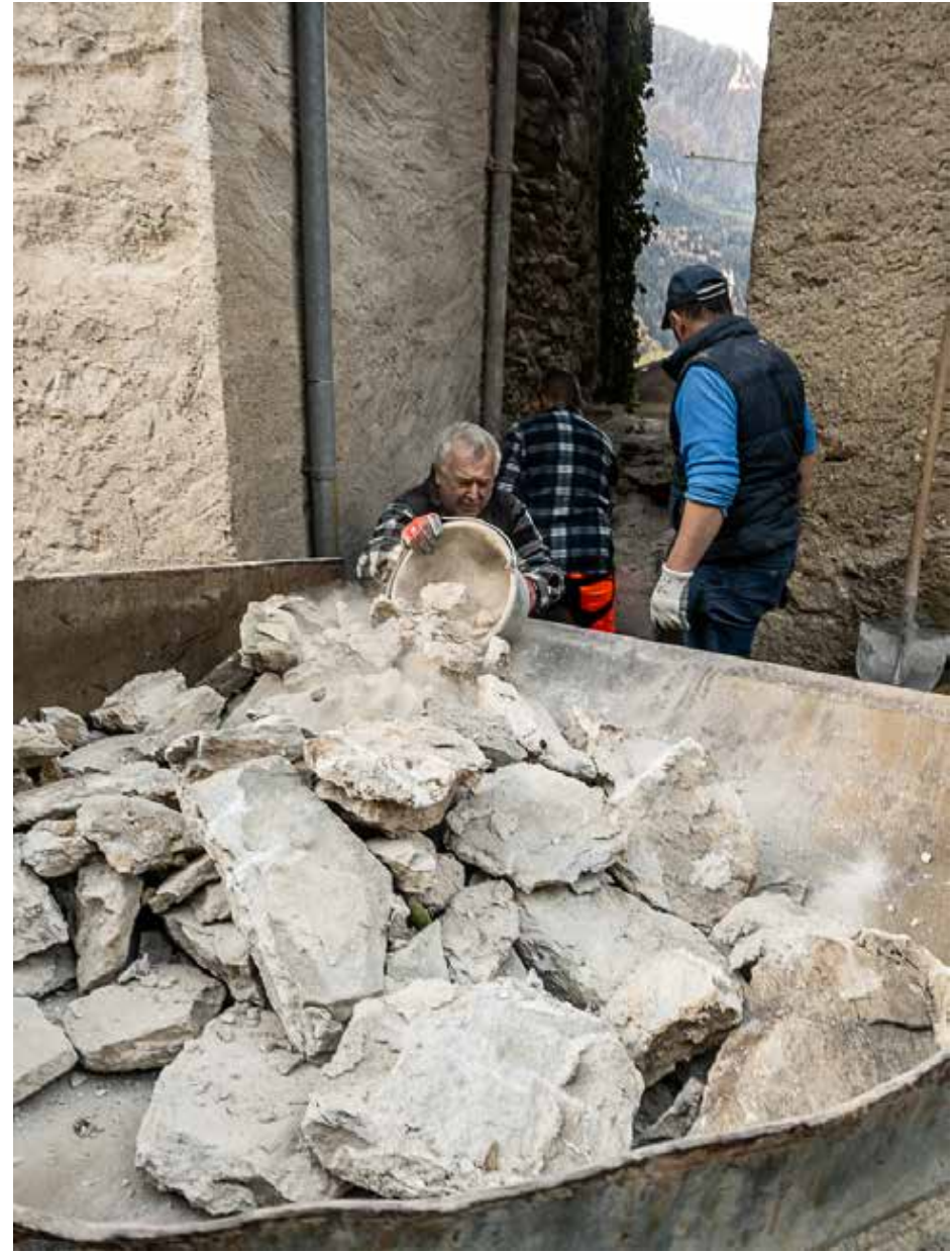
25.10.2022 – Abbruch vom alten Abort
