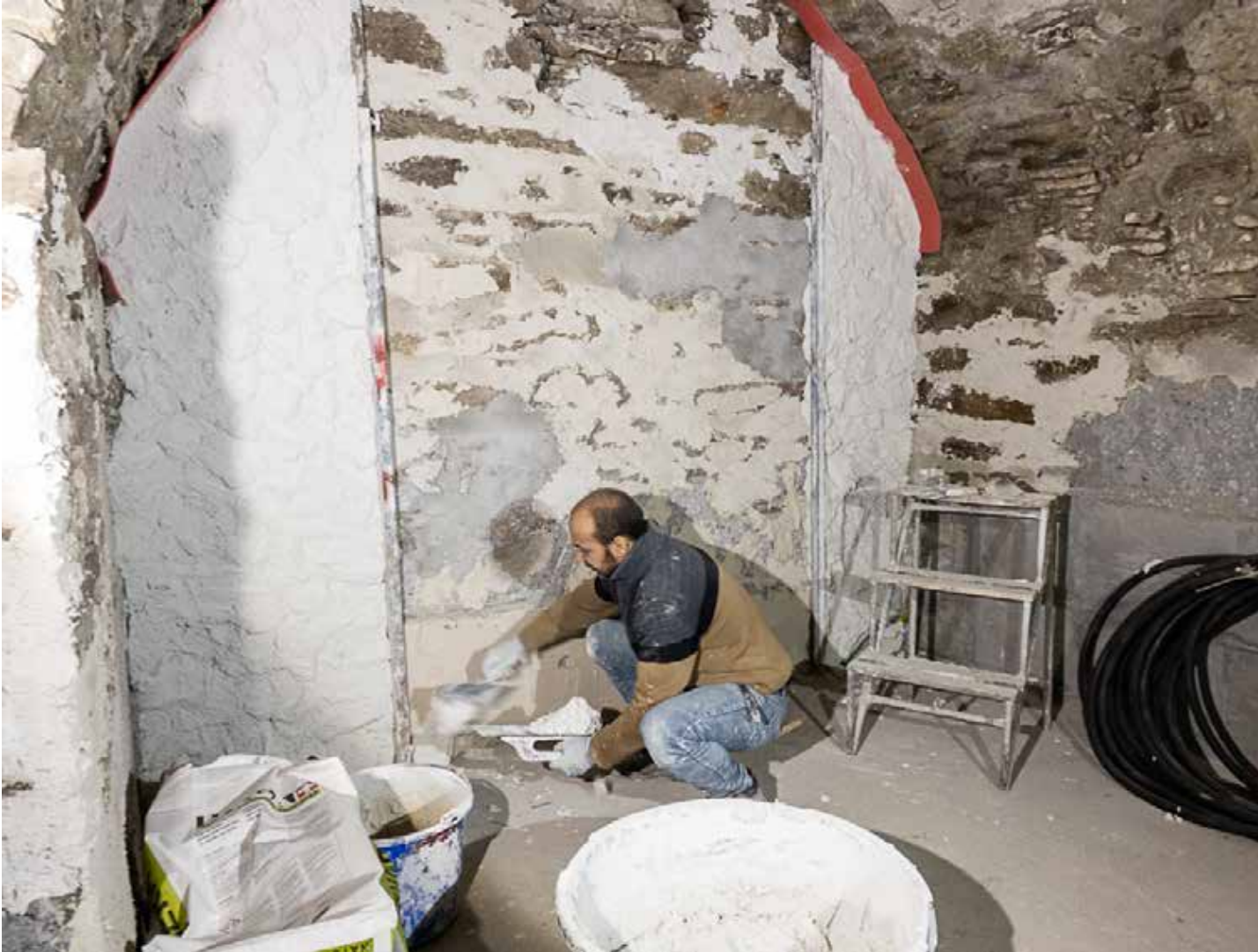
15.12.2022 – UG – Auftragen des Biotherm Wärmedämmputzes
