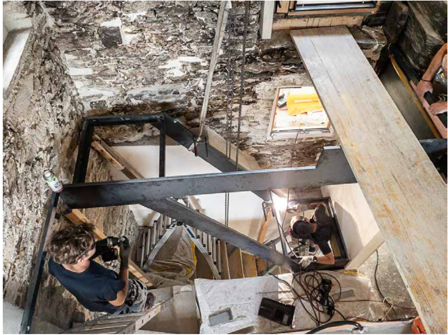
29.06.2023 – OG – Montage Stahltreppe
