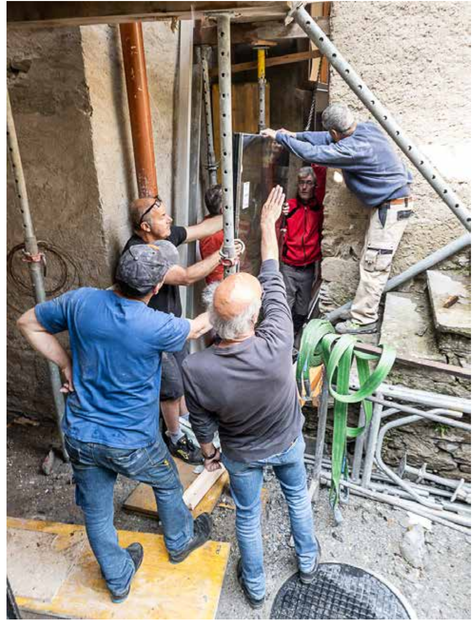
08.06.2023 – EG – Einsetzen der EI30 Gläser (230 kg)
